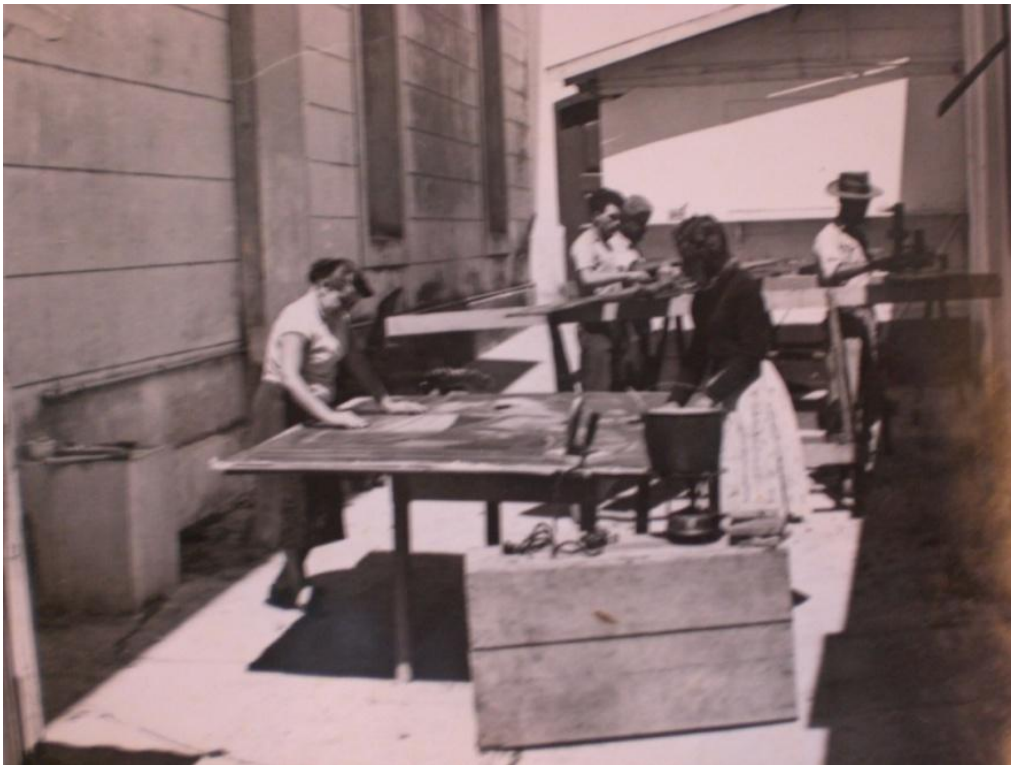
Figura 29 – Aspecto de restauração da Igreja Matriz de Nossa Senhora da Candelária, na cidade de Itu, São Paulo. 1957.
