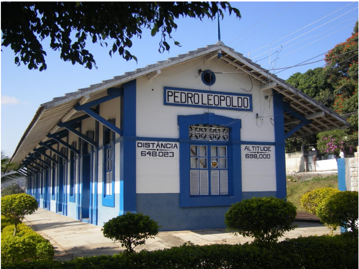
FOTO 06 – Fachada da antiga Estação Ferroviária de Pedro Leopoldo, atualmente Biblioteca Municipal Fonte: Acervo pessoal.
