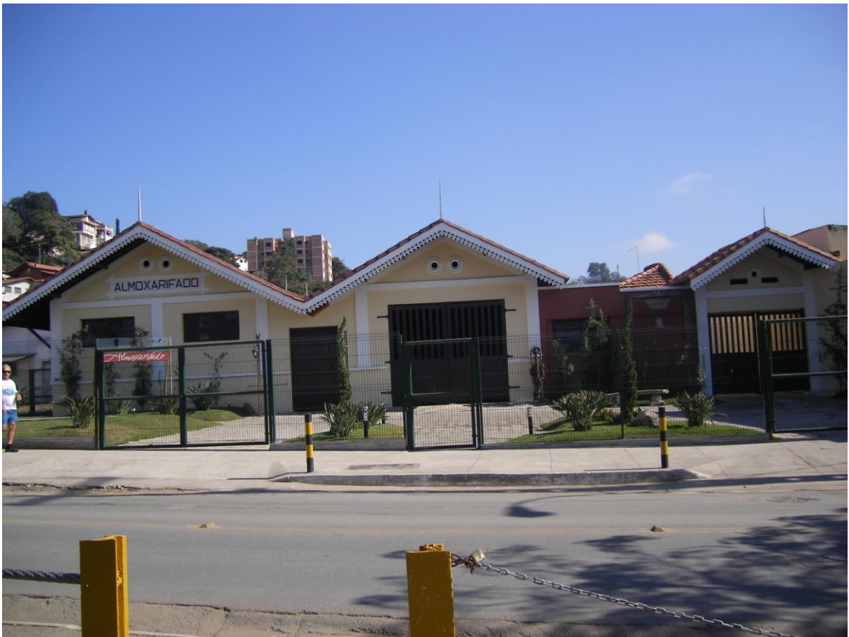
FOTO 04 – Parte da fachada do Almoarifado da antiga Estação Ferroviária de Pedro Leopoldo Fonte: Acervo pessoal.
