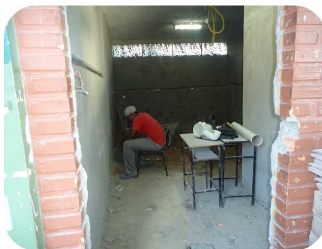
Pedreiros trabalham para melhorar a E.E. Affonso Neves
