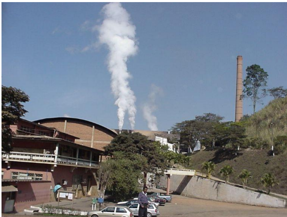
Foto 11 - Usina da Jatiboca.
