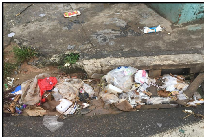
Figura 7: Fotografia de um bueiro obstruído pelo lixo no dia seguinte à feira de domingo.
