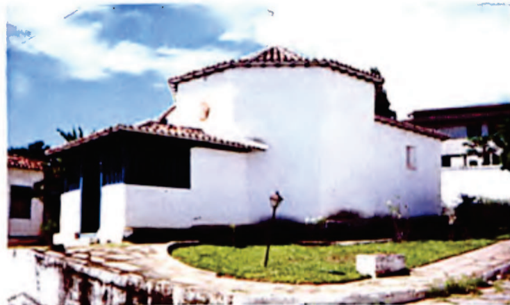
Foto 6 – Capela de São José – Minas Novas/MG
