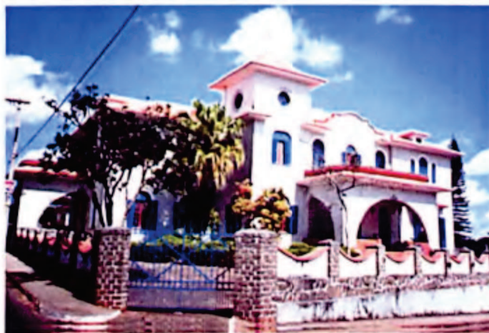
Foto 2 – Palácio Episcopal São José – Campanha/MG
