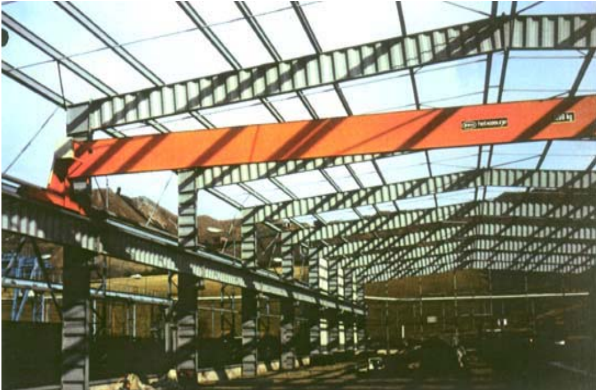
Figura 1.2 – Galpão construído com peças de alma corrugada trapezoidal e chapas planas nas mesas – de Hoop (2003)-a
