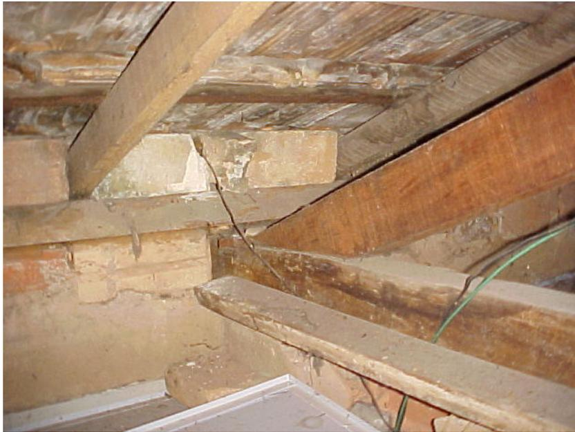
**Foto 6 - Ligação Banzo Inferior-Banzo Superior com dente simples.
