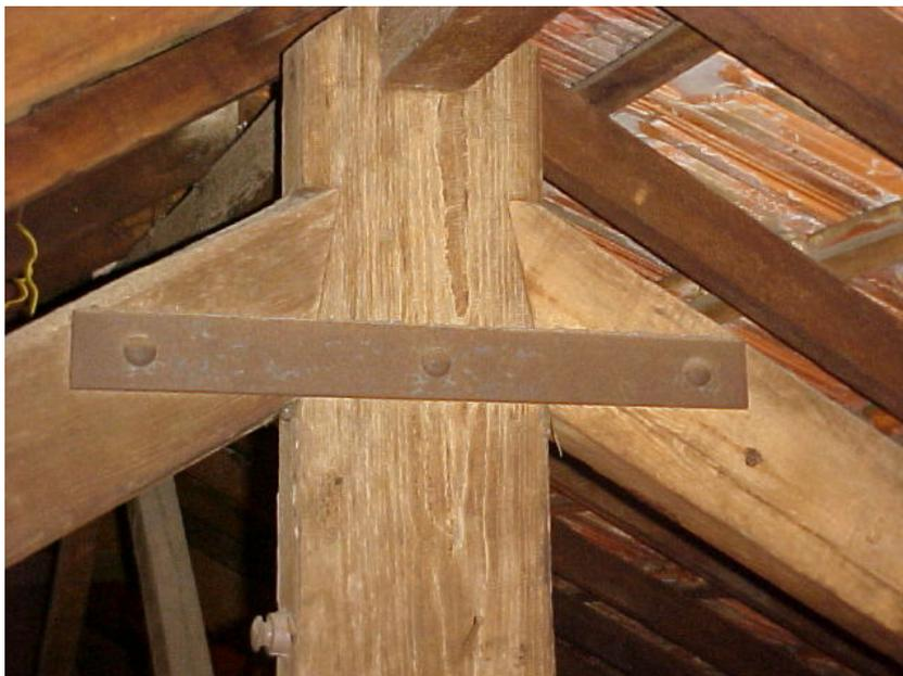
**Foto 3 - Ligação Banzos Superiores-Pontalete com dente simples e conector de segurança em chapa de aço.
