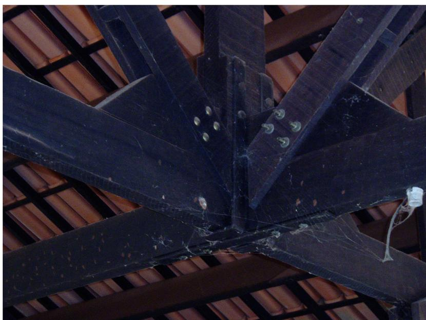
**Foto G3 – Ligação entre Pontaleta, Diagonal e Banzo Inferior da tesoura principal com a meia tesoura.
