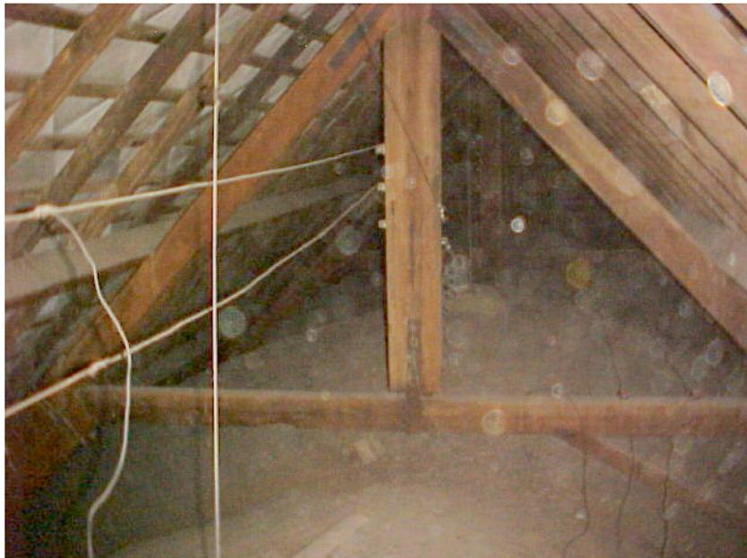
**Foto B1 - Tesoura com Banzo Intermediário e sem Banzo inferior.
