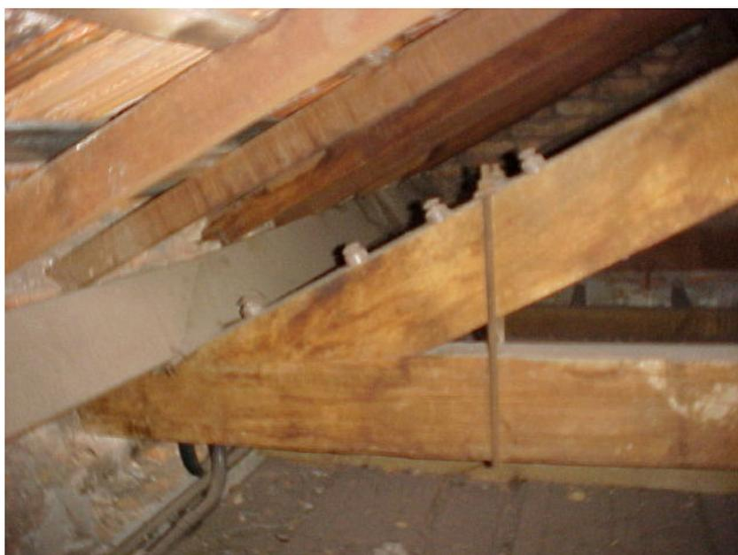
**Foto 1 - Ligação Banzo Inferior-Banzo Superior com dente simples e conector de segurança metálico em forma de grampo.**
