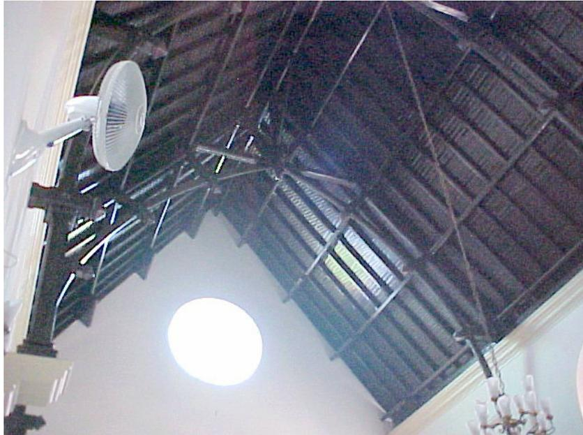
**Foto C4 - Tesoura sem Banzo Inferior em forma de arco ogival.**
