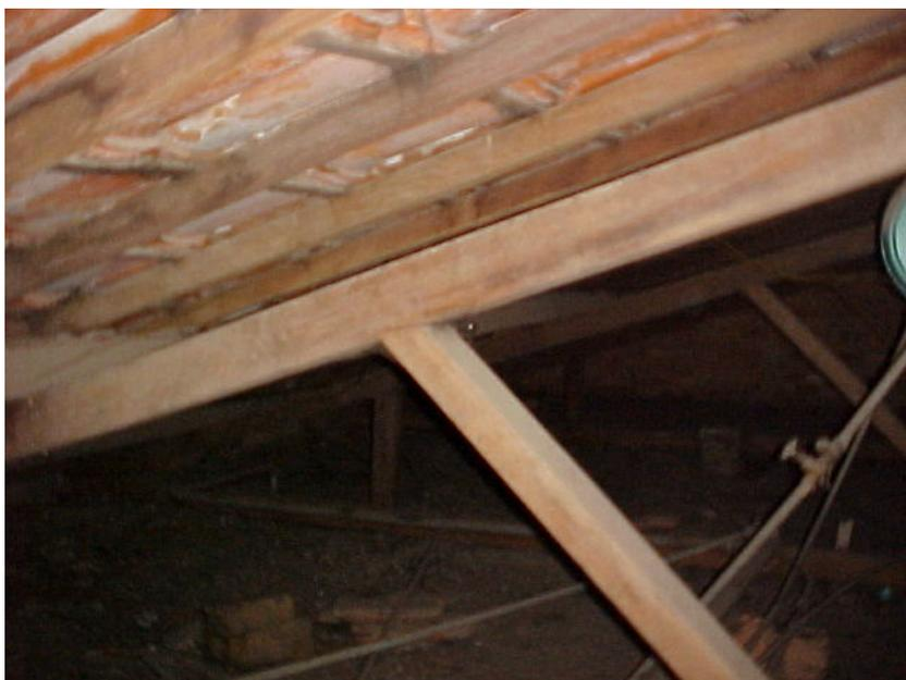
**Foto 18 - Ligação Banzo Superior-Diagonal com dente simples.
