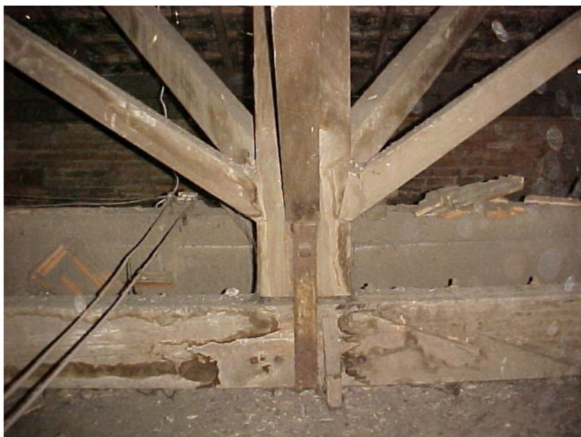
**Foto 27 - Ligações Diagonais-Pontalete com dente simples e Pontalete-Banzo Inferior com abraçadeira metálica e folga entre as peças.
