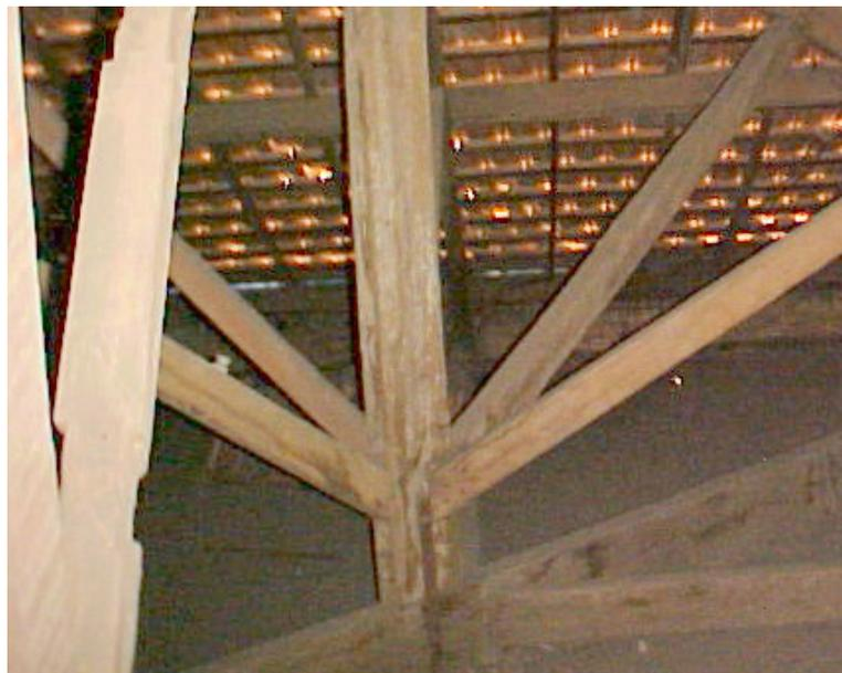
**Foto 16 - Ligação Diagonais-Pontaleta com dente simples e Pontaleta-Banzo Inferior com sistema de respiga e mecha e abraçadeira metálica.**
