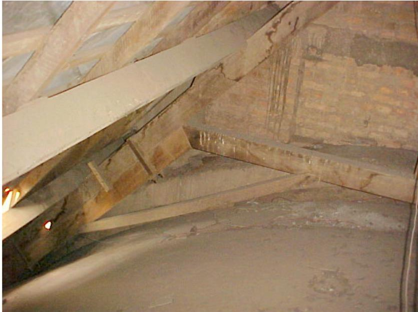
**Foto B2 - Detalhe da terça apoiada no Banzo Superior. Ao fundo empena de alvenaria.**
