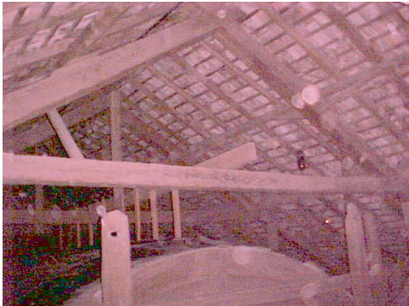
**Foto F1 - Tesoura sem pontaleta. Observar detalhe da ligação entre os Banzos Superiores.
