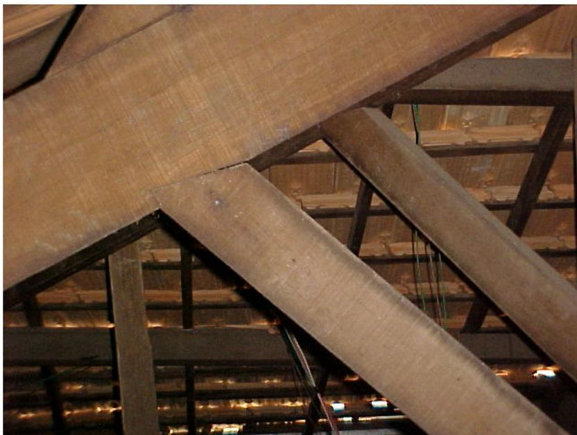
**Foto 28 - Ligação Banzo Superior-Diagonal com dente simples.
