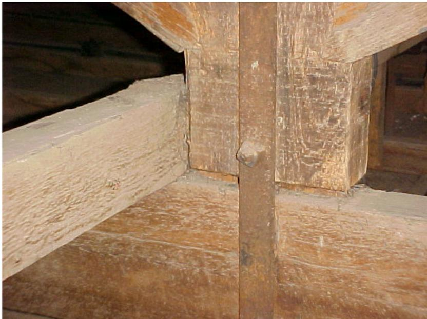
**Foto 5 - Ligação Pontaletes-Banzo Inferior com sistema de respiga e mecha
