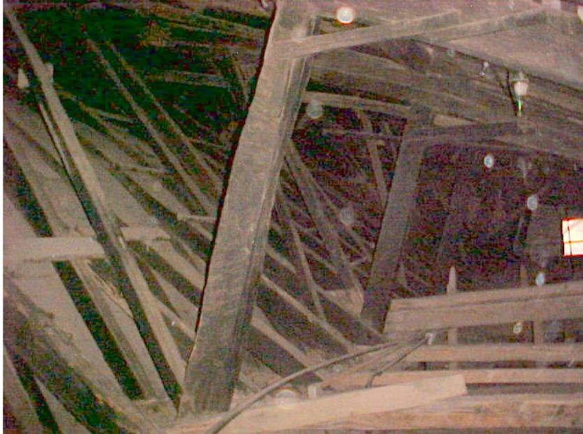
**Foto D2 – Peça vertical inclinada da tesoura.
