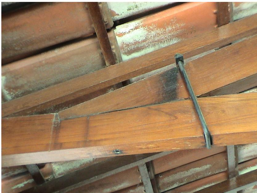
**Foto 31 - Ligação Banzo Inferior-Banzo Superior com dente simples e conector metálico em forma de grampo.**
