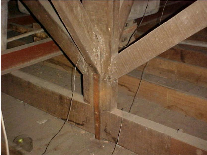
**Foto 30 - Ligações Diagonais-Pontalete com dente simples e Pontalete-Banzo Inferior com sistema de respiga e mecha e abraçadeira metálica.
