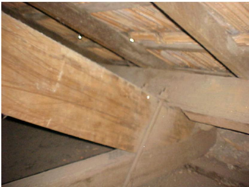
**Foto 13 - Ligação Banzo Inferior-Banzo Superior com ente simples e conector metálico do tipo grampo.
