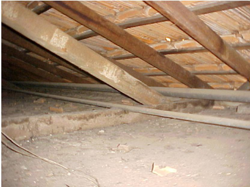
**Foto 10 - Ligação Banzo Inferior-Banzo Superior com dente simples.
