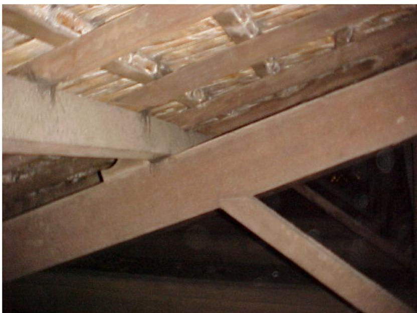
**Foto 26 - Ligação Banzo Superior-Diagonal com dente simples.**
