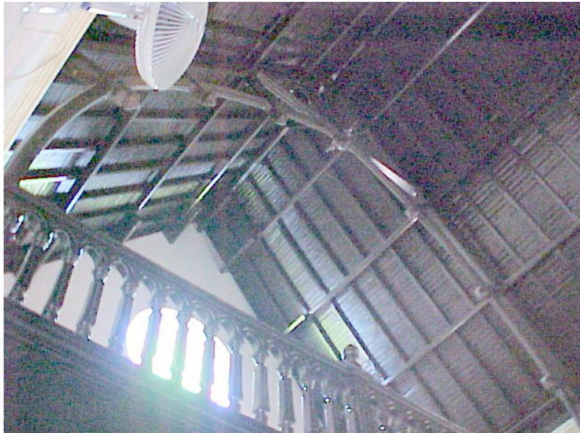
**Foto C1 - Tesoura de madeira em forma de arco ogival.
