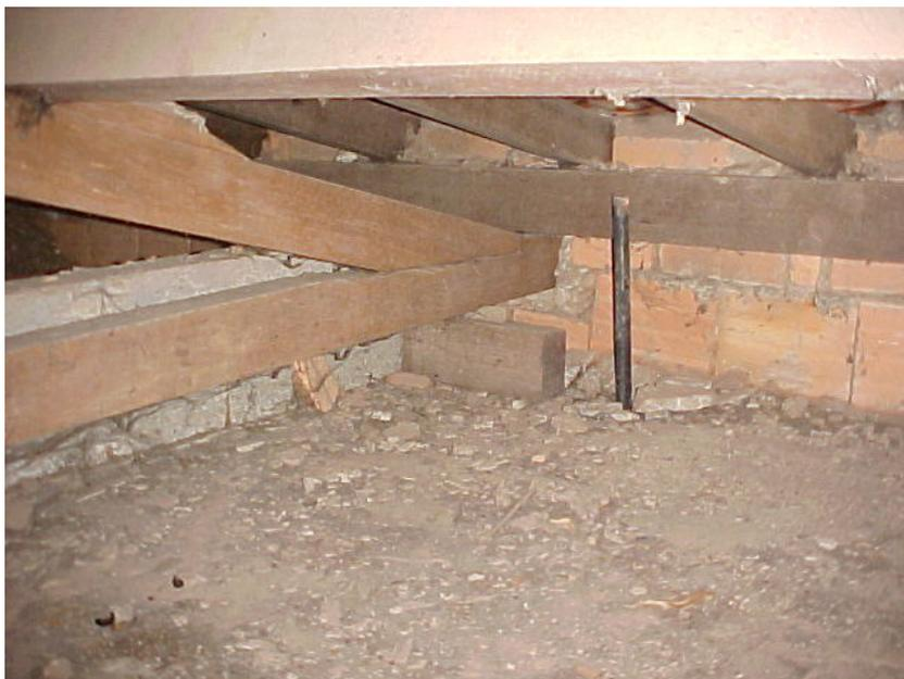
**Foto 17 - Ligação Banzo Inferior-Banzo Superior com dente simples.
