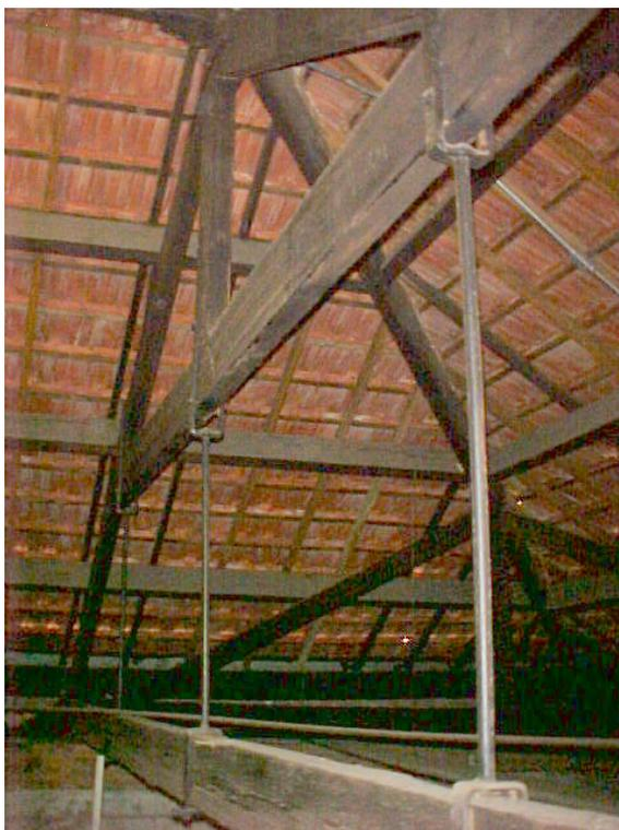
**Foto A1 - Tesoura com Banzo Intermediário em madeira e verticais em tirantes de aço.**
