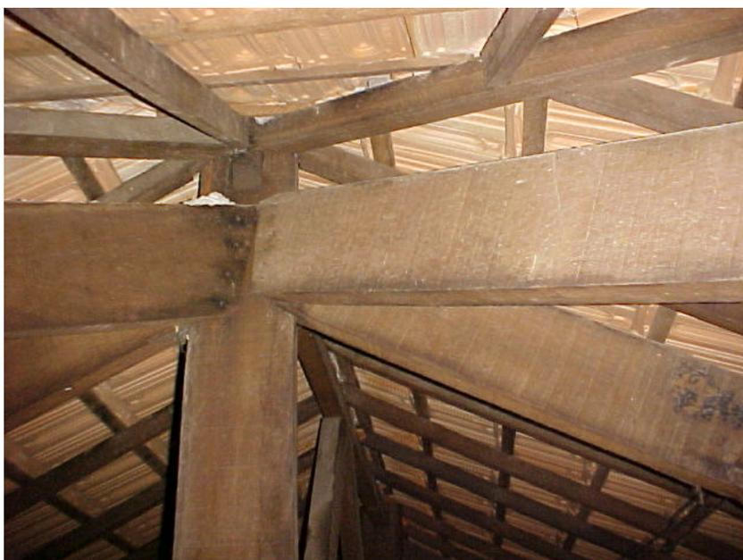
**Foto 29 - Ligação Banzo Superior-Pontaleta ligados através de pinos metálicos.
