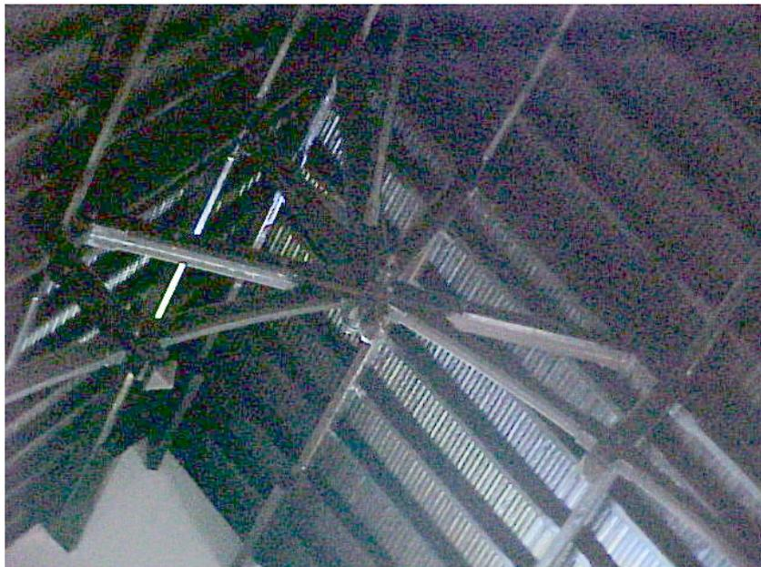
**Foto C5 - Detalhe da ligação superior da tesoura ogival.**
