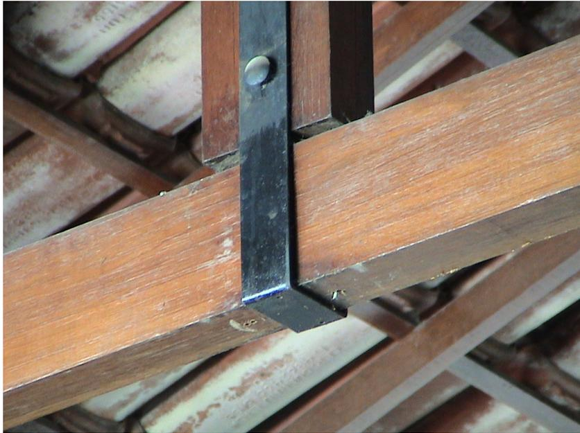
**Foto 33 - Ligação Pontaete-Banzo Inferior com sistema de abraçadeira metálica e folga entre as peças.
