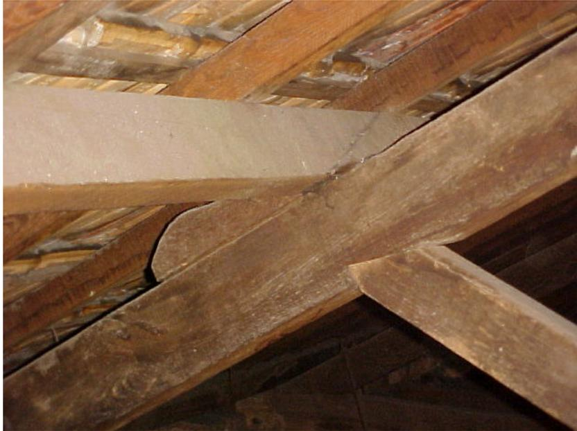
**Foto 2 - Ligação Banzo Superior-Diagonal com dente simples.
