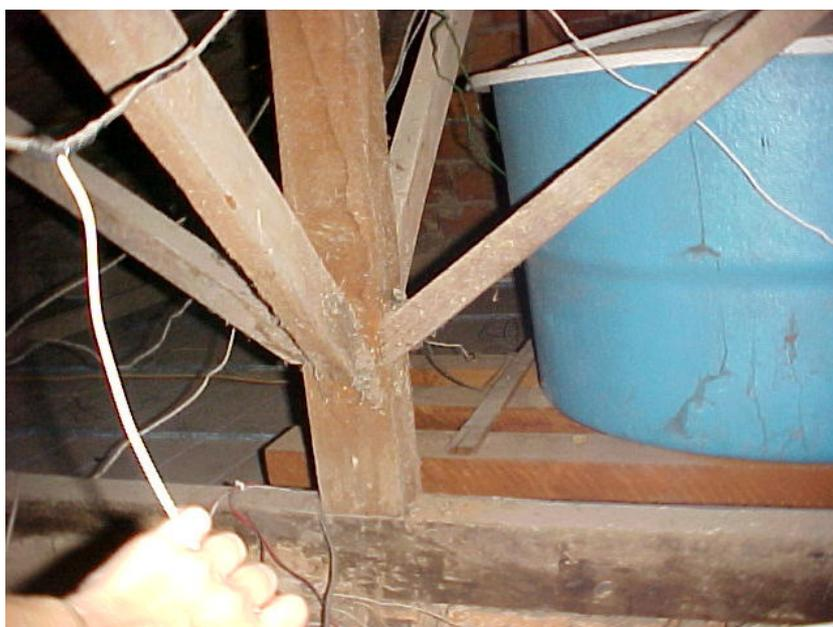
**Foto 9 - Ligações Diagonais-Pontaleta com dente simples e Pontaleta-Banzo inferior com ausência de folga entre as peças.**
