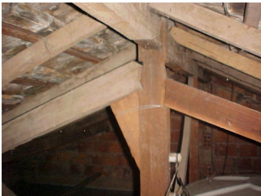
**Foto 8 - Ligação Banzos Superiores-Pontaleta com dente duplo apoiado em cunha de madeira no lado esquerdo.**
