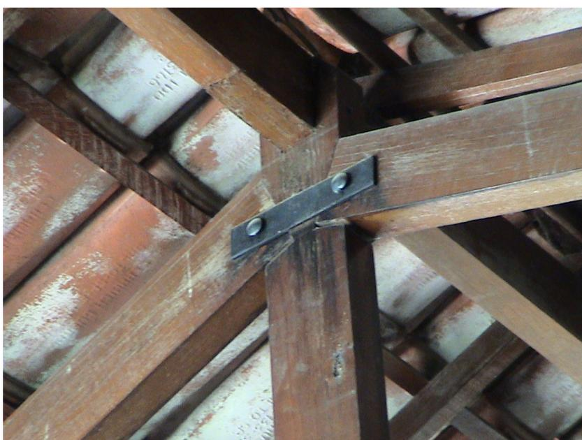
**Foto 32 - Ligação Banzos Superiores-Pontaletes com dente simples e conector metálico em forma de chapa.**
