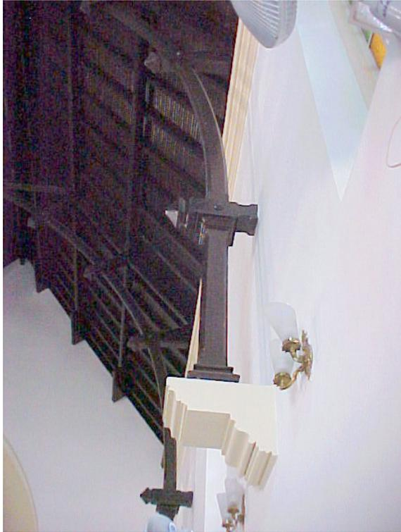
**Foto C2 - Apoio do Banzo Superior (consolo de concreto).**
