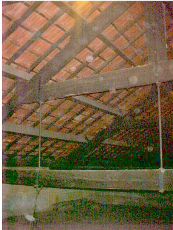
**Foto A2 - Detalhe do Banho Inferior atirantado ao Banho Intermediário.**
