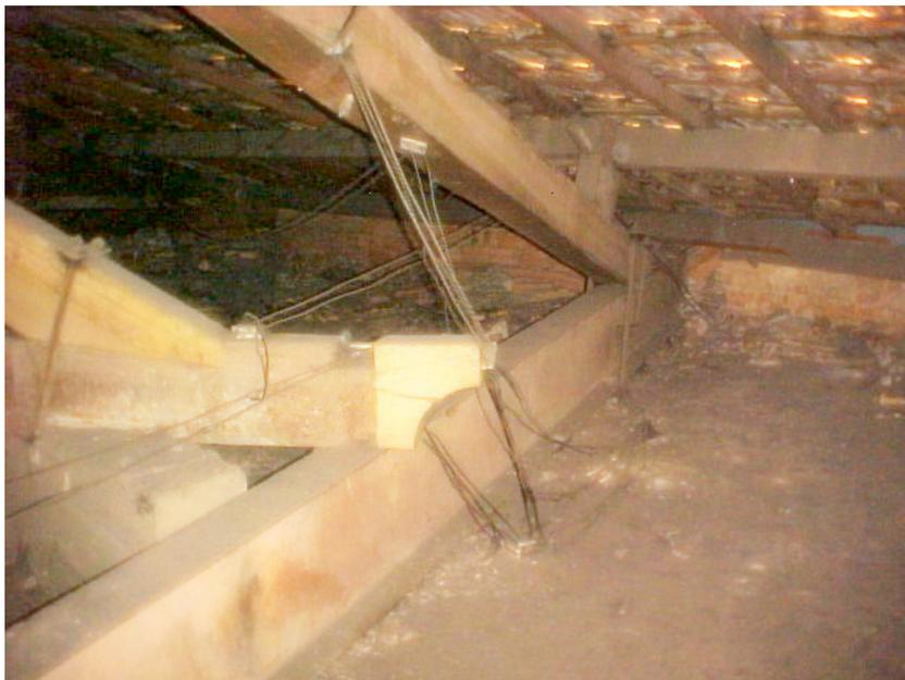
**Foto 25 - Ligação Banzo Inferior-Banzo Superior com dente simples e conector de segurança do tipo grampo.**
