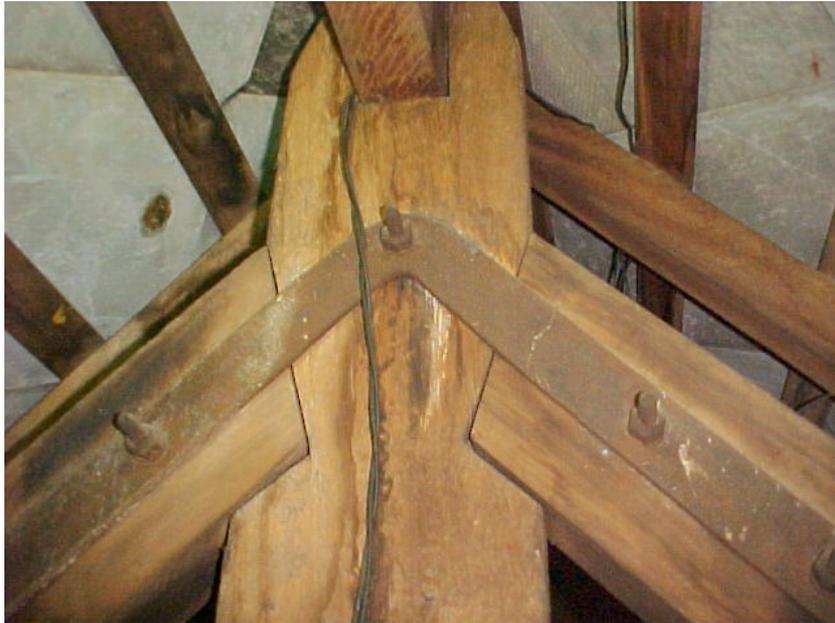
**Foto B4 - Ligação dos Banzos Superiores-Pontaleta com dente simples e chapa metálica.**
