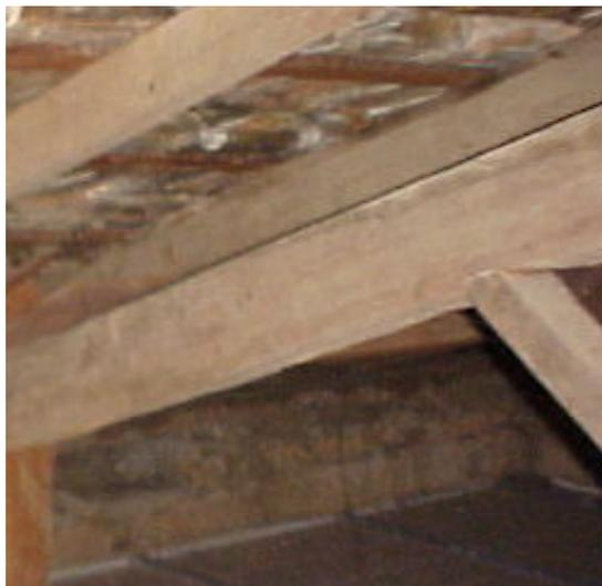
**Foto 7 - Ligação Banzo Superior-Diagonal com dente simples.
