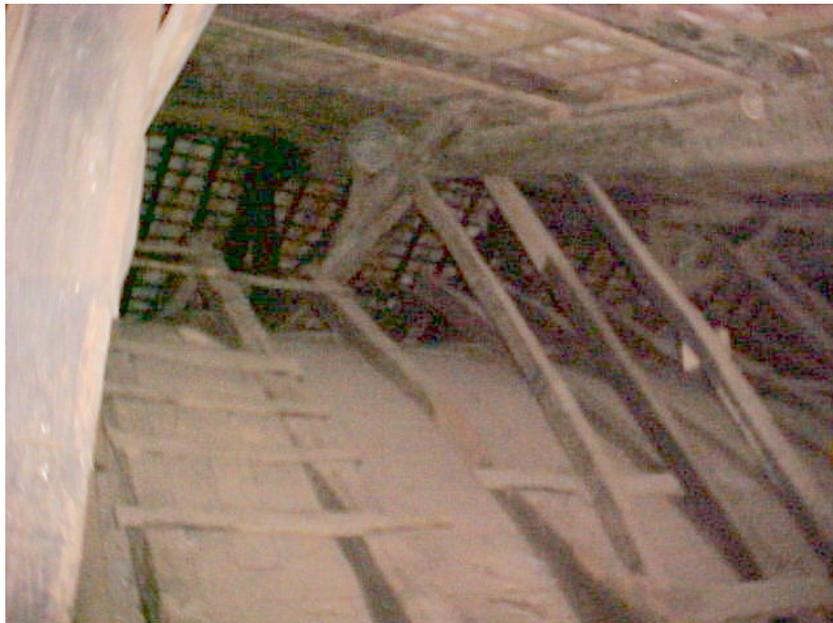
**Foto D1 –Tesoura com Banzo Intermediário e verticais inclinadas.
