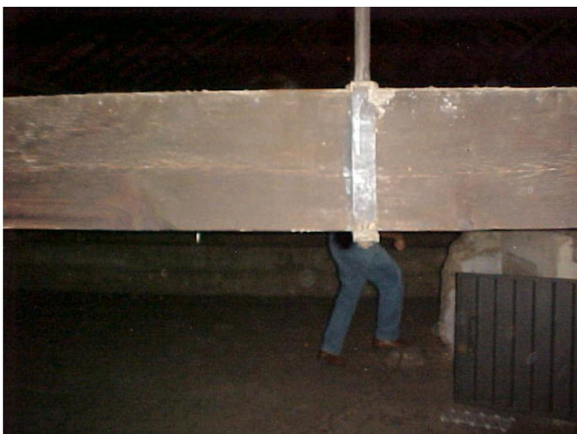
**Foto A5 - Detalhe da ligação do tirante com o Banzo Inferior.**
