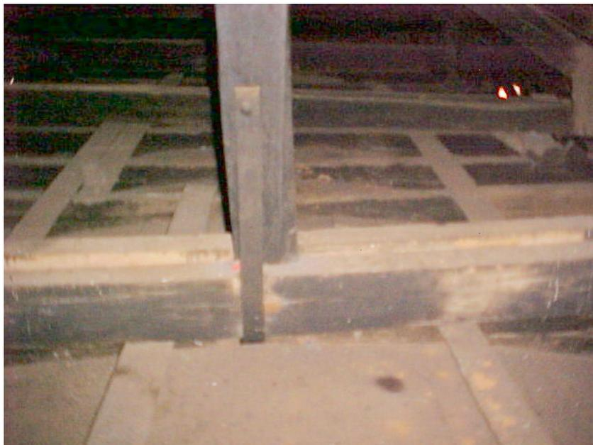
**Foto D5 – Ligação Pontaete-Banzo inferior (peça dupla), com abraçadeira metálica.**
