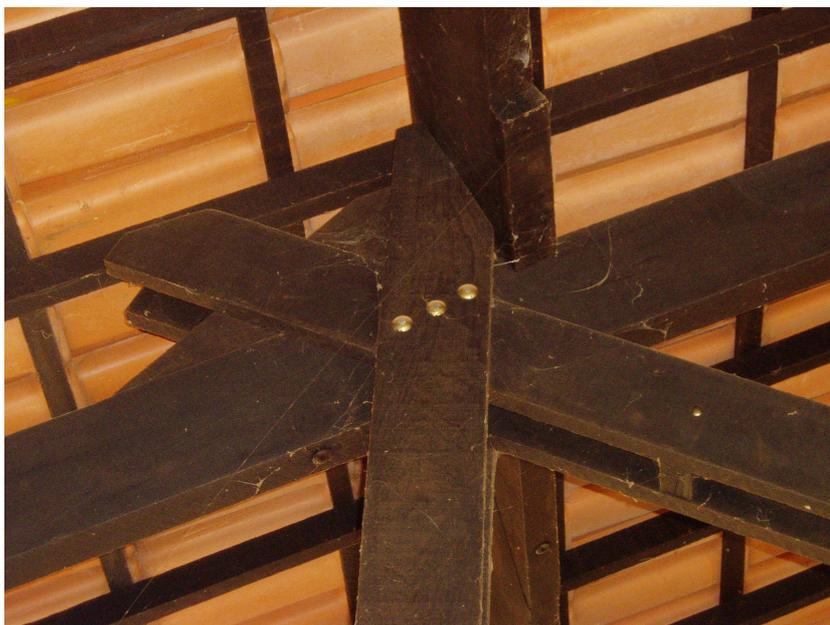
**Foto G2 – Ligação entre Banzo Superior, Diagonal (peça dupla) e Montante (peça dupla).
