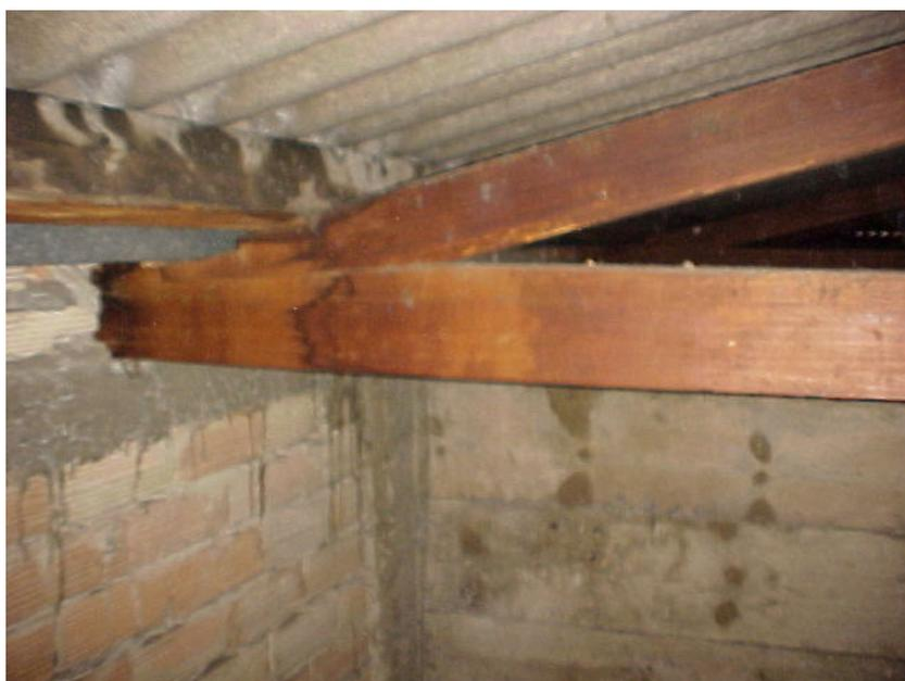
**Foto 21 - Ligação Banzo Inferior-Banzo Superior com dente simples.
