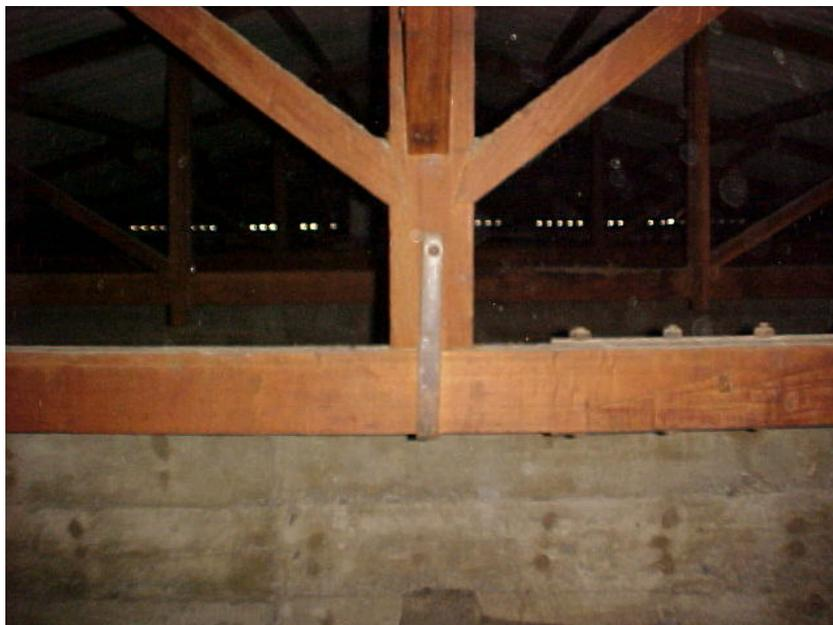
**Foto 24 - Ligações Diagonais-Pontaletes com dente simples e Pontaletes-Banzo Inferior unidos por abraçadeira metálica.**
