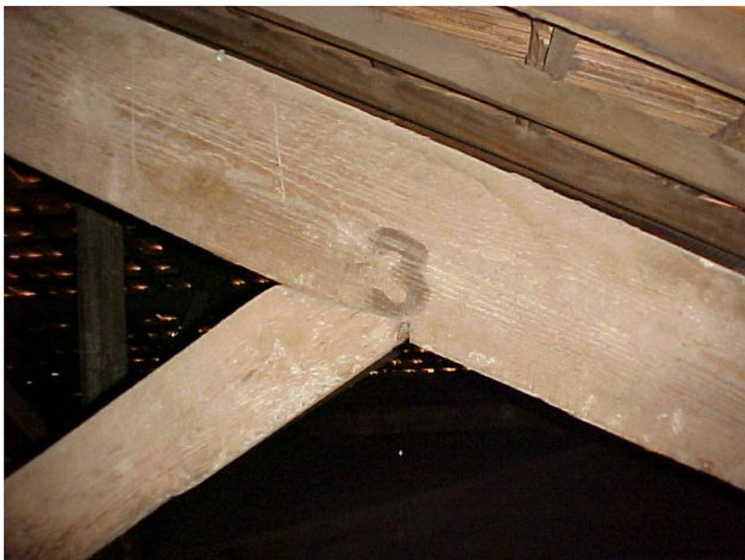
**Foto 14 - Ligação Diagonal-Banzo Superior com dente simples.
