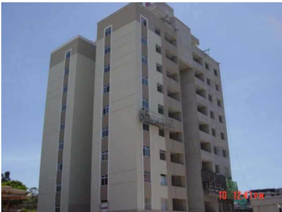
Figura 1.7 – Edifício Província de Ravena
