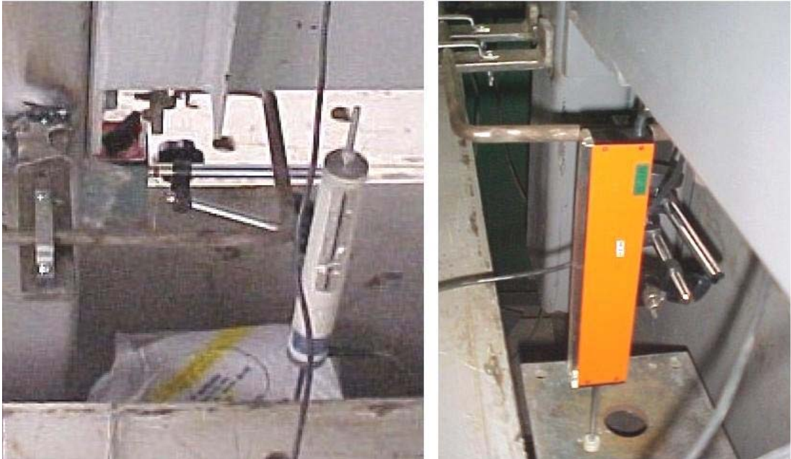
FOTO 3.5 – Medidores do deslocamento vertical do pilar (DT 100 ).
