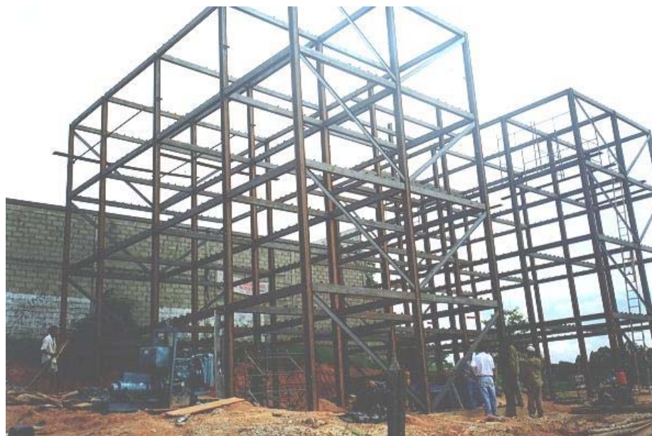
FOTO 1.2 – Visão geral da estrutura de um prédio do Sistema COHAB-MG.
