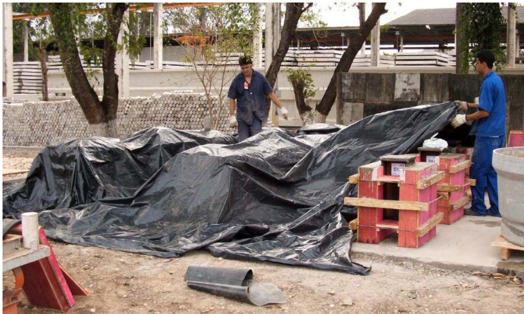
FIGURA 3.28 – Cura do concreto.
