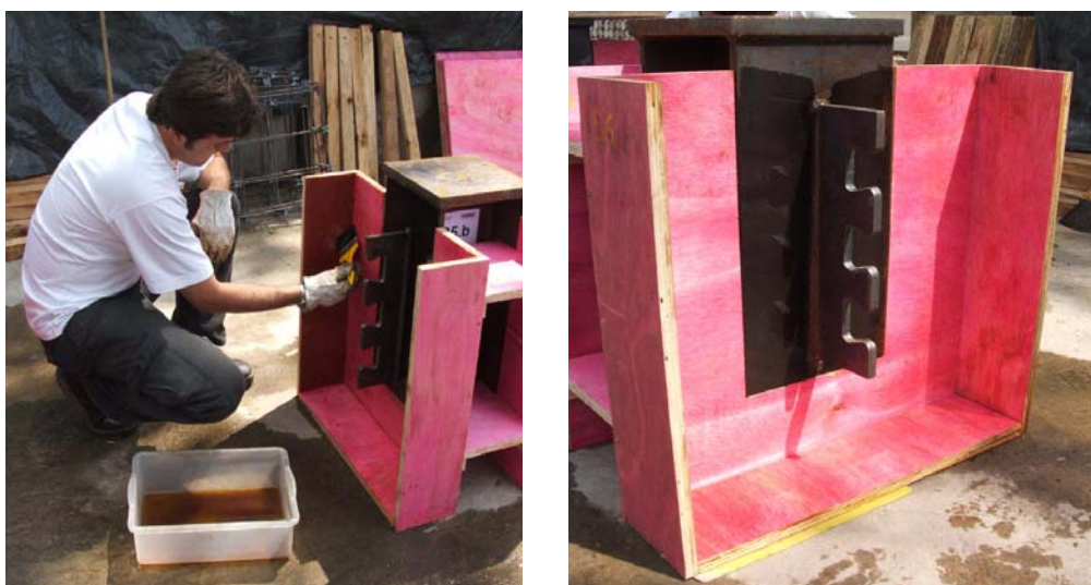
FIGURA 3.24 – Aplicação do desmoldantes nas fôrmas.
