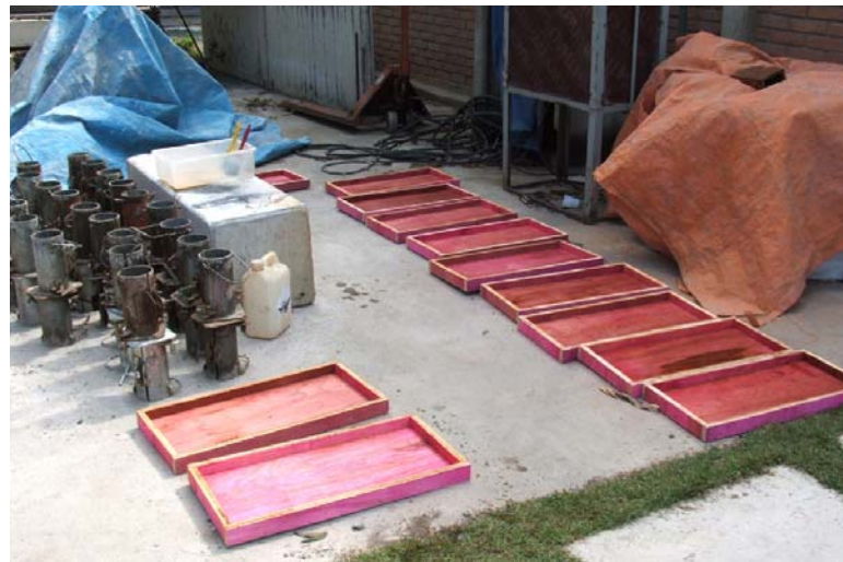
FIGURA 3.21 – Aplicação do desmoldante nas fôrmas da pré-laje.
