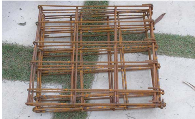
FIGURA 3.19 – Aspecto das armaduras dos modelos.
