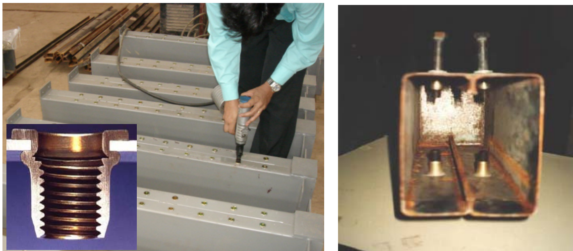
FIGURA 1.9 – Conector com rebite com rosca interna e parafuso sextavado (OLIVEIRA, 2001).
