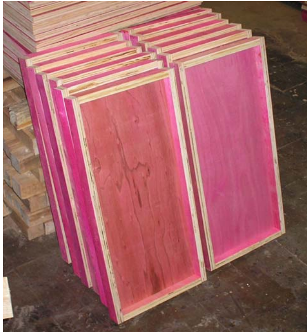
FIGURA 3.16 – Detalhes da fôrma para pré-laje de concreto.
