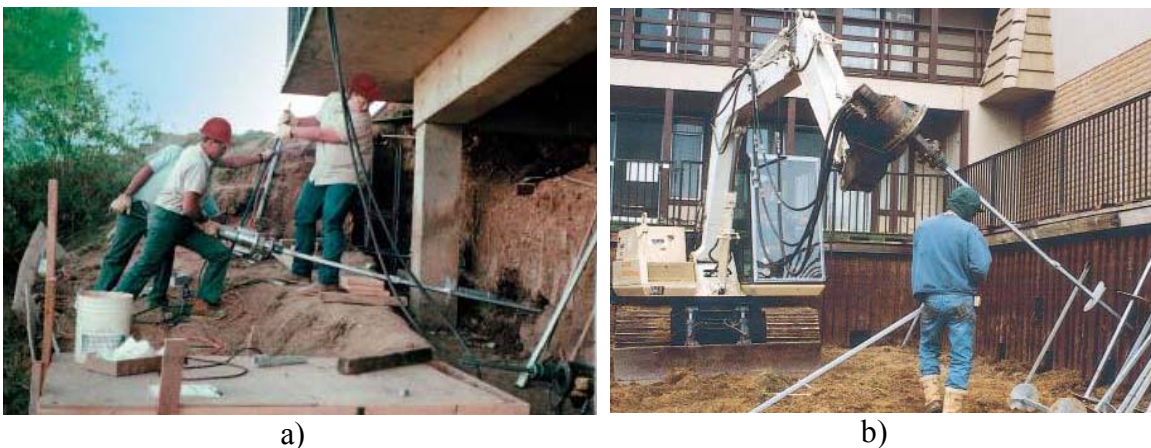
a) b) FIGURA 2.7 a) Instalação manual; b) Instalação mecânica. Fonte: A.B.CHANCE, 2004, p. 6 e 7.
