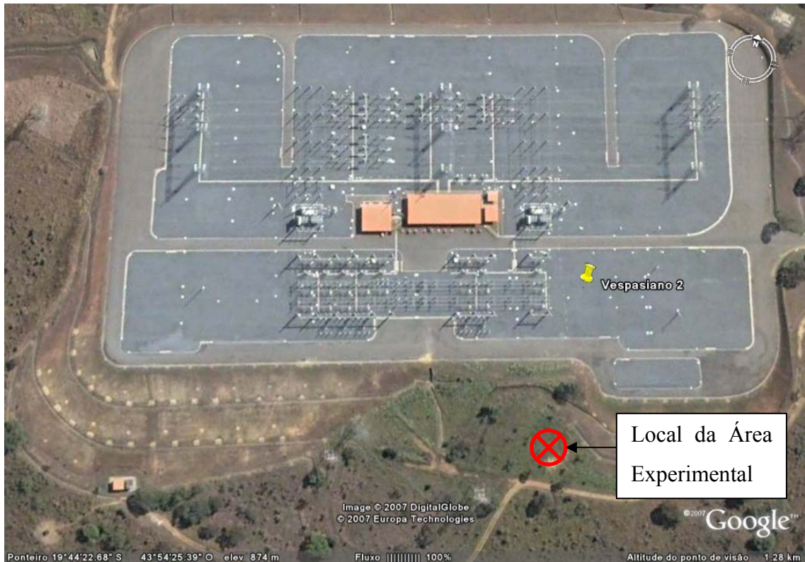
FIGURA 5.1 Imagem da Subestação Vespasiano 2, com identificação da localização da área experimental.
