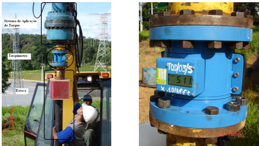
FIGURA 5.6 Sistema de Aplicação de Torque, Torquímetro digital e Estaca.
