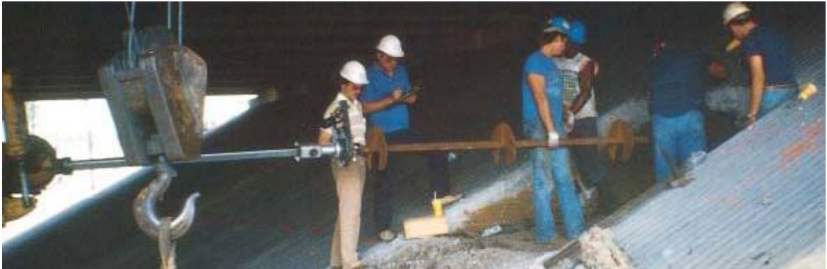
FIGURA 2.6 Instalação debaixo de um viaduto no sentido horizontal. FONTE: A.B.CHANCE, 2004, p. 6.
