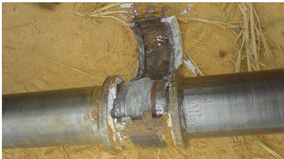
FIGURA 6.26 Interior da proteção após as provas de carga.
