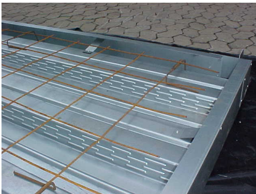
Figura C.1 – Detalhe da tela soldada
