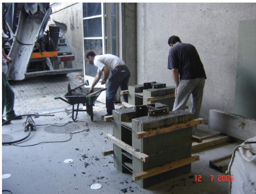
FIGURA 3.53 – Concretagem dos modelos X1 e X2 no LEST/UM.
