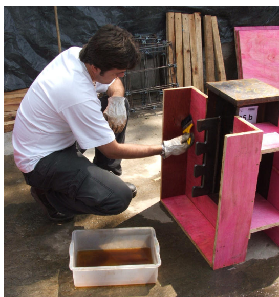
FIGURA 3.84 – Aplicação de desmoldante nas fôrmas - série D.
