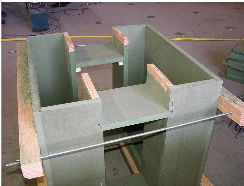
FIGURA 3.8 – Aspecto da fôrma montada.
