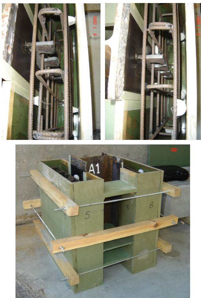
FIGURA 3.52 – Montagem dos modelos X1 e X2 – armaduras colocadas e modelo pronto para concretagem.
