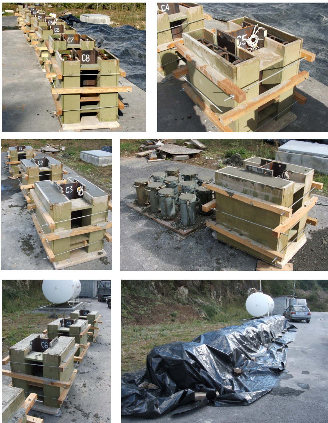
FIGURA 3.68 – Concretagem dos modelos da série C.
