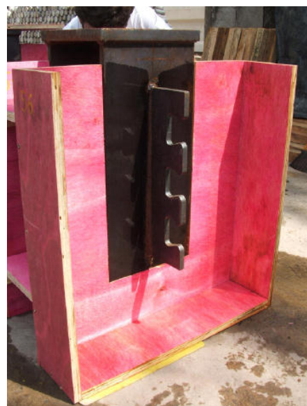
FIGURA 3.84 – Aplicação de desmoldante nas fôrmas - série D.
