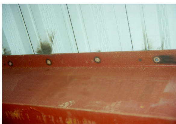
(c) mesas perfuradas – chapa de 6,3 mm e stud com 19 mm de diâmetro
