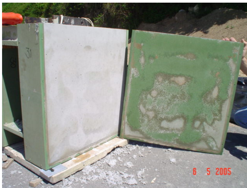
FIGURA 3.23 – Aspecto do concreto e da fôrma após desmoldagem (fôrma de MDF hidrófugo com verniz selador e desmoldante da SIKA).
