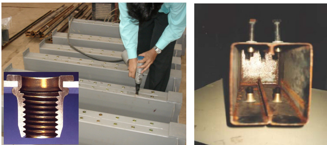
FIGURA 2.12 – Rebite com rosca interna e parafuso sextavado (OLIVEIRA, 2001).
