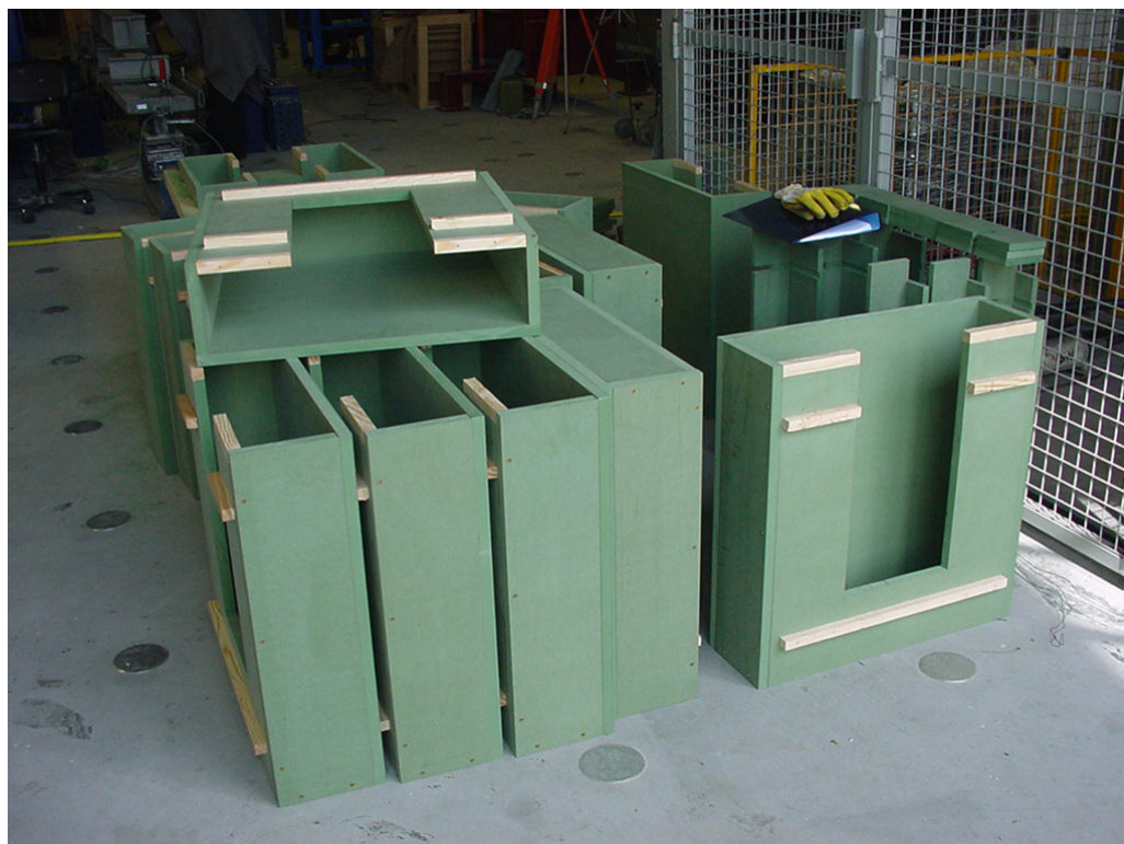
FIGURA 3.7 – Aspecto das fôrmas para as lajes.
