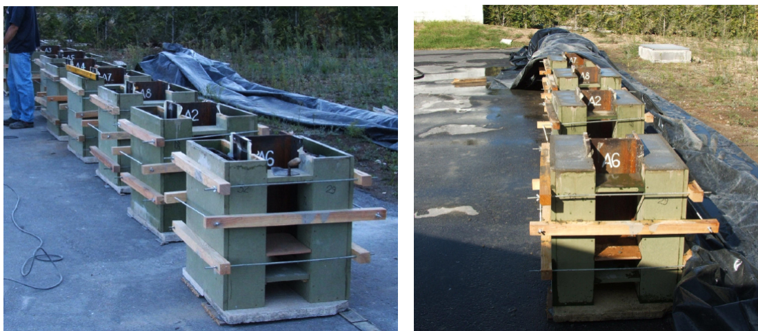
FIGURA 3.20 – Modelos da série A, antes e depois da concretagem.
