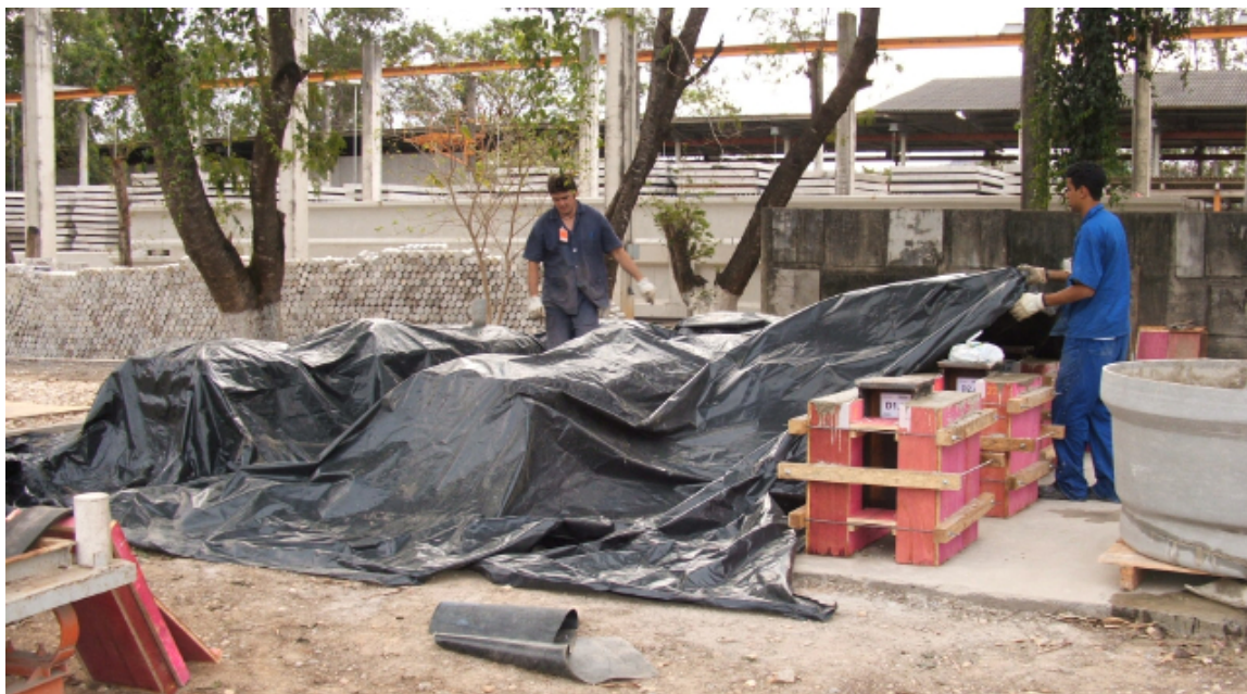
FIGURA 3.92 – Proteção com lona plástica após a concretagem – série D.
