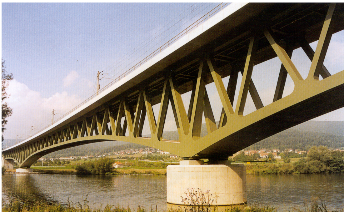
FIGURA 2.14 – Ponte sobre o Rio Main, em Nantenbach (Alemanha). Suporta duas linhas de TGV e possui 208 m de vão livre.
