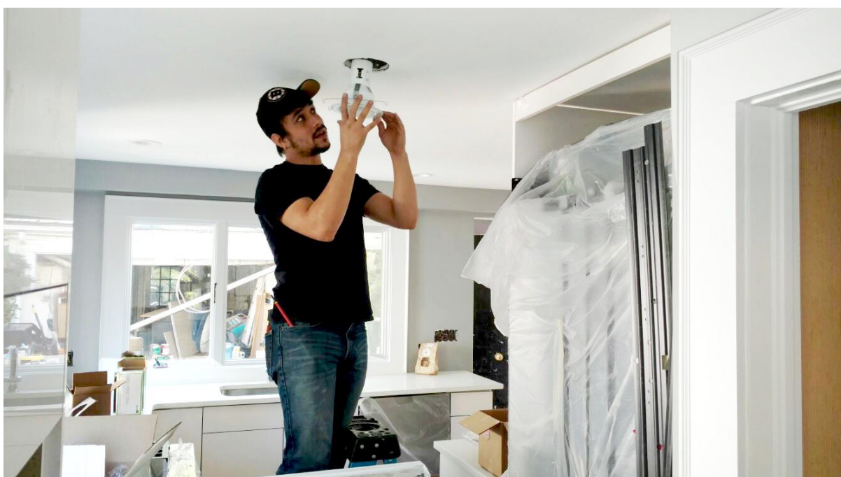
Figura 39 – Fazendo instalações de luminárias em Wayland, MA, em agosto de 2016. Foto: Davi Ribeiro. Fonte: Arquivo Pessoal.
