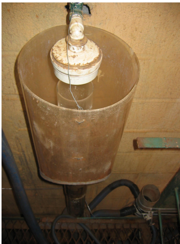
Figura 4.7 – detalhe do topo da coluna com seu sistema de injeção de água de lavagem.
