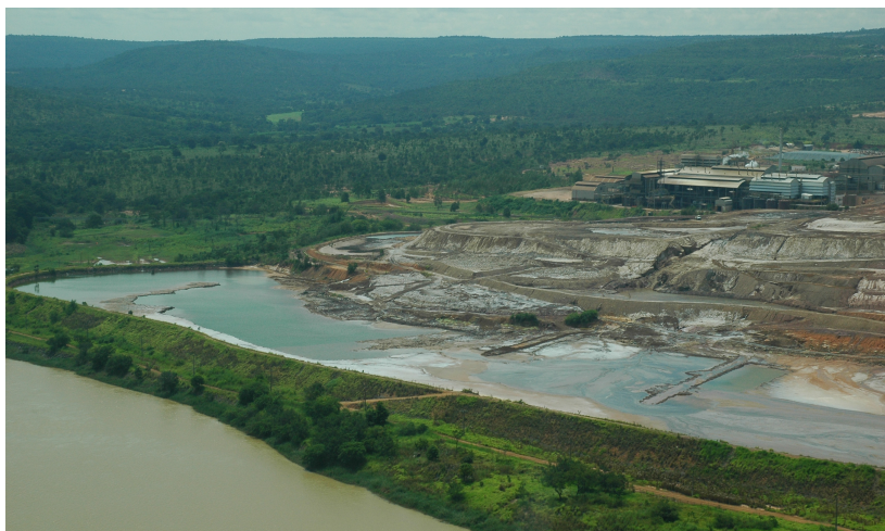
Figura 5.6: Foto do aterro industrial e Dique de Segurança, da Votorantim Metais Zinco – Unidade de Três Marias.
