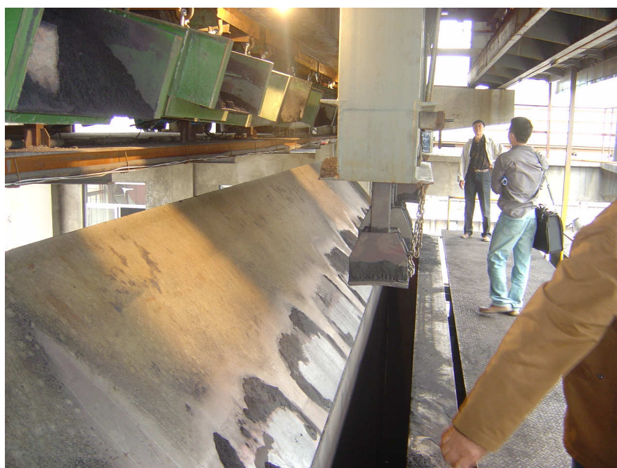
FIGURA 3.23: Martelos mecânicos para uma coqueria Convencional com Compactação de Carga (18)
