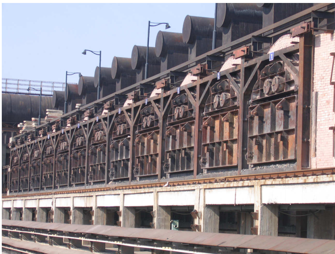
Figura 3.20: Imagem da Coqueria Heat Recovery com Stamp Charging ,na San Jia Coking Company, Cidade de Gao Ping, Província de Shanxi –China (Setembro de 2007) (17)
