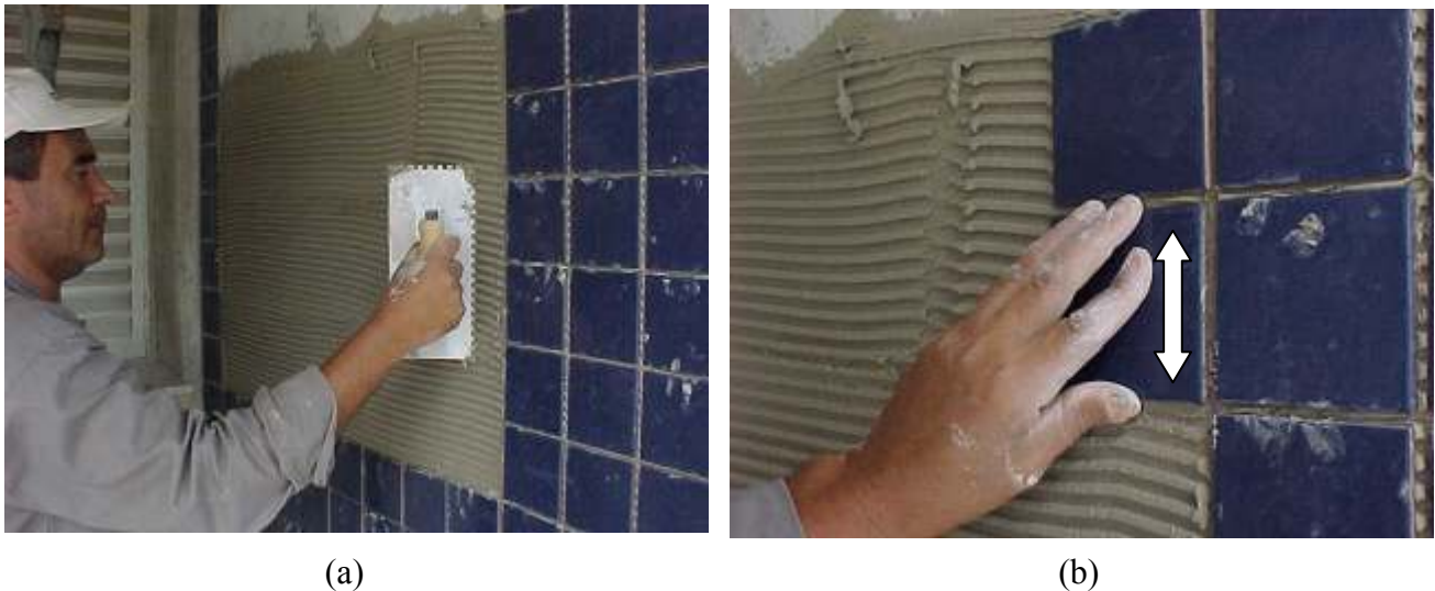
Figura 3.2 – Formação dos cordões em argamassa colante com o lado denteado da desempenadeira (a) seguida da aplicação da cerâmica através de movimentos de vai-e-vem perpendiculares aos cordões da argamassa colante para permitir formação de camada contínua no verso da placa (MANSUR et al., 2004).
