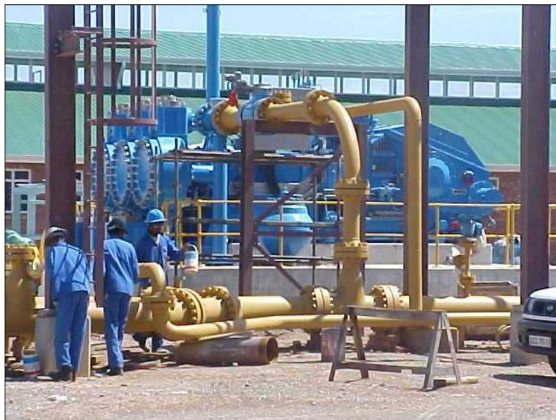
Figura 3.6: Sistema de bombeamento de deslocamento positivo. (Vietti e Dunn, 2002)
