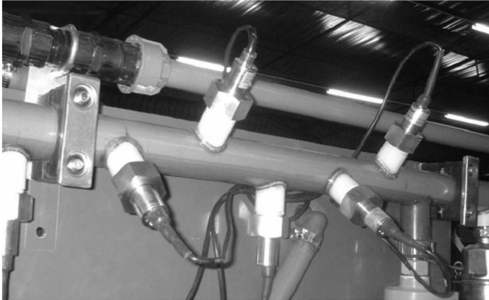
Figura 3.51: Uso de sensores térmicos para controle do transporte de pasta mineral.
