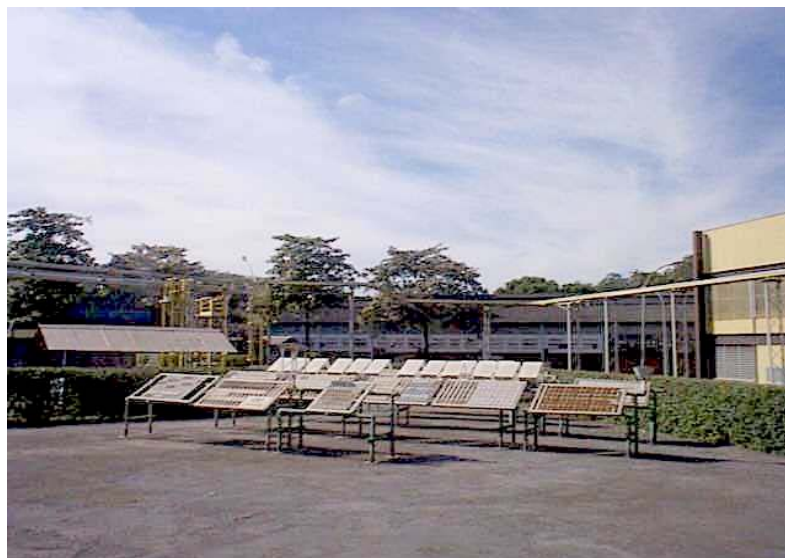
FIGURA 31 - Miniestação de Corrosão da Usiminas para a realização de testes de campo com aspersão de solução salina, segundo norma ISO 11.474 (62) .
