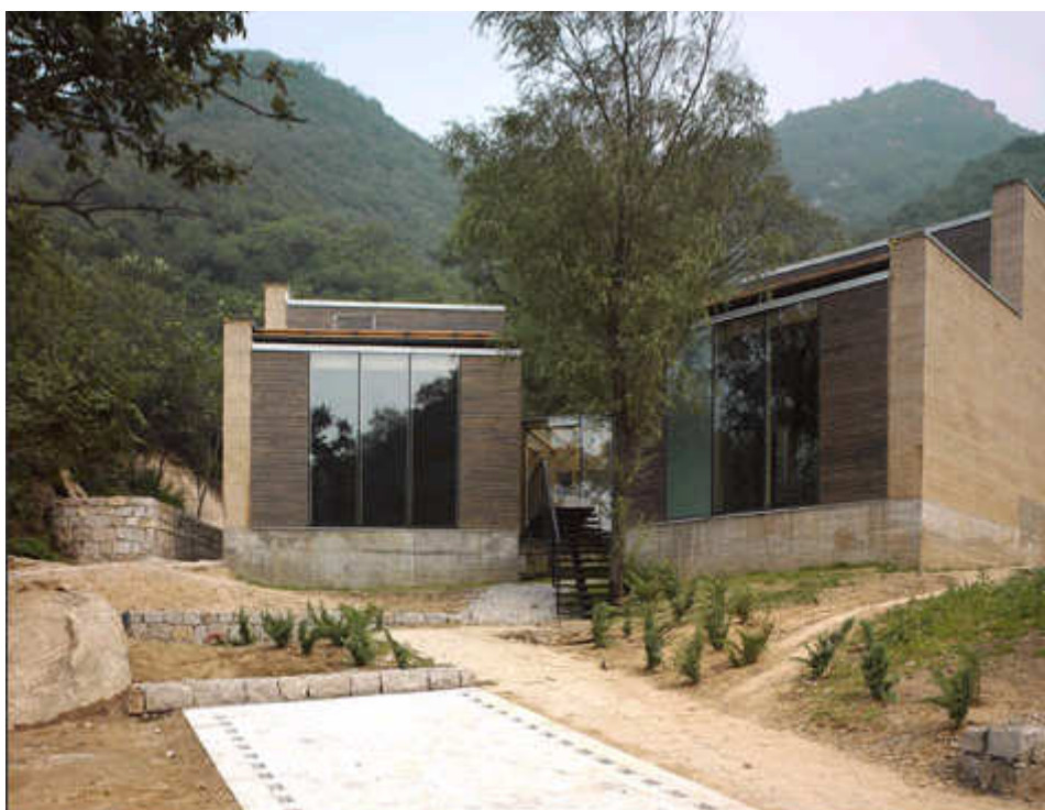
Figura 1.5 – A casa Split localizada ao norte de Beijing, na China. Sua estrutura é feita madeira laminada e paredes de rammed earth . Produzindo um mínimo impacto ao meio ambiente ( http://archrecord.construction.com/china , 2005).
