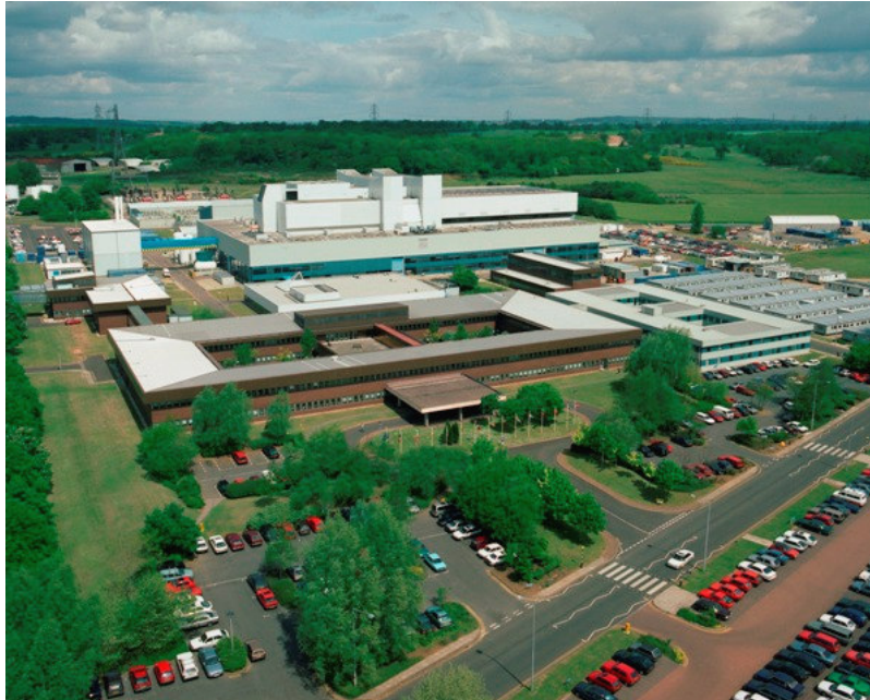
Figura 1.6 - Visão geral das instalações do JET.
