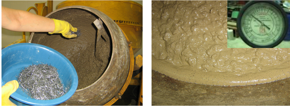
Figura 4-17 – Concreto com adição de fibras curtas e 13% de ar incorporado ao concreto.
