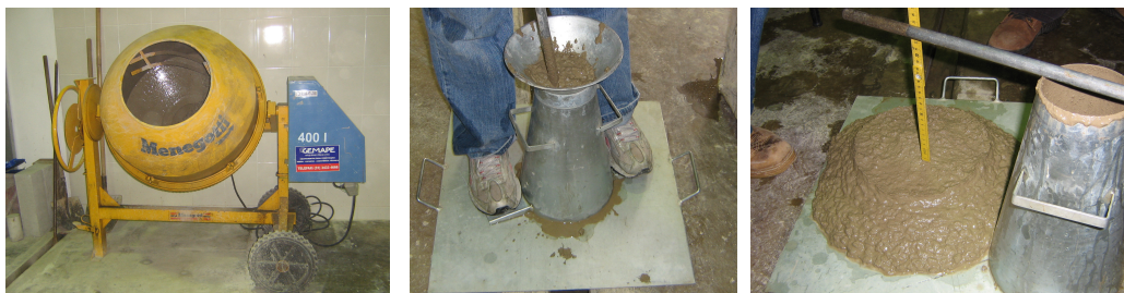
Figura 4-16 - Betoneira Menegotti - Medida de consistência do concreto.
