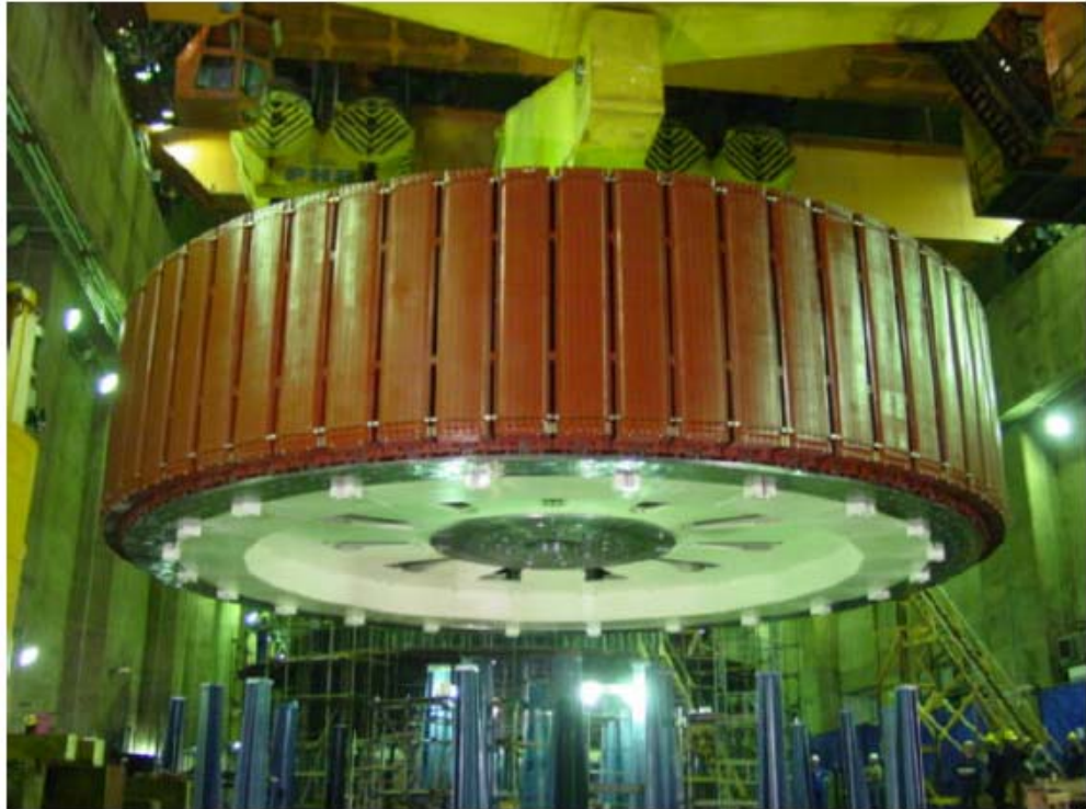
Fig. 1.14 – Usina de Itaipu: rotor do gerador.
