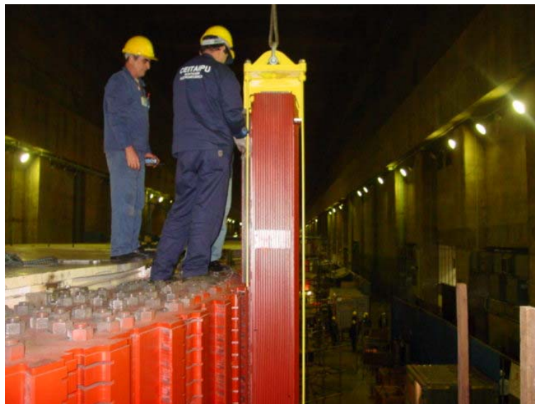
Fig. 1.6 – Usina de Itaipu: pólo sendo encaixado na coroa polar.
