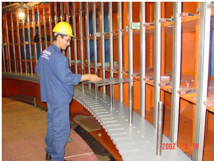
Fig. 1.16 – Usina de Itaipu: núcleo estático em fase de montagem.
