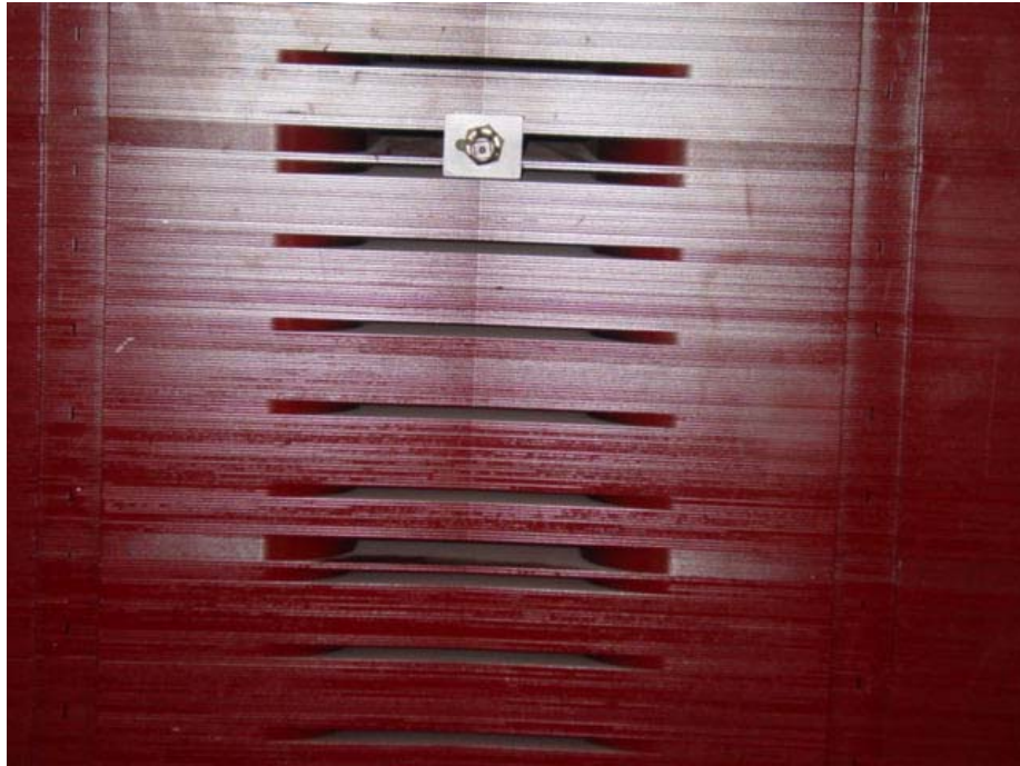
Fig. 1.12 – Usina de Itaipu: vista da coroa polar pelo lado interno.
