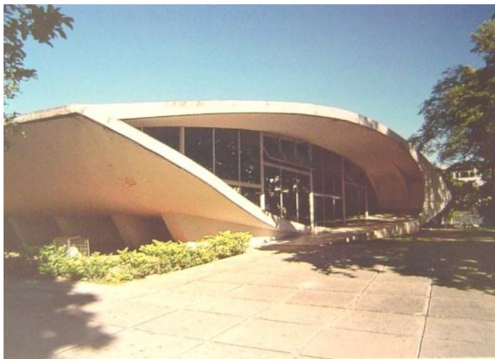
Figura 19: Auditório do Colégio Estadual (1955), Belo Horizonte. Vêem-se vigas de sustentação da laje de piso.
