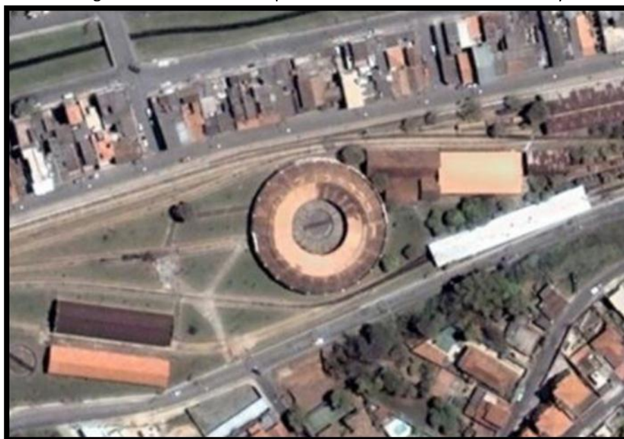
Figura 12 - Vista aérea do pátio e da rotunda de São João del Rey
