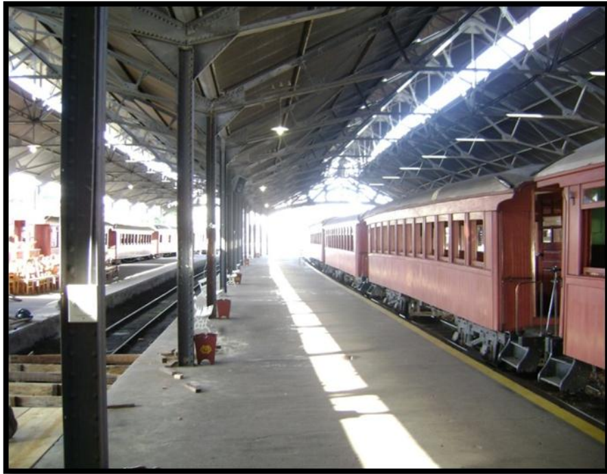
Figura 10 - Estação Ferroviária de São João del Rei-Minas Gerais.
