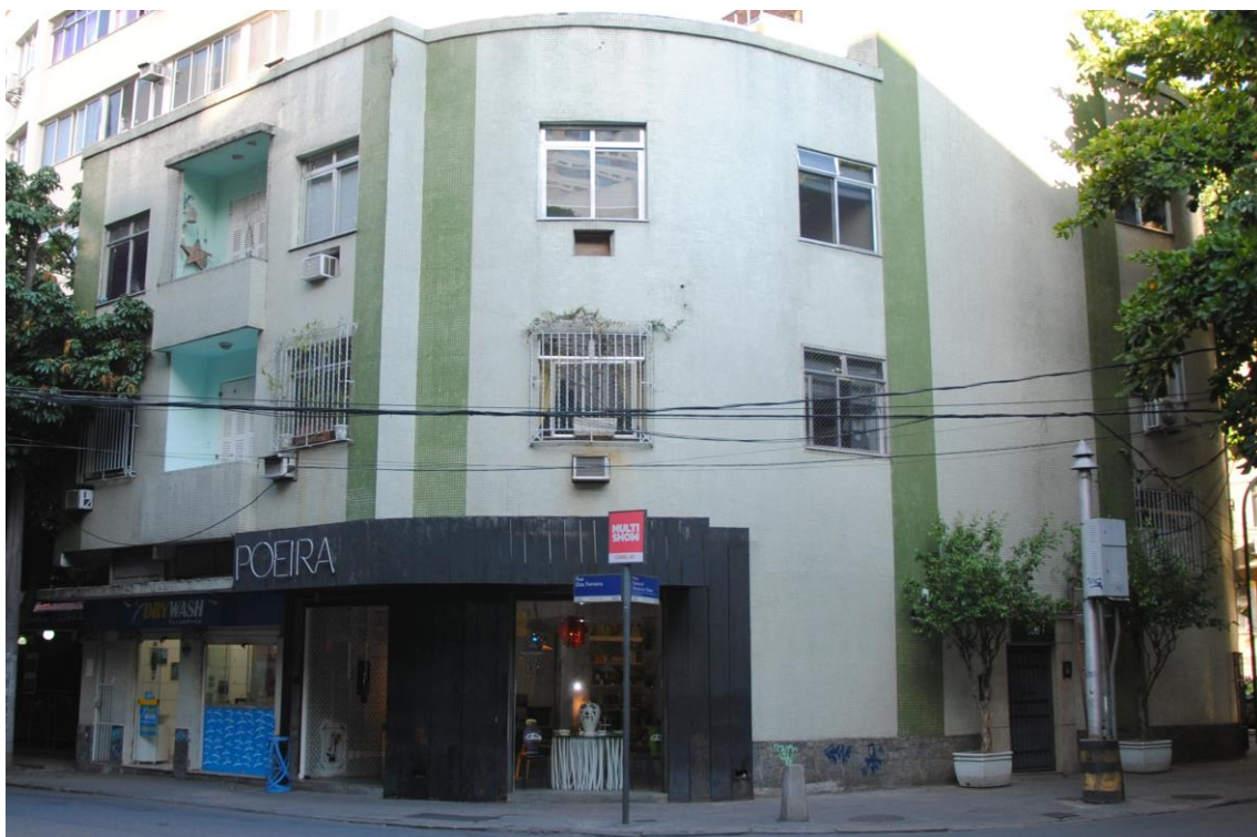
FIGURA 96 - Fachada do prédio de apartamentos da Rua General Venâncio Flores com Dias Ferreira nº. 506
