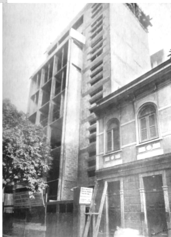
FIGURA 71 - Fachada do Montépío dos Empregados Municipais em construção Fonte: Revista da Diretoria de Engenharia da Prefeitura do Distrito Federal, Ano 1934, p.609.
