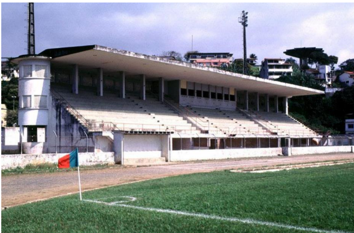
FIGURA 83 - Arquibancada do Estádio Mário Pessoa do Ginásio Municipal de Ilhéus, BA. Fonte: Arquivo Pessoal Prof. Hugo Segawa.
