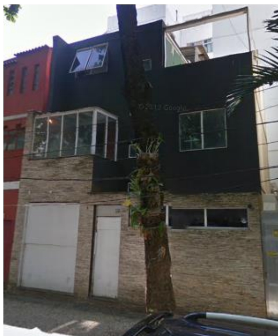
FIGURA 48 - Fachada do prédio de apartamentos da Rua Paul Redfern nº36 Fonte: Google Street View, acessado em 27 de julho de 2014
