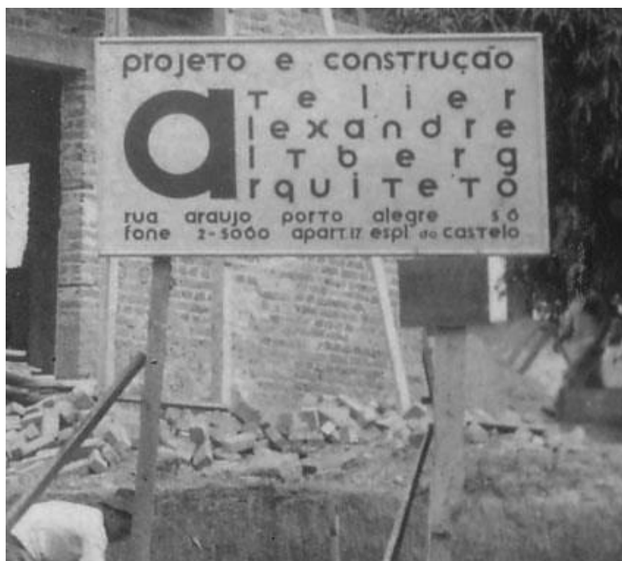
FIGURA 31 - Placa de construção do “Atelier Alexandre Altberg Arquiteto” Fonte: Arquivo pessoal Inken Sarah Mischke
