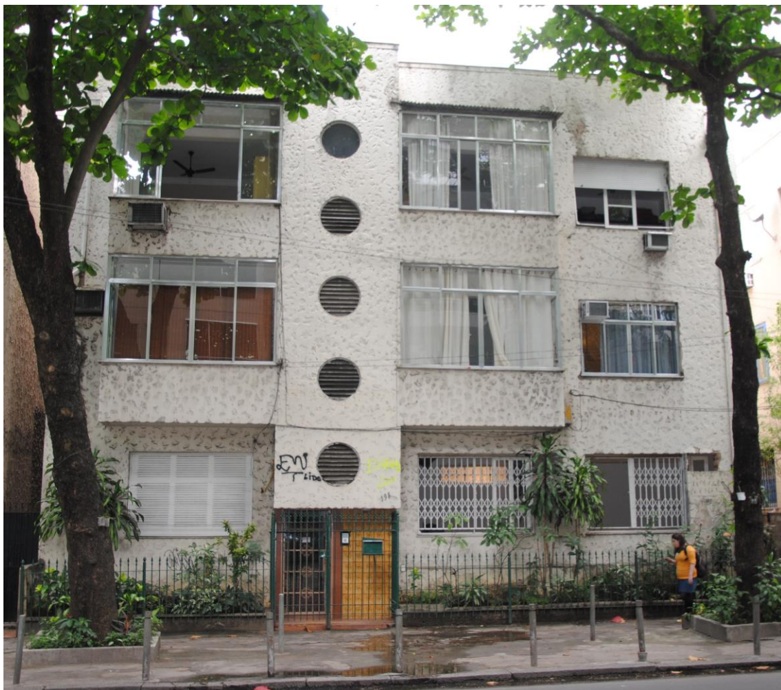
FIGURA 94 - Situação atual do prédio de apartamentos da rua Vinicius de Moraes nº.198 Fonte: Arquivo pessoal Liszt Vianna Neto
