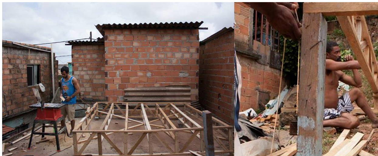
Figura 91 Construção das treliças da base e alinhamento dos postes de fundação. Fonte: elaborada pelo autor.
