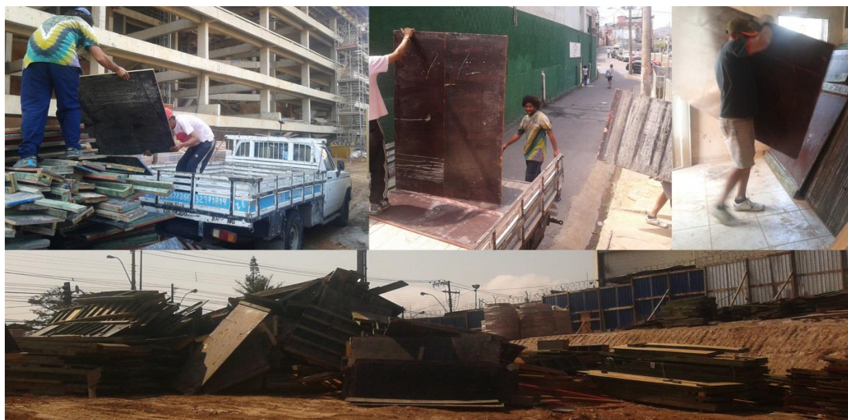
Figura 65 Na foto acima, Marcos e moradores da vila carregando e descarregando materiais doados pela construtora que estava construindo ao lado da vila. Na foto abaixo uma das duas pilhas de madeira descartada pela construtora após a finalização da estrutura de concreto. Devido ao custo do carreto foram feitas somente duas viagens e recolhido menos de 10% do material. Fonte: elaborada pelo autor.
