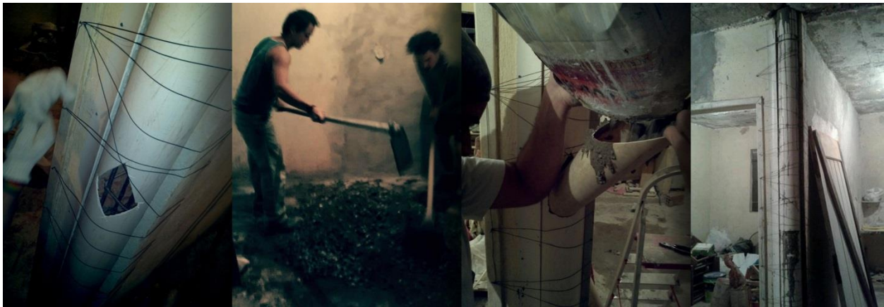
Figura 68 Processo de concretagem do pilar. Fonte: elaborada pelo autor.
