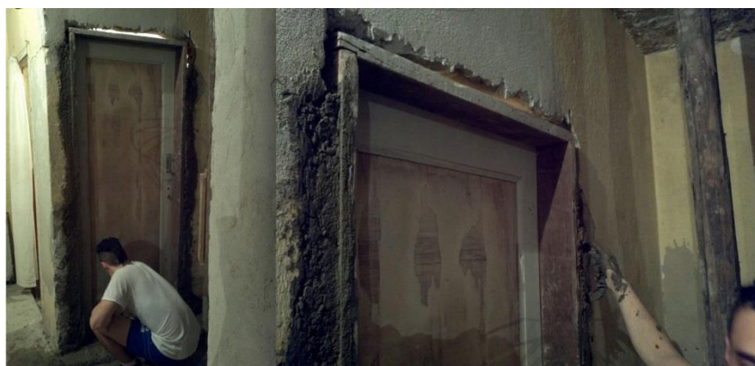
Figura 71 Batente da nova porta do banheiro fixado por concreto. Fonte: elaborada pelo autor.
