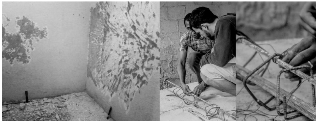
Figura 96 À esquerda trabalho executado usando espátula e talhadeira pelo mesmo período de tempo. Ao centro e à direita um morador da vila ensinando como amarrar os estribos nos vergalhões da armadura. O conhecimento dos melhores métodos e ferramentas para cada ocasião é adquirido na prática e trazido por aqueles com prática. Fonte: Imagem à esquerda: elaborada pelo autor. Imagens ao centro e direita: Horacius de Jesus.
