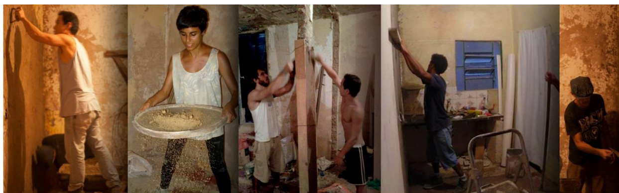
Figura 72 Argamassa sendo aplicada nas paredes e pilares durante os mutirões. Fonte: elaborada pelo autor.
