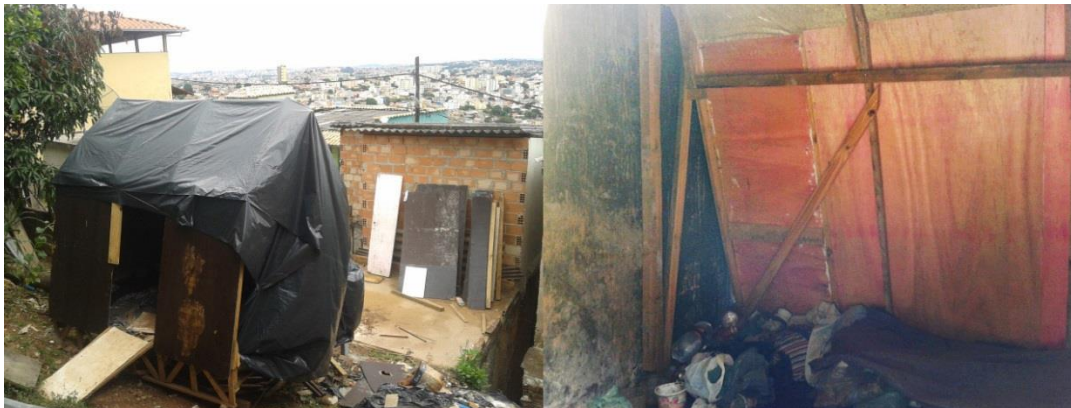
Figura 94 Casa da Dona Tereza depois de parcialmente revestida de madeira e coberta com lona. Fonte: elaborada pelo autor.
