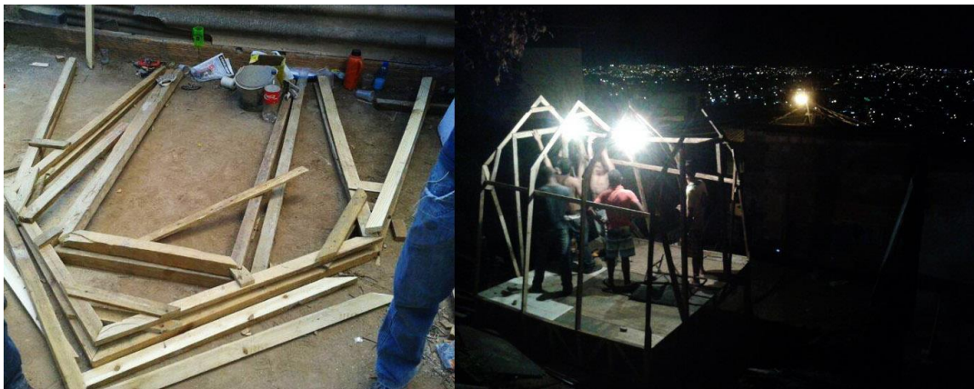
Figura 93 Arcos montados uns sobre os outros, para assegurar sua semelhança, e estrutura completa faltando somente as diagonais e o revestimento. Fonte: elaborada pelo autor.
