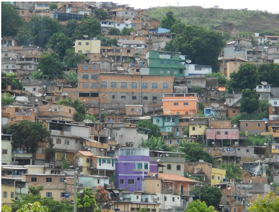
FIGURA 09 – Padrão construtivo das edificações – Aglomerado Santa Lúcia
