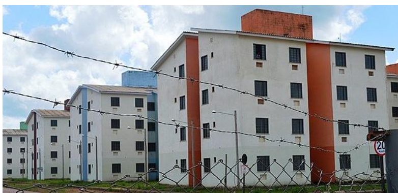
Figura 7 – Fachadas de edifícios em condomínio do Programa Minha Casa Minha Vida, na cidade de Porto Velho (RO) – Região Norte.
