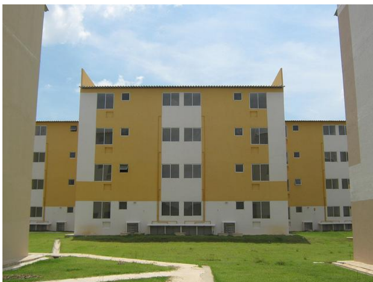
Figura 5 – Fachada de edifício em condomínio do Programa Minha Casa Minha Vida, na cidade de Manaus (AM).
