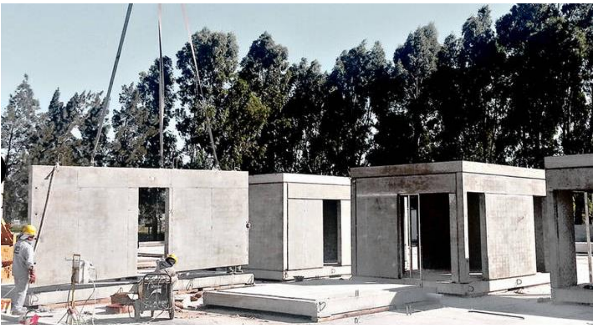
Figura 31. Canteiro de montagem dos módulos de habitação
