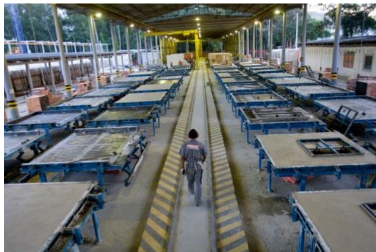
Figura 49. Fabricação de painéis, contexto geral
