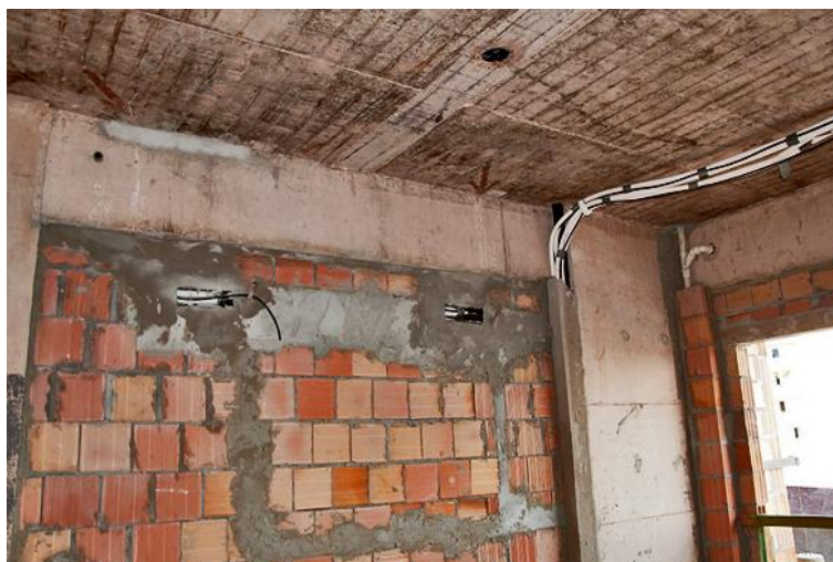
Figura 46. Instalações prediais em alvenarias com recortes e preenchimentos
