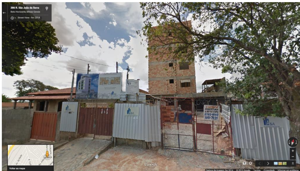
Imagem de Levantamento 11. Edifício de andares múltiplos, executada em 2014, em estrutura de concreto moldada no local e alvenarias de bloco cerâmico para vedação. Implantado à Rua São João da Serra, Bairro Três Marias.
