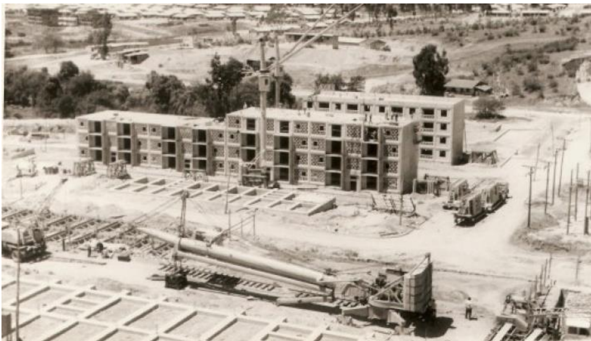
Figura 10. Exemplo de edifício construído com a tecnologia KPD
