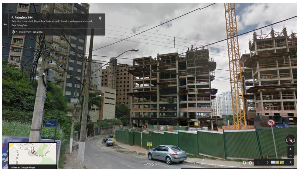
Imagem de Levantamento 7. Edifício de andares múltiplos, executada em 2012, em estrutura de concreto moldada no local e alvenarias de bloco cerâmico para vedação. Implantado à Rua Patagônia, Bairro Sion.
