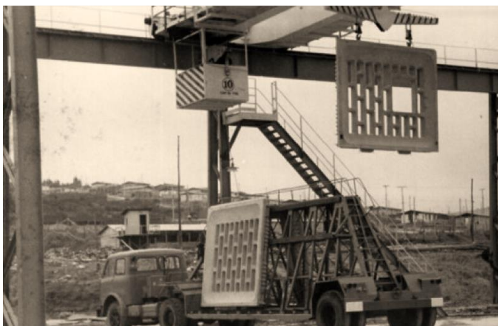
Figura 12. Transporte dos painéis KPD.
