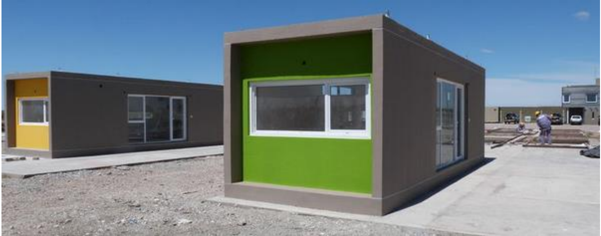
Figura 30. Módulo habitacional básico instalado e acabado.
