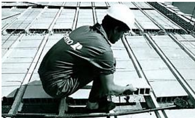
Figura 18. Fabricação de lajes em BH
