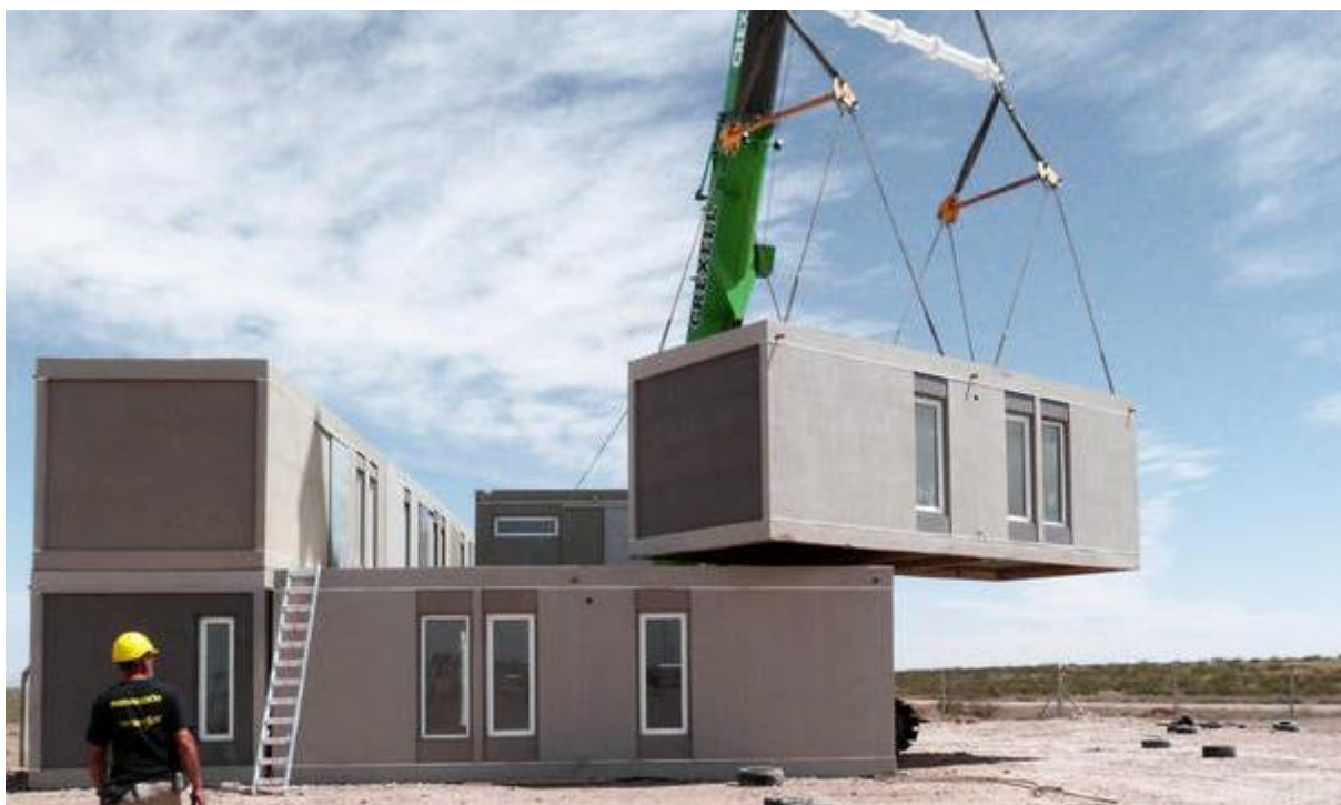
Figura 32. Içamento dos módulos habitacionais em sistema fechado.
