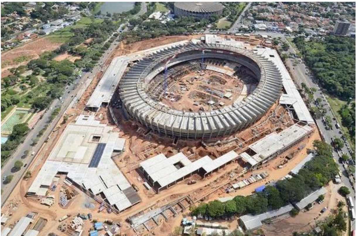
Figura 57. Execução da esplanada do Mineirão
