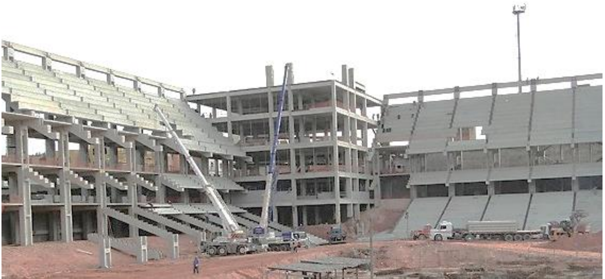
Figura 56. Arquibancadas em concreto pré-fabricado
