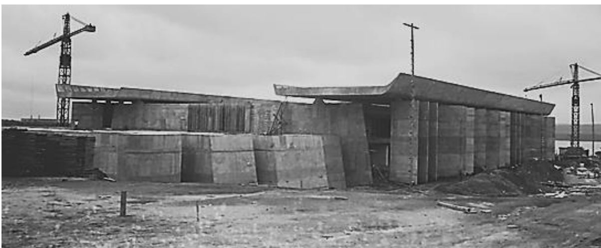
Figura 27. Estocagem de placas e lajes para montagem na obra (UnB)
