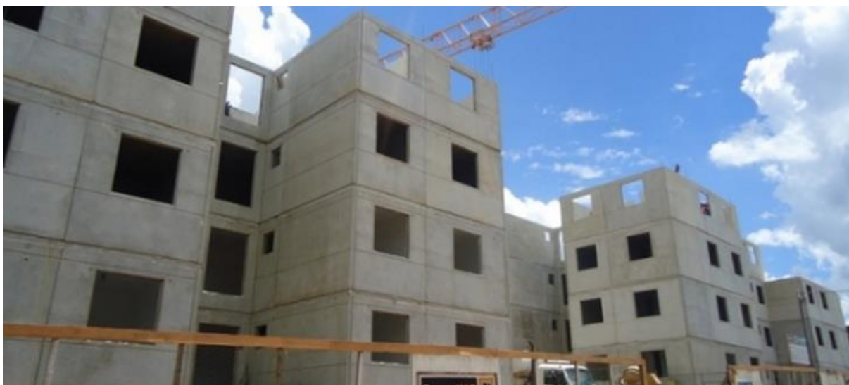
Figura 51. Obra de edifício de múltiplos pavimentos com painéis em BH.
