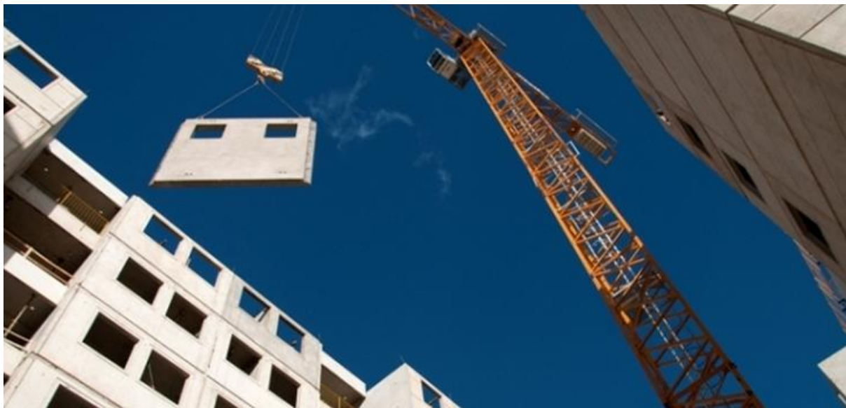
Figura 52. Obra de edifício de múltiplos pavimentos com painéis em BH
