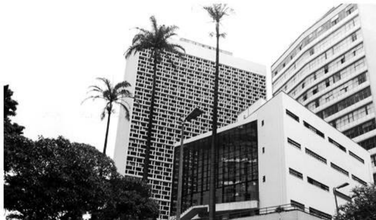
Figura 58. Escola de Direito no centro de BH
