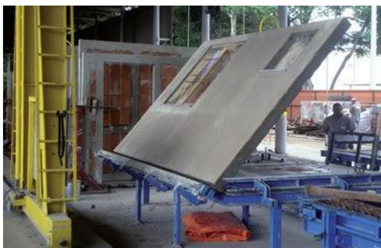
Figura 48. Fabricação do painel
