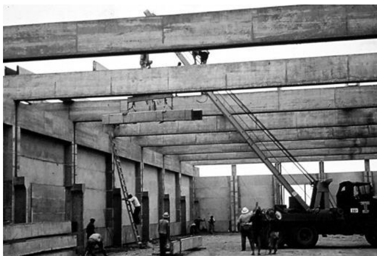
Figura 24. Construção de edifício da UnB em pré-fabricado
