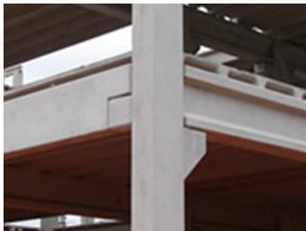
Figura 44. Exemplo de apoio de viga em pilar.
