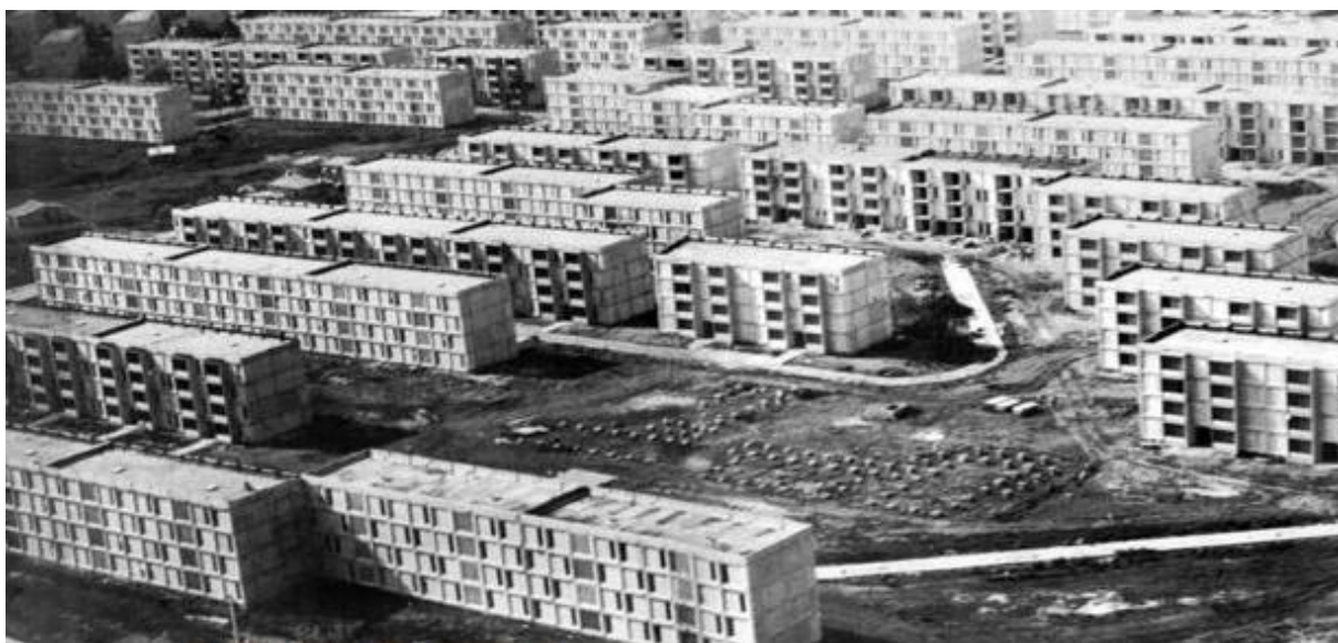
Figura 9. Edificações executadas a partir do modelo de pré-fabricados cubano Fotografia José Martí Distrital de Santiago de Cuba (1965), em (ALONSO, 2011)
