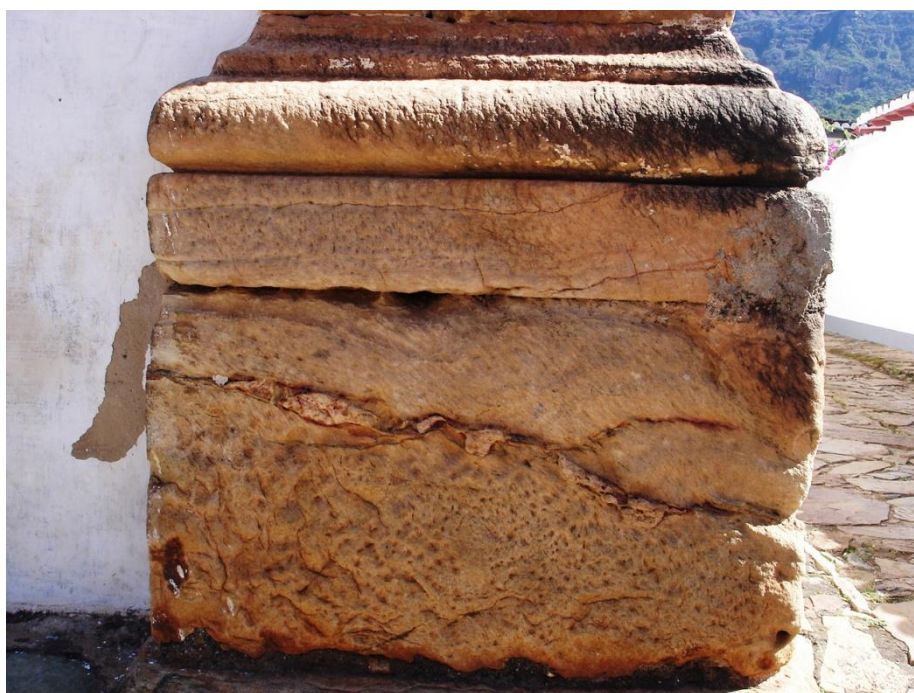
FIGURA 9 — A pedra utilizada na arquitetura, detalhe de base de cunhal em cantaria, Sobrado Ramalho, Rua Direita, em Tiradentes. Fotografia do autor, 2010.
