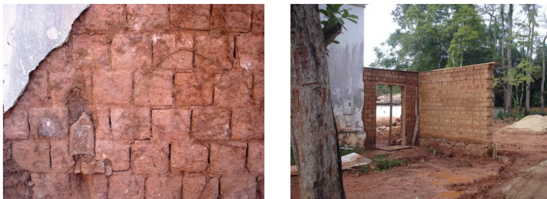
FIGURAS 206 e 207 — Fragmento do antigo muro de divisa do pátio externo e sua construção, utilizando-se do mesmo material, o adobe cozido ao sol. Fotografias do autor, 2012.
