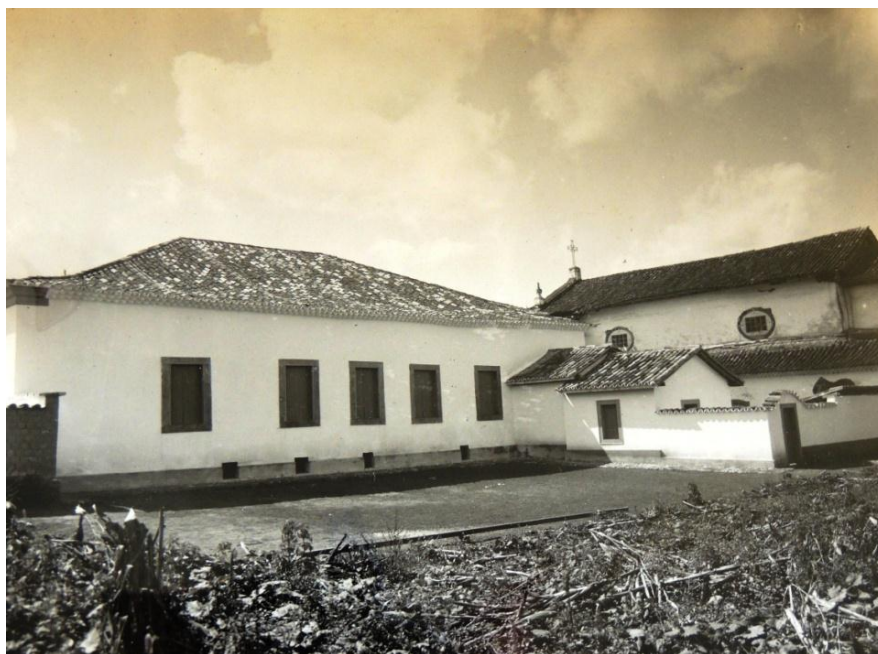
FIGURA 32 — A fachada posterior da Casa Padre Toledo e a Capela de São João Evangelista, com as cozinhas reconstituídas e seus pátios. Década de 1940. Fonte ACIPHAN/RJ.
