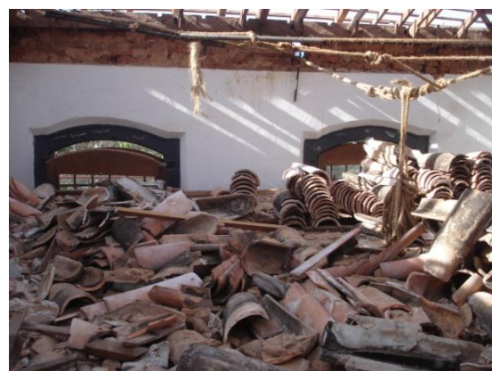
FIGURAS 159 e 160 — A estrutura do telhado e as telhas com argamassa de emboque retiradas. Fotografia do autor, 211.
