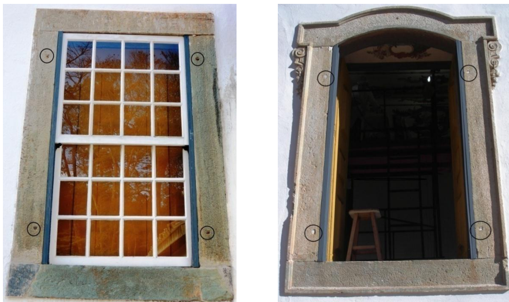
FIGURAS 58 e 59 — Detalhes de alizares em pedra xisto das janelas da Casa Padre Toledo, com as aberturas para as ferragens da janelas em gelosias, que foram substituídas por guilhotinas, com vidros. Fotografia do autor, 2012.
