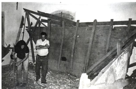
FIGURAS 129 e 130 — Aspecto do forro do torreão da Casa Padre Toledo, após o desabamento em consequência de chuvas. Década de 1980. Fonte ACIPHAN/RJ.
