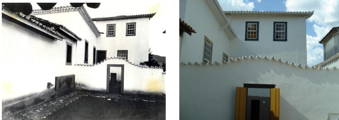
FIGURAS 199 e 200 — A reconstrução do muro que dividia os pátios internos das cozinhas na década de 1940 e 2012. Fonte ACIPHAN/RJ e fotografia do autor.
