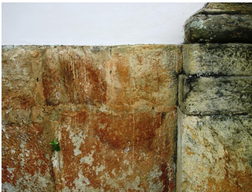
FIGURA 10 — A pedra utilizada na arquitetura, como embasamento, para receber a parede de taipa e evitar a umidade. Capela de Nossa Senhora das Mercês, Tiradentes. Fotografia do autor, 2012.
