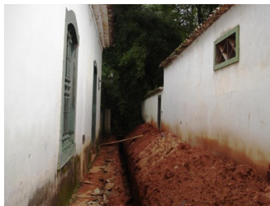
FIGURAS 208, 209, 210 e 211 — A construção dos drenos em torno da Casa Padre Toledo. Fotografias do autor, 2012.
