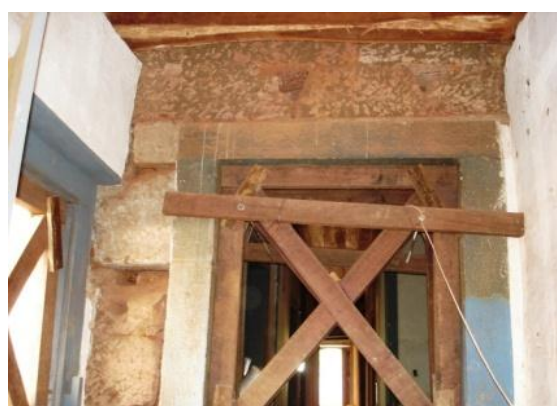
FIGURAS 155, 156, 157 e 158 — Intervenção para estabilização do torreão. Fotografias do autor, 2011.
