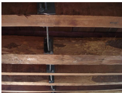
FIGURAS 166 e 167 — Estrutura metálica instalada ente o piso e o forro pintado. Fotografias do autor, 2011.
