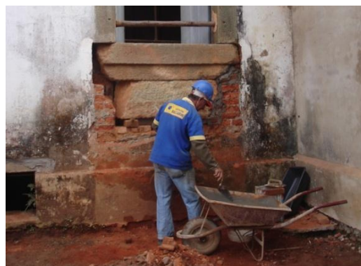
FIGURAS 212, 213, 214 e 215 — A recuperação e reconstrução dos passeios e pisos em pé de moleque. A recuperação e instalação das pedras da janela da fachada posterior. Fotografias do autor, 2012.
