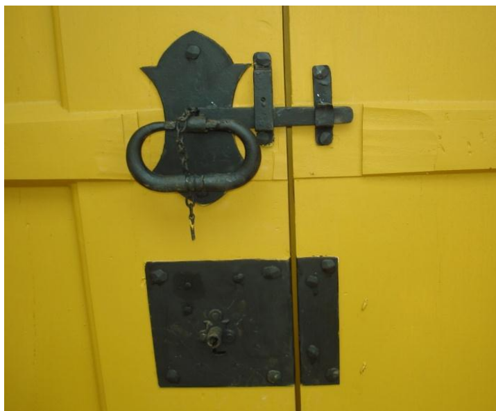
FIGURAS 183, 184 e 185 — As peças de ferragens substituídas; as antigas com design do século XVIII foram reaproveitadas nas portas e janelas recuperadas. Fotografias do autor, 2012.
