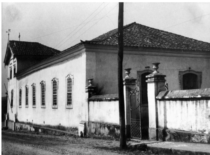
FIGURA74 — Intervenção de gosto eclético na Casa Padre Toledo. Entrada lateral da edificação. Década de 1940. Fonte ACIPHAN/RJ.
