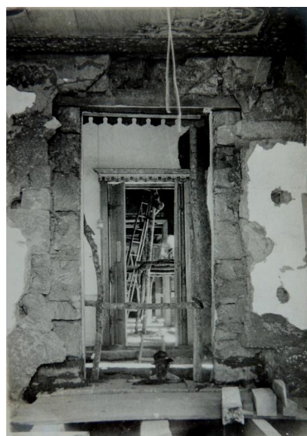
FIGURAS 92, 93 e 94 — Reconstrução das paredes que foram removidas, para o funcionamento do cinema e teatro, no Edifício da Prefeitura de Tiradentes, 1944. Fonte ACIPHAN/RJ.
