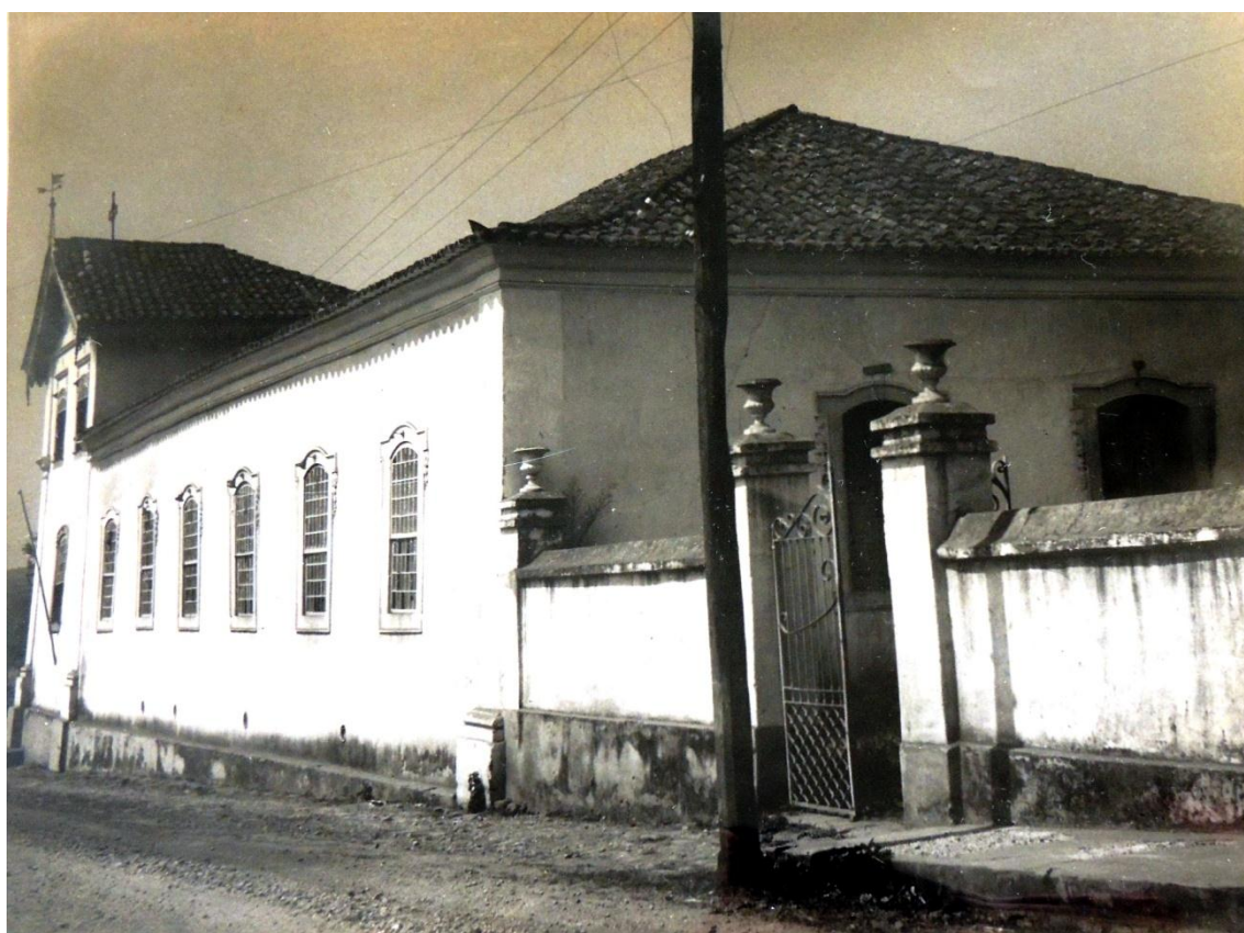
FIGURA 26 — Entrada da Casa Padre Toledo, com o muro e portão ao gosto eclético, separando o espaço privado do público. Pela largura do muro, o material utilizado deve ter sido a taipa. Década de 1940. Fonte ACIPHAN/RJ.
