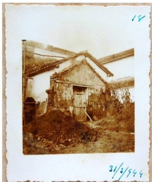
FIGURA 79 — Fachada posterior do edifício da Prefeitura de Tiradentes, a Casa Padre Toledo, destacando a “cozinha suja” que havia desabado, 1944. Fonte ACIPHAN/RJ.
