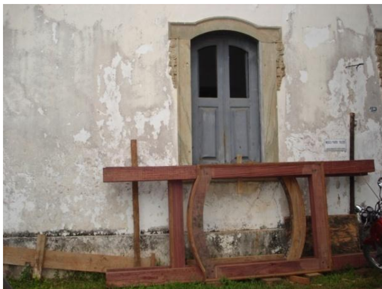
FIGURA 163 — Os marcos das janelas da fachada frontal do torreão, com pouco aproveitamento de peças antigas, devido a conservação. Fotografia do autor, 2011.
