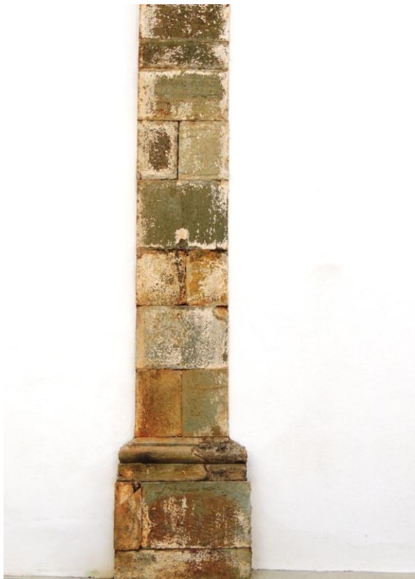
FIGURA 57 — Cunhal em pedra xisto que dava acabamento ao primeiro bloco da Casa Padre Toledo. Fotografia do autor, 2012.
