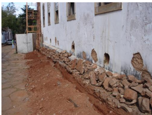
FIGURAS 208, 209, 210 e 211 — A construção dos drenos em torno da Casa Padre Toledo. Fotografias do autor, 2012.
