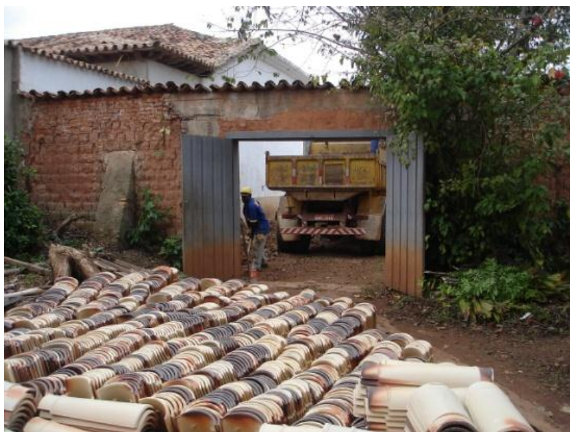
FIGURA 149 — Telhas de barro novas, para as bicas do telhado. Fotografia do autor: 2010.
