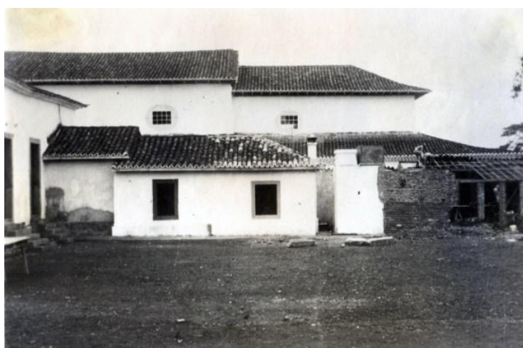
FIGURAS 114 e 115 — Intervenções na Casa Padre Toledo: abertura de portas no ambiente entre a cozinha limpa e a sala de jantar e construção de anexos, para banheiros, cozinha e refeitório dos seminaristas. Década de 1960. Fonte ACIPHAN/RJ.
