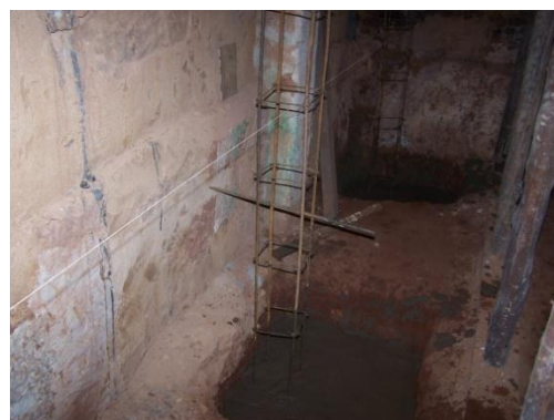
FIGURAS 164 e 165 — Para a consolidação do torreão foi reconstituído o embrechamento das paredes do alicerce, construção de colunas de concreto e sapatas. Fotografias de Edilson Santos, 2011.
