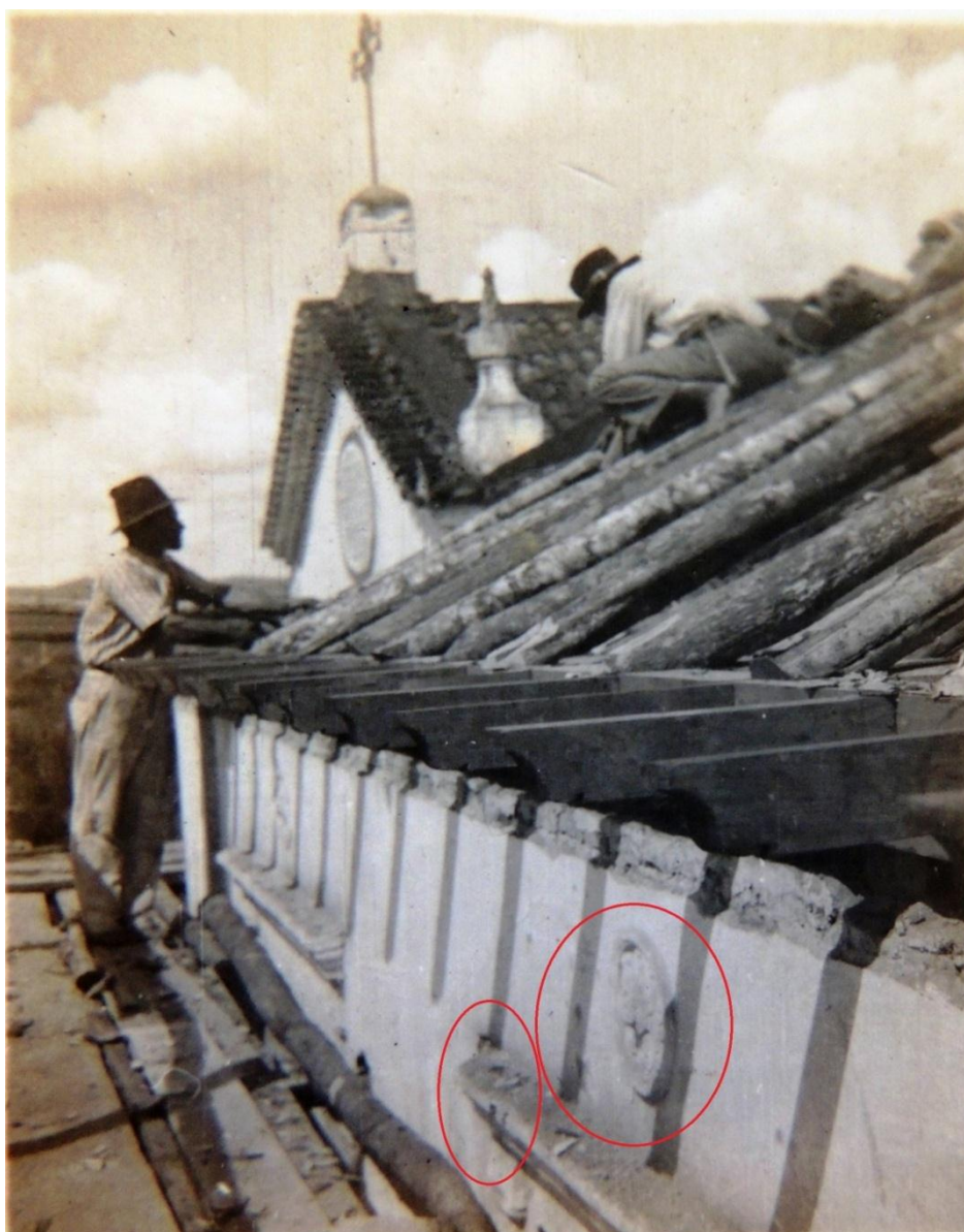
FIGURA 95 — Reconstrução do telhado do torreão em quatro águas. E em destaque as rosáceas em argamassa de gosto eclético, que também foram subtraídas do “Edifício da Prefeitura de Tiradentes”, 1944. Fonte ACIPHAN/RJ.
