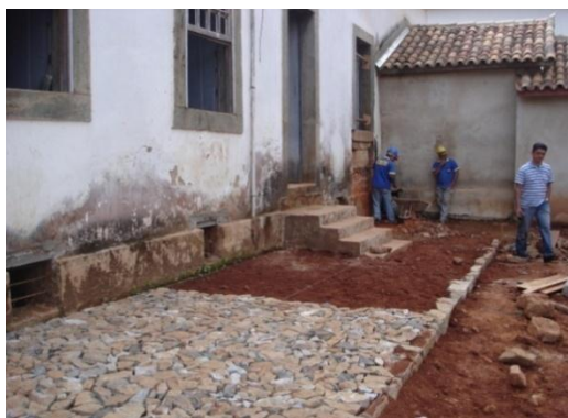
FIGURAS 212, 213, 214 e 215 — A recuperação e reconstrução dos passeios e pisos em pé de moleque. A recuperação e instalação das pedras da janela da fachada posterior. Fotografias do autor, 2012.
