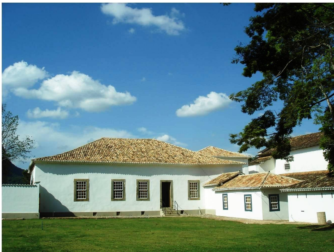
FIGURA 35 — Fachada posterior da Casa Padre Toledo, após a última restauração. Fotografia do autor, 2012.
