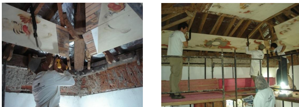
FIGURAS 229 e 230 — Detalhe dos trabalhos de remontagem do forro do torreão. Fotografias do autor, 2012.
