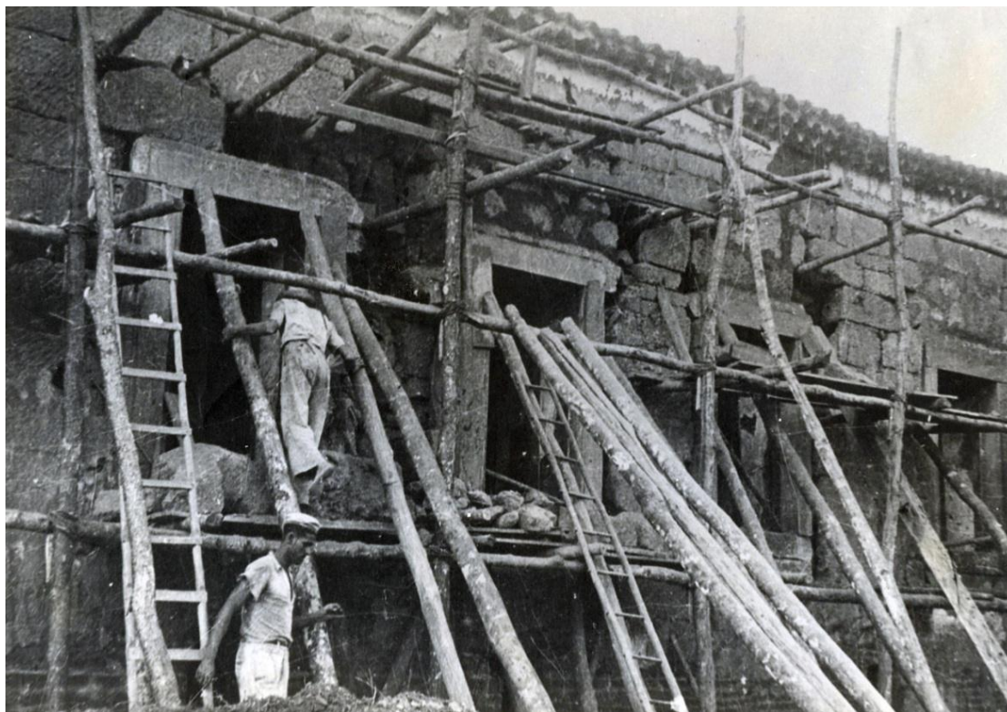
FIGURA 101 — A parede da fachada posterior, da sala de jantar da residência, teve que ser remontada, mas utilizando-se dos mesmos blocos de moledo, 1944. Fonte ACIPHAN/RJ.
