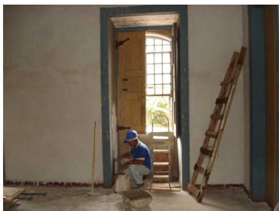
FIGURAS 178 e 179 — Intervenção no revestimento das paredes, internas e externas. Fotografias do autor, 2012.
