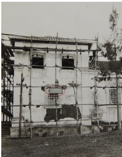
FIGURA 110 — Placa da obra de restauração, 1944. Fonte ACIPHAN/RJ.
