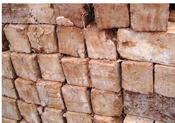
FIGURAS 7 e 8 — Adobes novos utilizados na obra da Casa Padre Toledo e antigos em parede sem a proteção do reboco, Fazenda Capão Seco, Lagoa Dourada/MG. Fotografia do autor, 2011 e 2010.
