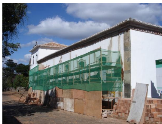
FIGURAS 178 e 179 — Intervenção no revestimento das paredes, internas e externas. Fotografias do autor, 2012.
