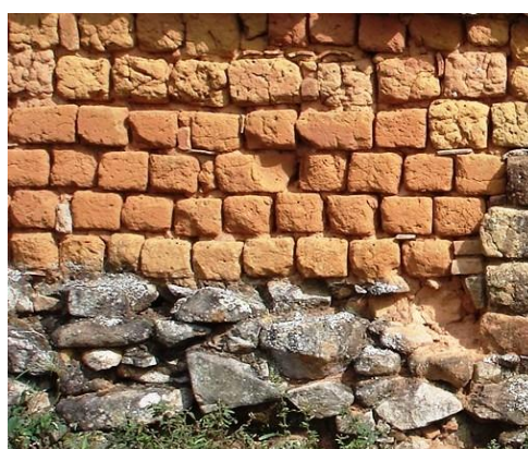
FIGURAS 7 e 8 — Adobes novos utilizados na obra da Casa Padre Toledo e antigos em parede sem a proteção do reboco, Fazenda Capão Seco, Lagoa Dourada/MG. Fotografia do autor, 2011 e 2010.
