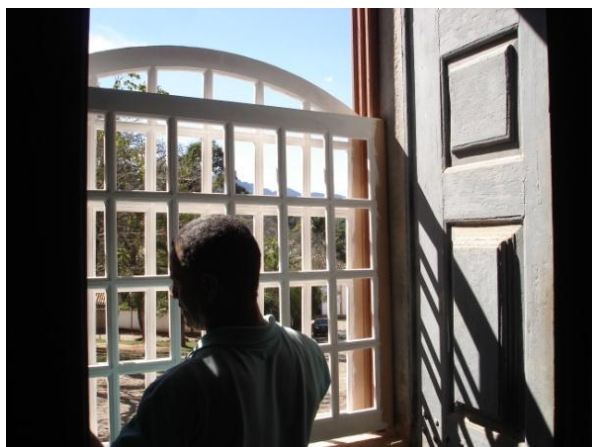
FIGURAS 180, 181 e 182 — Intervenção de recuperação das bandeiras de portas e janelas do imóvel. Fotografias do autor, 2012.
