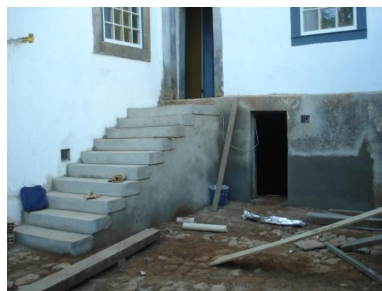
FIGURAS 216 e 217 — Blocos de concreto para a reconstituição das escadas. Fotografias do autor, 2012.
