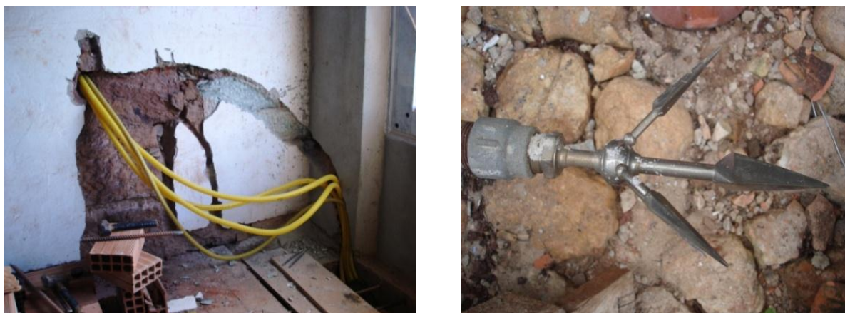
FIGURAS 190 e 191 — Obra da nova instalação elétrica e o antigo pára-raio. Fotografias do autor, 2012.
