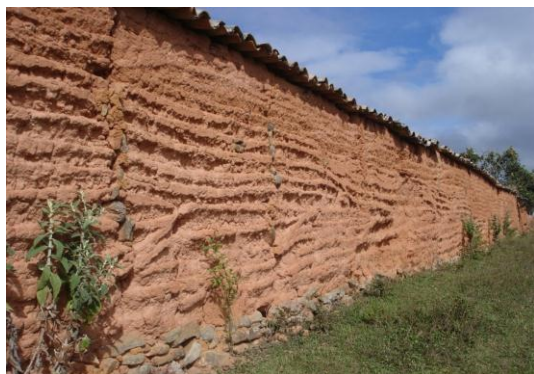
FIGURA 5 — Muro de taipa sem a proteção do reboco, Fazenda Capão Seco, Lagoa Dourada/MG. Fotografia do autor, 2010.
