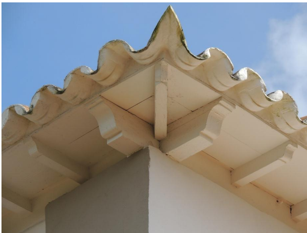
FIGURA 30 — Detalhe do beiral de cachorro do torreão da Casa Padre Toledo. Fotografia do autor, 2012.
