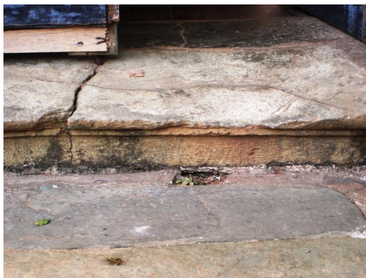
FIGURA 28 — Soleira da porta principal da Casa Padre Toledo, em pedra xisto, conectando o interno com o externo. Fotografia do autor, 2010.
