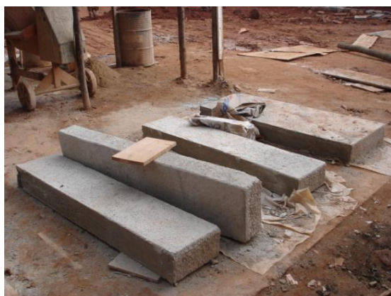
FIGURAS 216 e 217 — Blocos de concreto para a reconstituição das escadas. Fotografias do autor, 2012.
