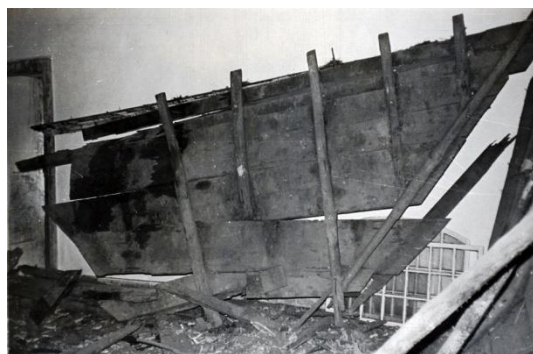
FIGURAS 129 e 130 — Aspecto do forro do torreão da Casa Padre Toledo, após o desabamento em consequência de chuvas. Década de 1980. Fonte ACIPHAN/RJ.
