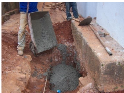
FIGURAS 164 e 165 — Para a consolidação do torreão foi reconstituído o embrechamento das paredes do alicerce, construção de colunas de concreto e sapatas. Fotografias de Edilson Santos, 2011.
