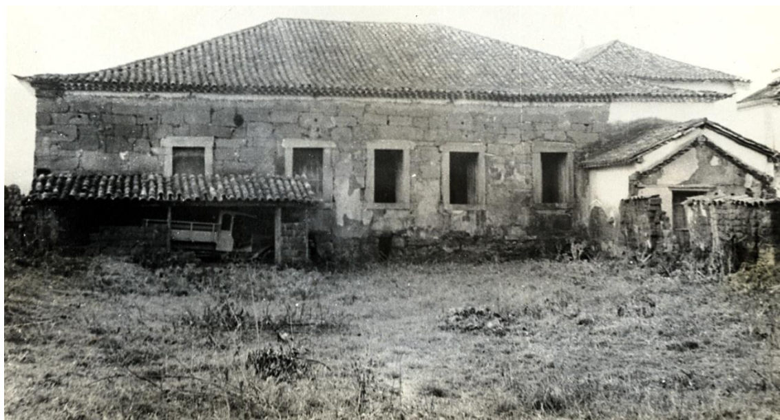
FIGURA 78 — Fachada posterior do “Edifício da Prefeitura de Tiradentes”, a Casa Padre Toledo, com o telhadeiro que abrigava os animais da prefeitura e que posteriormente abrigou um veículo. À direita a “cozinha suja” desabada. Fotografia de 1944. Fonte ACIPHAN/RJ.
