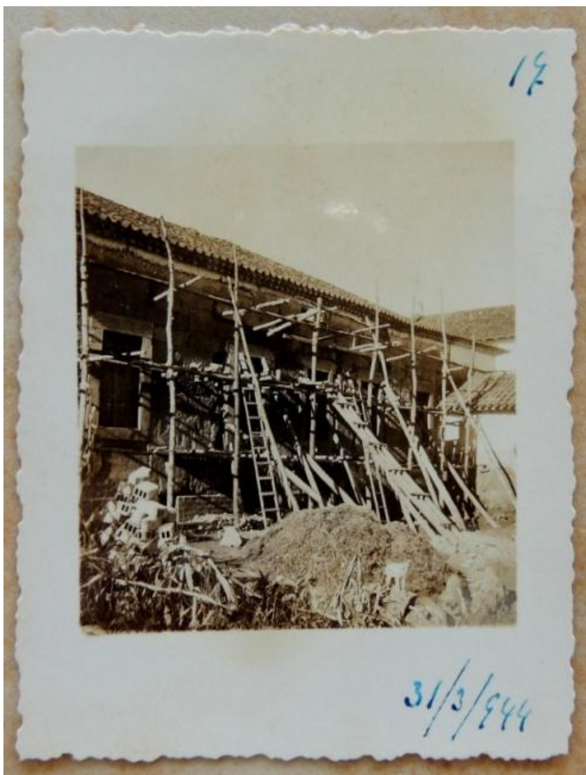
FIGURA90 — Aspectos da primeira intervenção realizada pelo SPHAN no Edifício da Prefeitura de Tiradentes, antiga Casa Padre Toledo. A parede de moledo da fachada posterior, que corria risco de desabamento. Fotografia de Rossino Baccarini. Datada de 31 de março de 1944. Fonte ACIPHAN/RJ.
