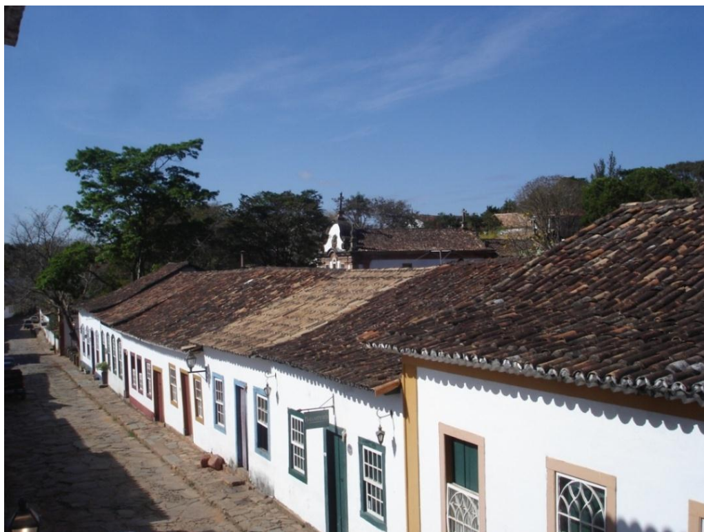
FIGURA 11 — Telhados da Rua Direita, em Tiradentes, cobertura com telhas de barro cozido. Fotografia do autor, 2010.
