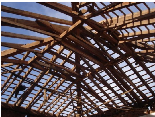
FIGURAS 159 e 160 — A estrutura do telhado e as telhas com argamassa de emboque retiradas. Fotografia do autor, 211.
