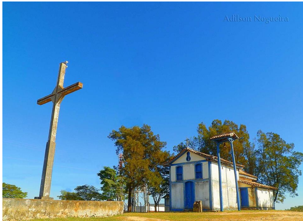
Figura 15 - Capela do Morro do Bonfim antes do incêndio (2013)
