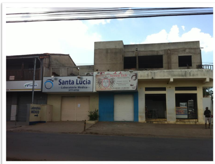
Figura 28. Rua Santa Juliana, Trecho 2 (Serviços)
