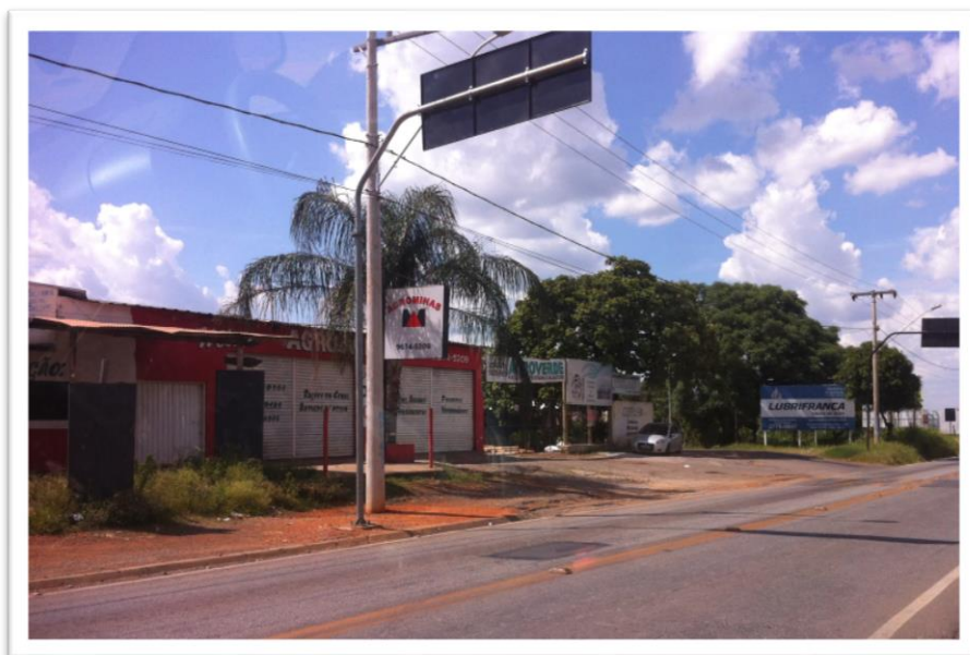
Figura 40. Rua Santa Juliana, Trecho 4 (Grandes Empreendimentos)
