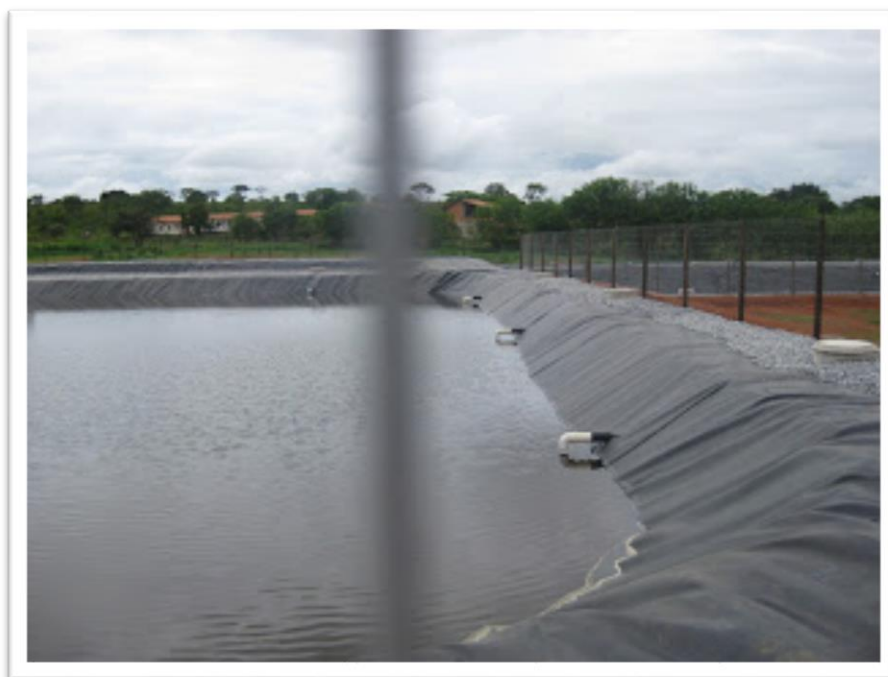
Figura 80. Abatedouro, Casa de Carnes Bastos
