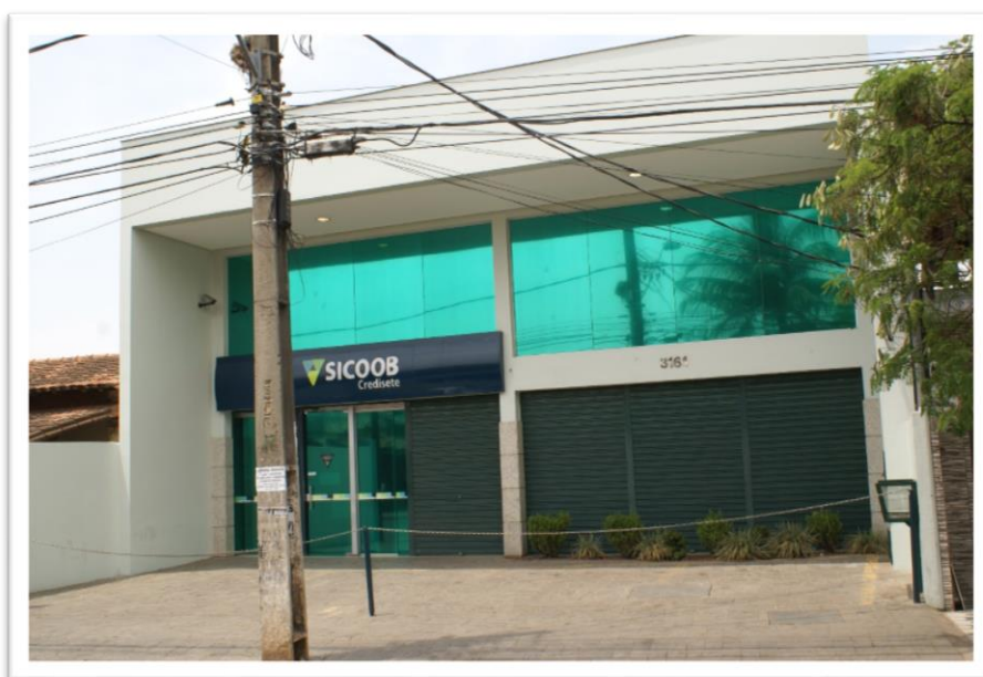
Figura 33. Rua Santa Juliana, Trecho 3 (Grandes Empreendimentos)
