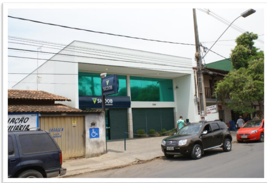
Figura 61. Rua Santa Juliana, Trecho 4 (Grandes Empreendimentos)
