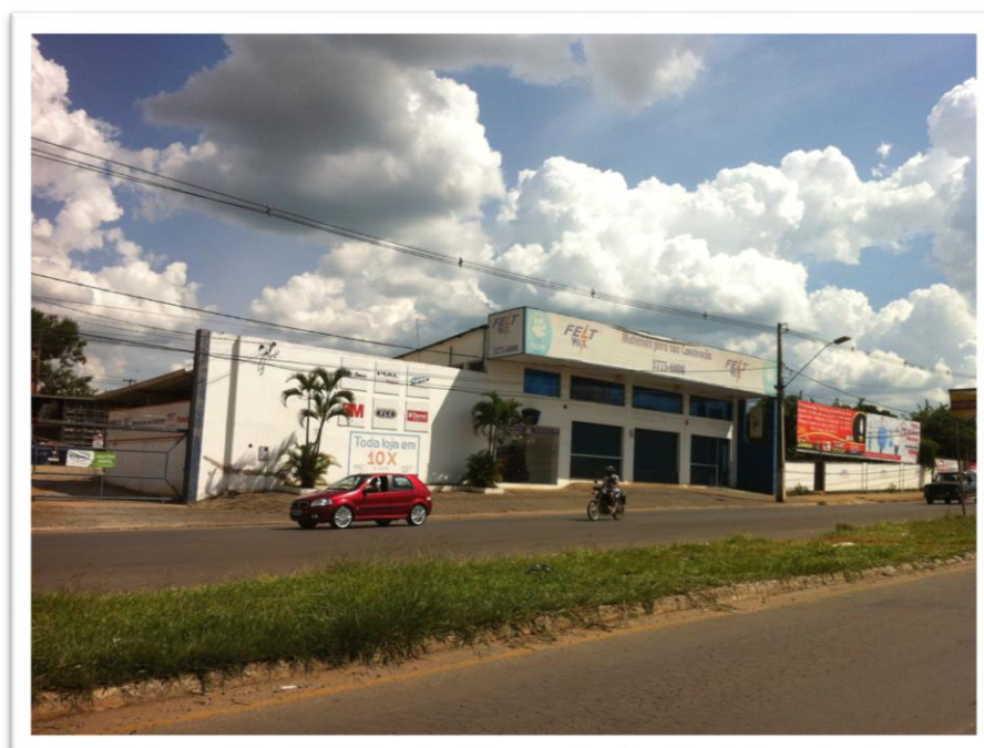
Figura 35. Rua Santa Juliana, Trecho 4 (Grandes Empreendimentos)
