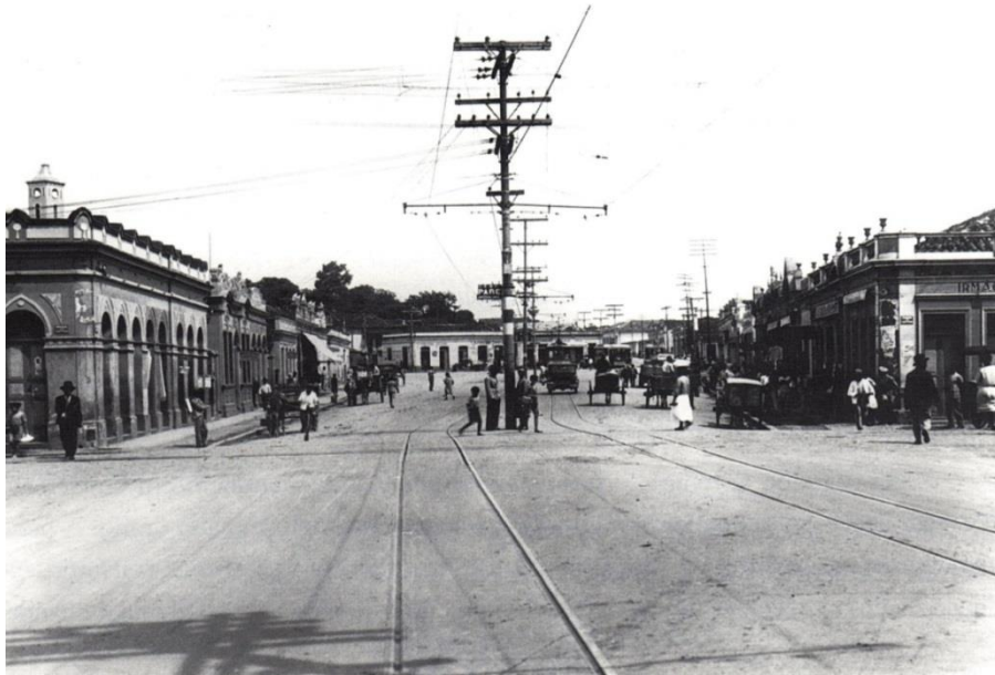
Figura 5 - Praça Vaz de Melo em 1930, demolida para dar lugar ao complexo viário
