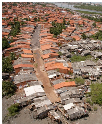
Figura 31. Diferentes fases da “construção” de uma rua: ponte de madeira, aterro e asfalto.
