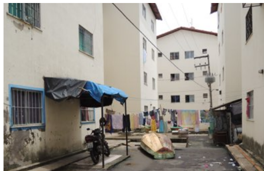
Figura 45. Estaleiro improvisado junto aos prédios do conjunto residencial da Camboa.
