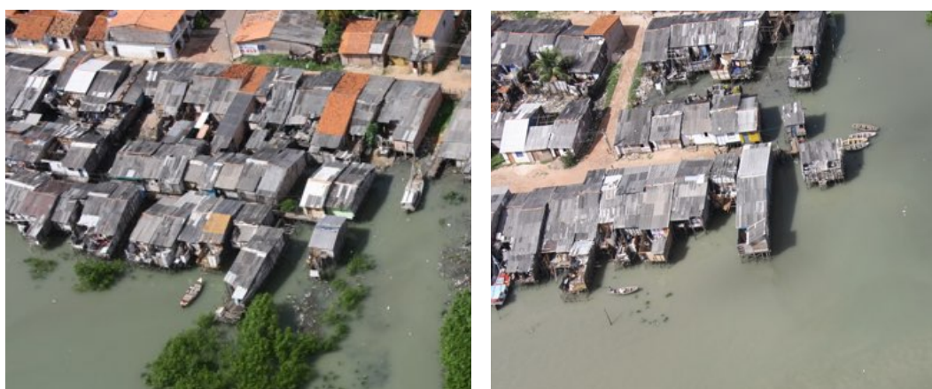
Figura 30. Palafitas com duas frentes: barcos ancorados nos “fundos”.
