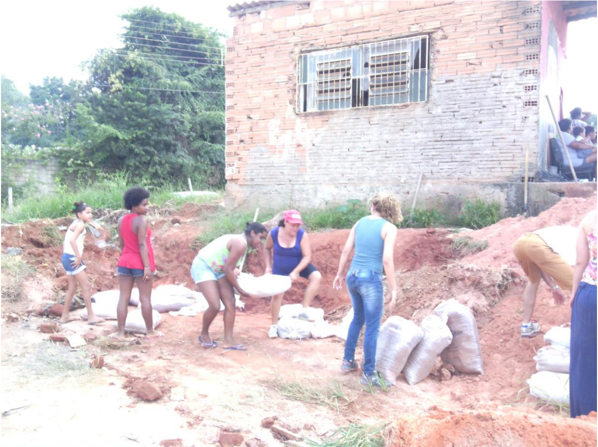
FIGURA 19 – 1º dia do mutirão de construção do parquinho.
