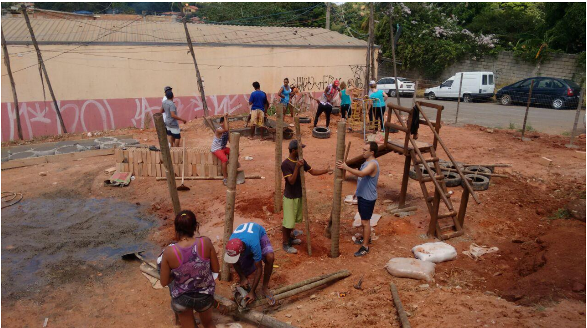
FIGURA 20 – 2º dia do mutirão de construção do parquinho.
