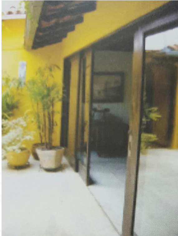
Figura 28 – Imagem da Porta Janela, Residência dos Pais, Curitiba
