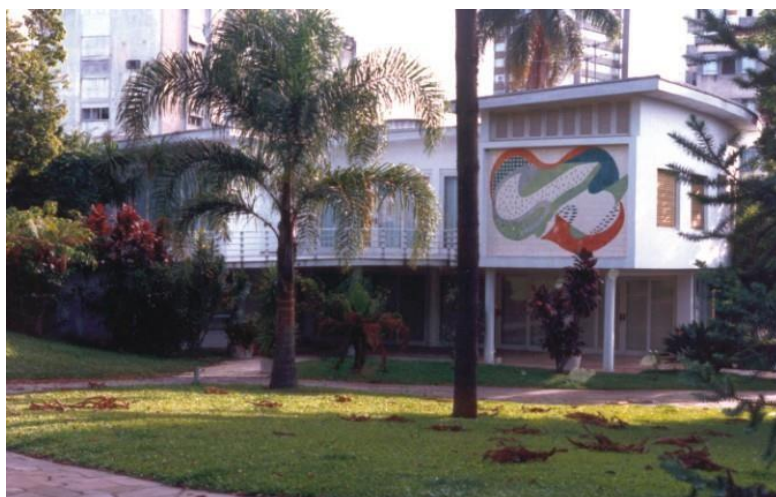
Figura 36 - Residência Cleuza Lupion, Curitiba (demolida)
