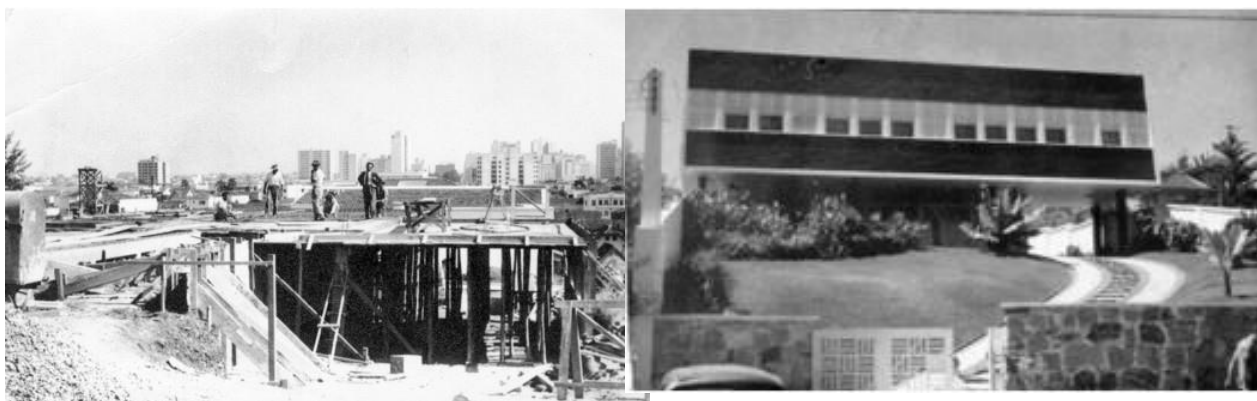
Figuras 184 e 185 – Casa Belotti, Construção e recém-pronta
