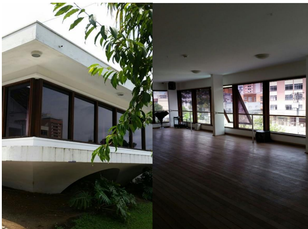
Figuras 73 e 74 - Pilar em forma de taça e sala envidraçada, Residência Wolf
