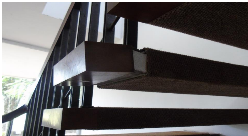
Figura 52 - Escada em concreto com madeira, Residência Axelrud
