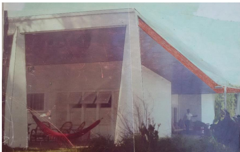
Figura 33 - Residência de campo da família do arquiteto, São José dos Pinhais
