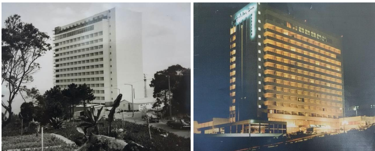
Figuras 130 e 131 - Construção e hotel recentemente inaugurado
