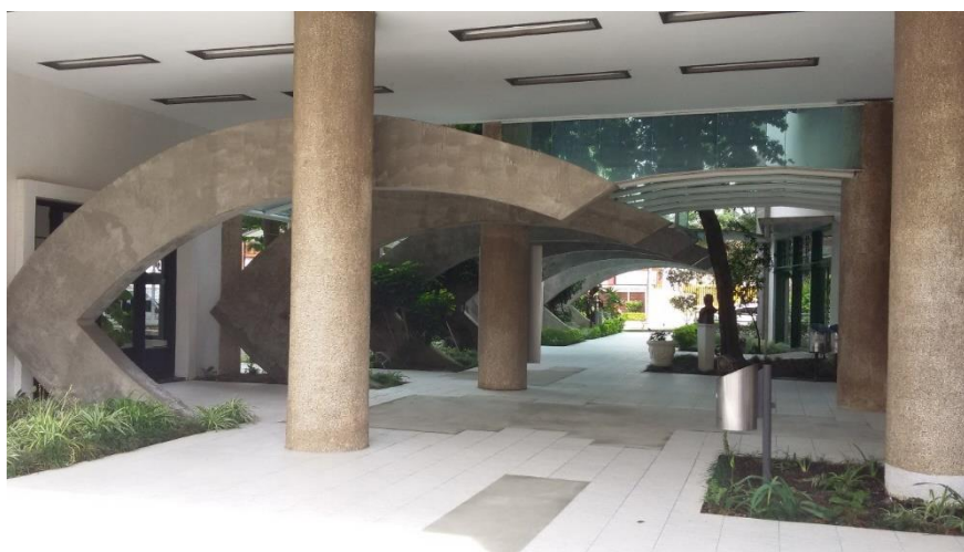
Figura 91- Entrada edifício DER, colunas “C”
