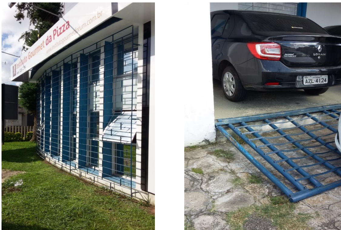
Figuras 65 e 66 - Curvatura da frente e Portão Rampa, Edvar Rezende
