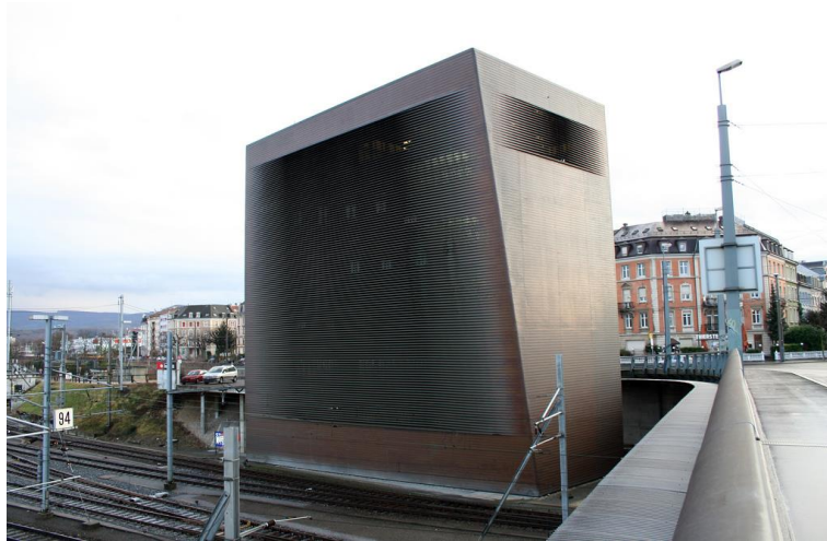
Figura 05 –Herzog & de Meuron, Torre de Controle, Basileia
