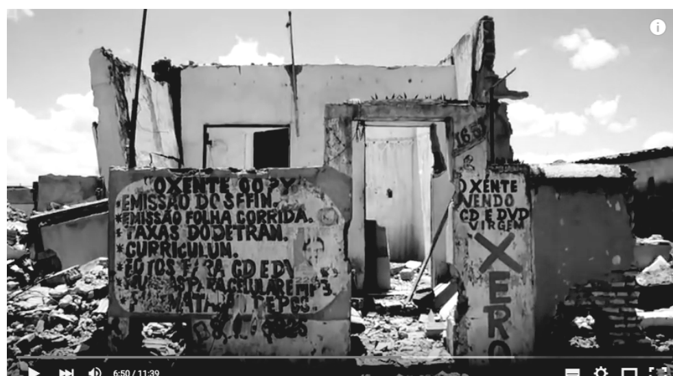
Imagem 15: Vídeo mostra casa sendo demolida para abrigar canteiro de obras do Veículo Leve Sobre Trilhos nunca finalizado – Fortaleza 2013. Fonte: Coletivo Nigéria.
