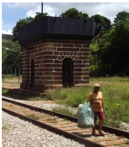
Figura 44: Caixa d'água do conjunto ferroviário de Miguel Burnier.
