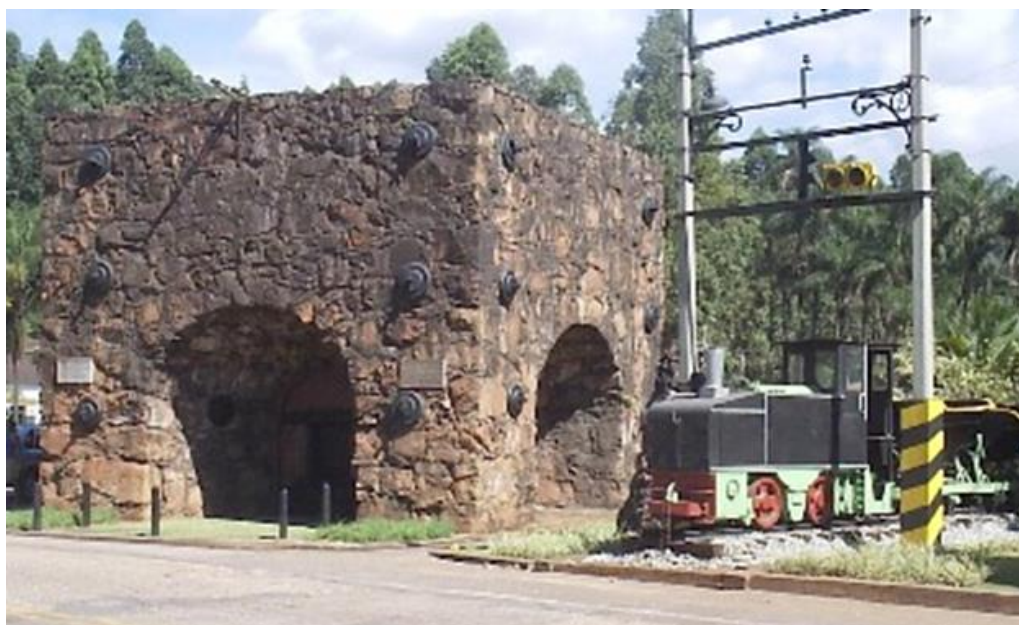
Figura 12: Remanescentes do alto-forno da Usina Esperança, Itabirito, MG.
