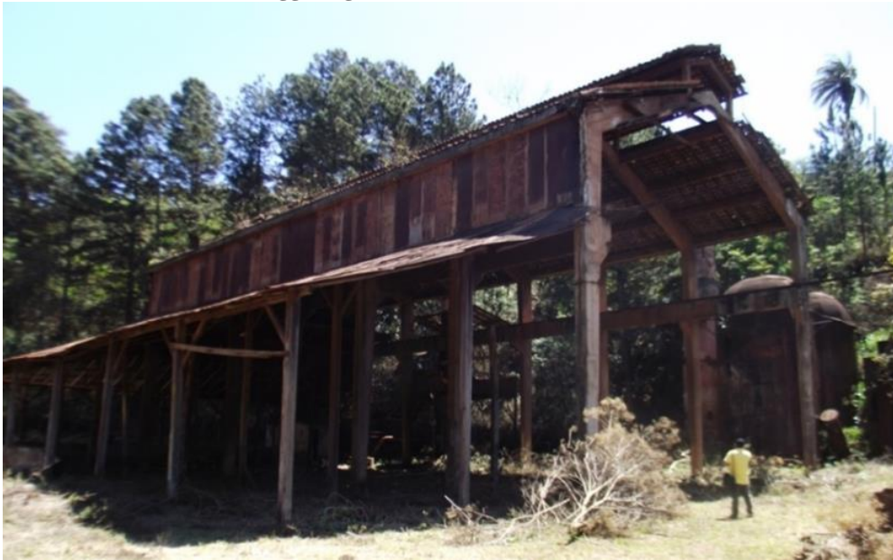
Figura 47: Detalhe do galpão constituinte do sítio arqueológico constituído pelos remanescentes do galpão e do alto-forno da Usina Wigg, Miguel Burnier.
