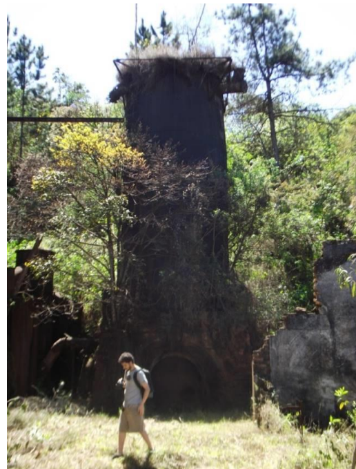
Figura 48: Detalhe do alto-forno constituinte do sítio arqueológico constituído pelos remanescentes do galpão e do alto-forno da Usina Wigg, Miguel Burnier.
