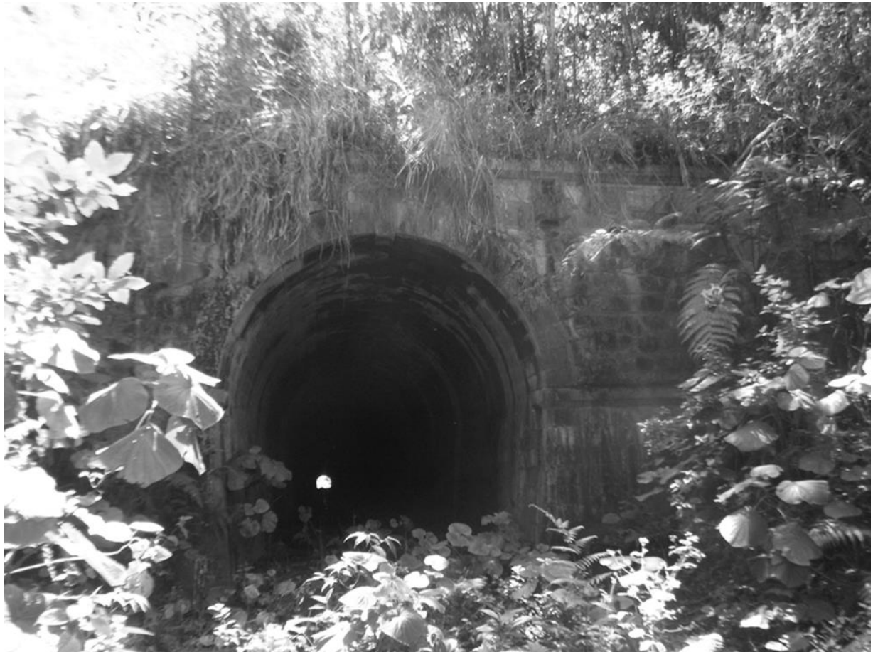
Túnel Ferroviário em Miguel Burnier, Ouro Preto, MG. Foto: Jeanne Crespo, 2014.
