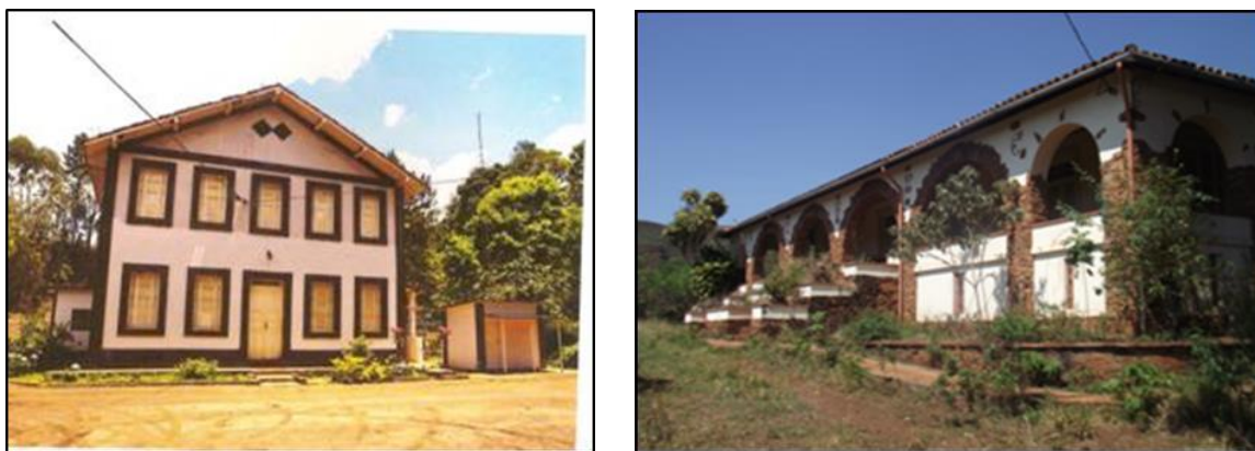
Figura 38: Antiga sede do escritório e Residência dos Engenheiros da Usina Wigg, Miguel Burnier.
