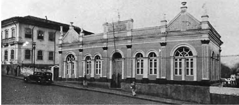
Figura 4 - Cine Vila Rica antes da restauração. Fonte: Motta, 1987.
