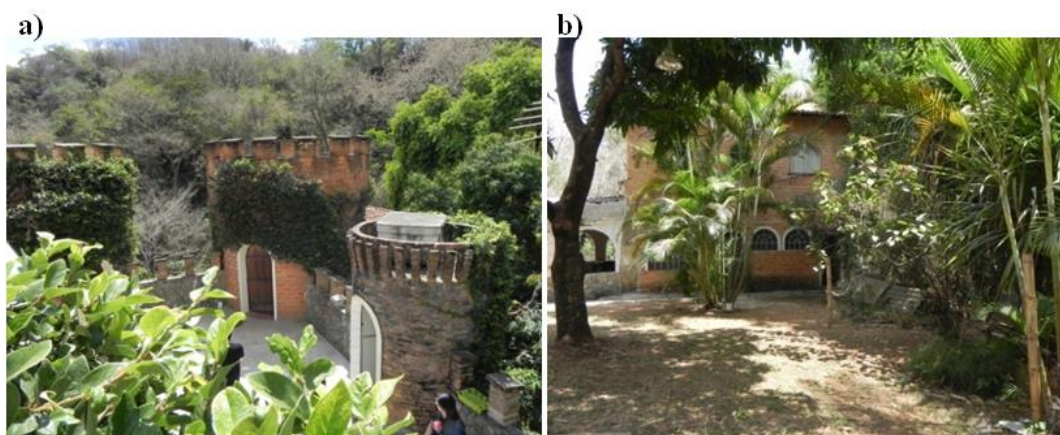
Figura 52 - O MARLS a) Segundo pavimento; b) Edifício da reserva técnica.
