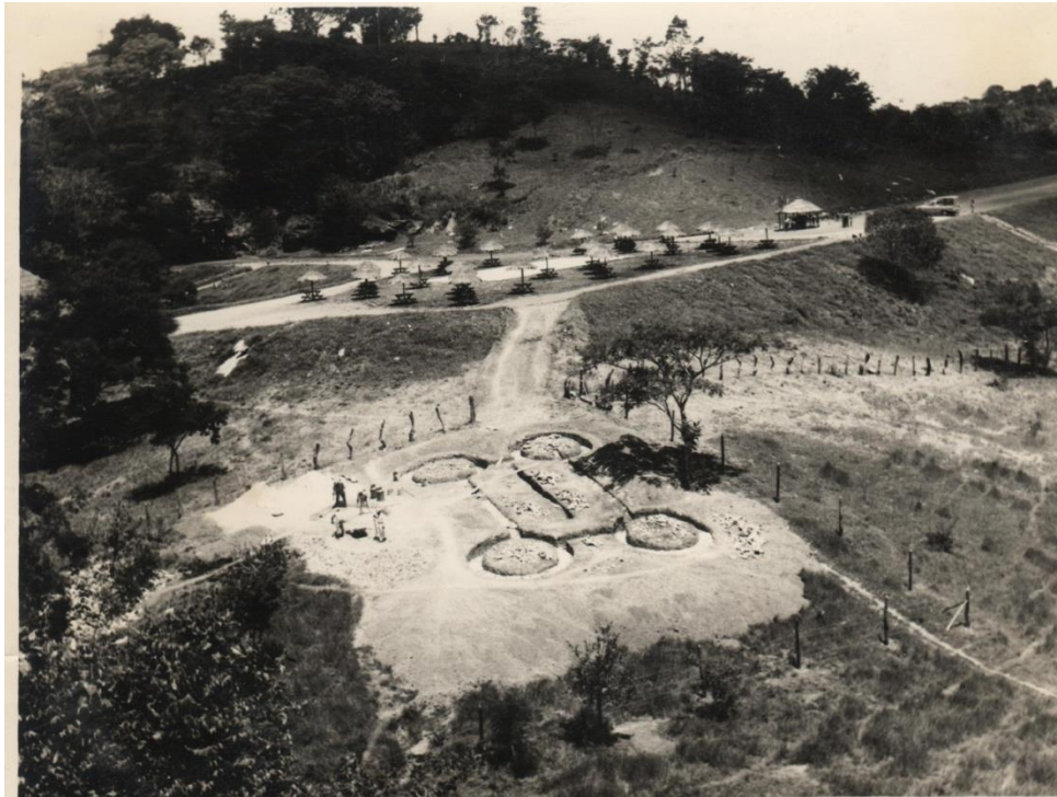
Figura 48 - Imagens da construção do MARLS.
