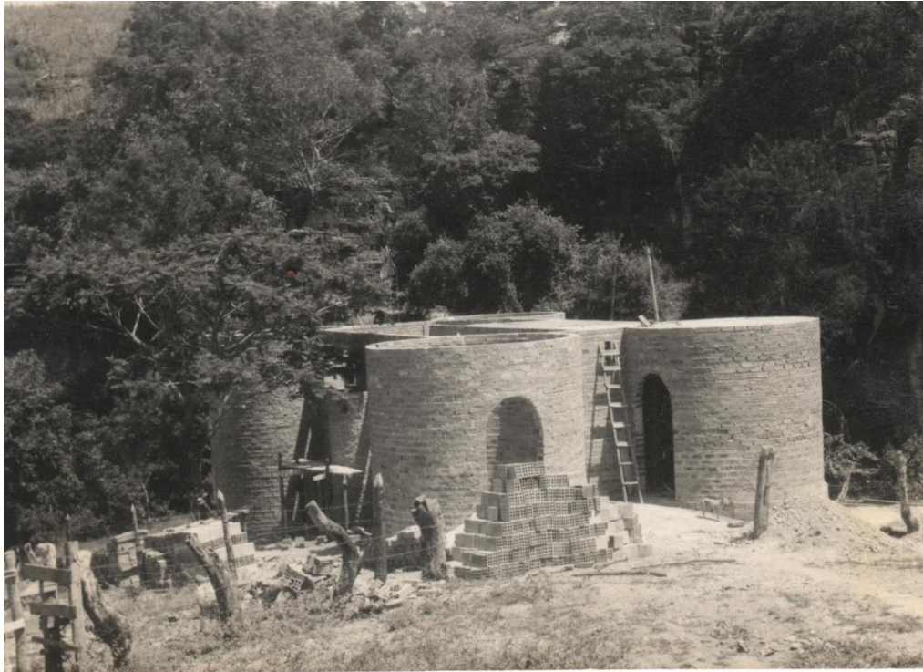
Figura 49 - Imagens da construção do MARLS.
