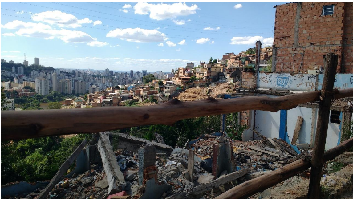
Figura 23 - Casa demolida na Vila São Bento
