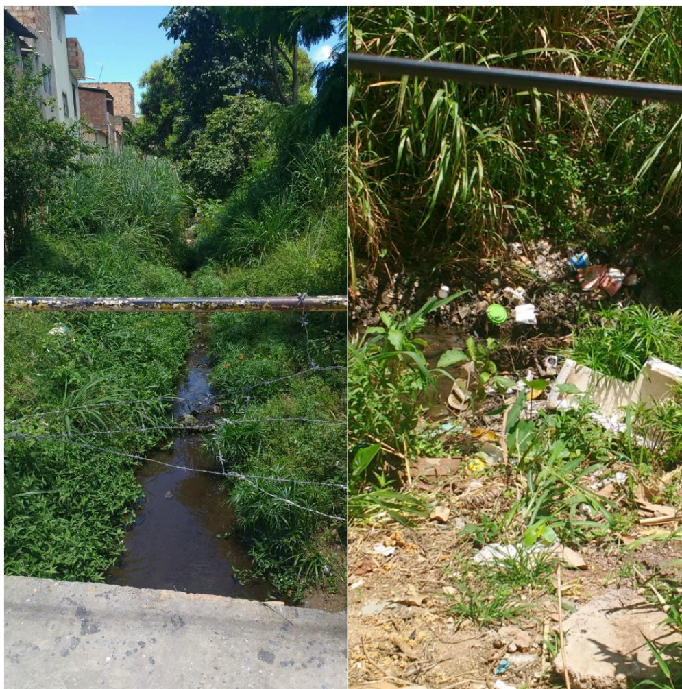
Figura 24 - Córrego do Túnel
