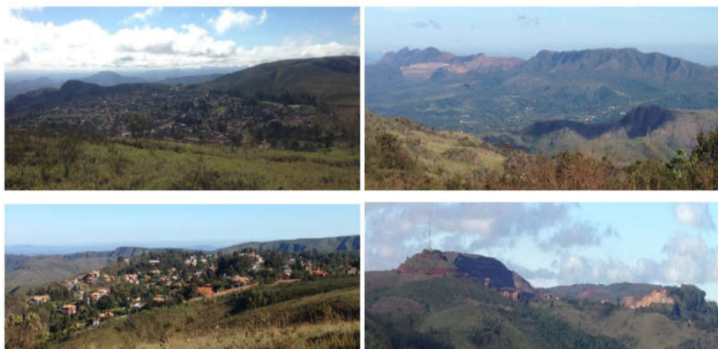
Figura 20 - Fotografias mostram assentamentos urbanos (à esquerda) e atividade minerária(à direita)
