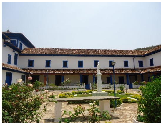
Figura 30 - Mosteiro de Macaúbas
