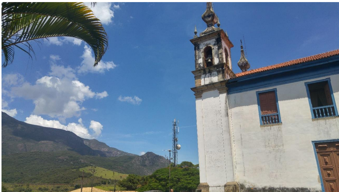
Figura 57 - Igreja Matriz de Nossa Senhora da Conceição e a torre de celular à frente da mesma
