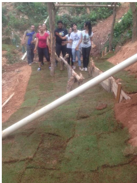
Figura 19 – Manutenção da linha de esgoto perpendicular às terraças do Pomar do Cafezal, durante o XXIV Canteiro em Obras - 2015
