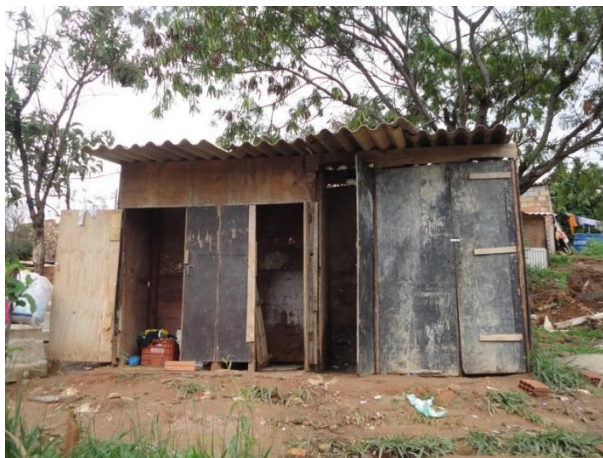
Figura 22 - Chuveiros comunitários autoconstruídos na ocupação Eliana Silva em 2012
