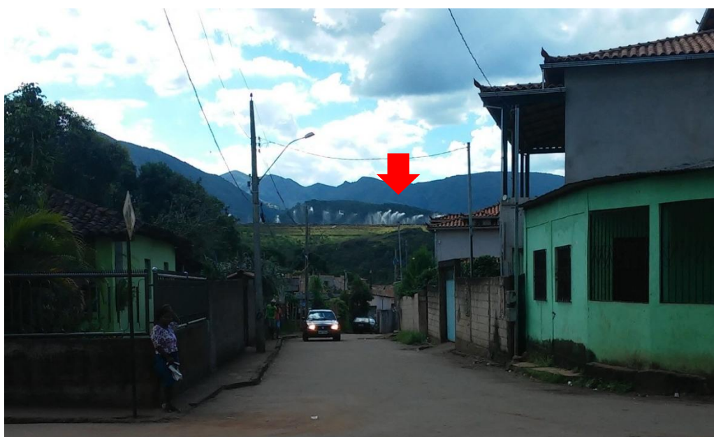
Figura 18 – Barragem de Doutor ao fundo (destaque para a cortina d'água utilizada para diminuir o impacto da poeira sobre o distrito)
