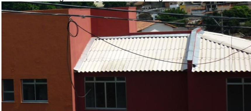
Figura 18– Cobertura de tipologia existente
