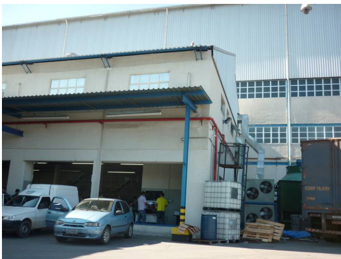
Figura 10: Vista parcial da fachada lateral
