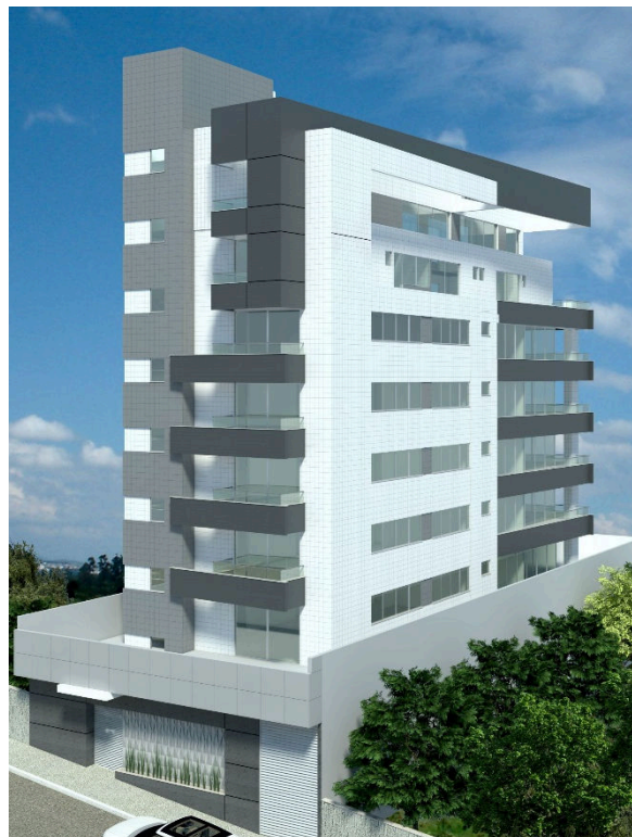
Figura 21 - Fachada Frontal (Sul) e Lateral Direita (Leste)
